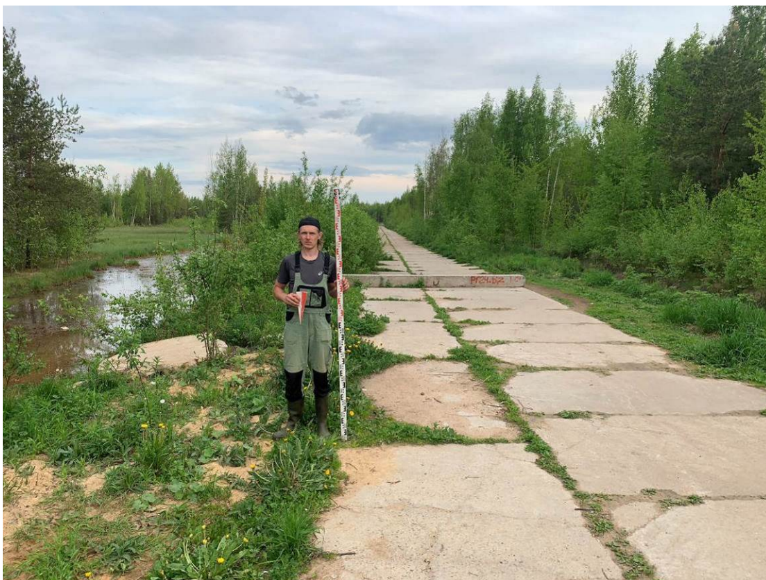
Рис. 66. Ленинградская обл., Всеволожский р-н, г. Всеволожск. Общий вид участка обследования. Точка съемки 13. Вид с С.
