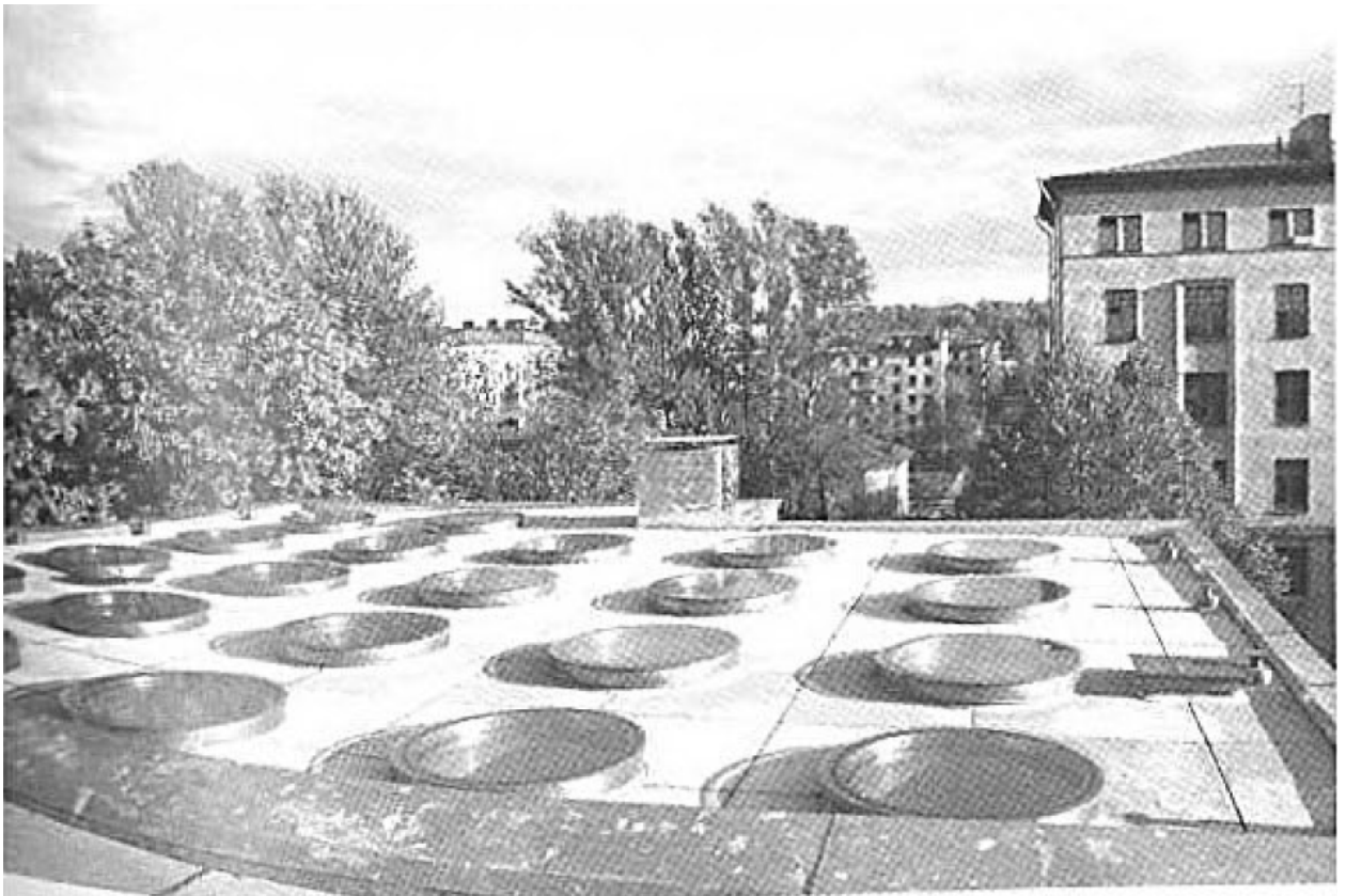
15. Крыша читального зала после ремонта в 2004 г. Неувонен П., Пеюхья Т., Мустонен Т. Выборг. Архитектурный путеводитель. СПб., 2006. С. 91.
