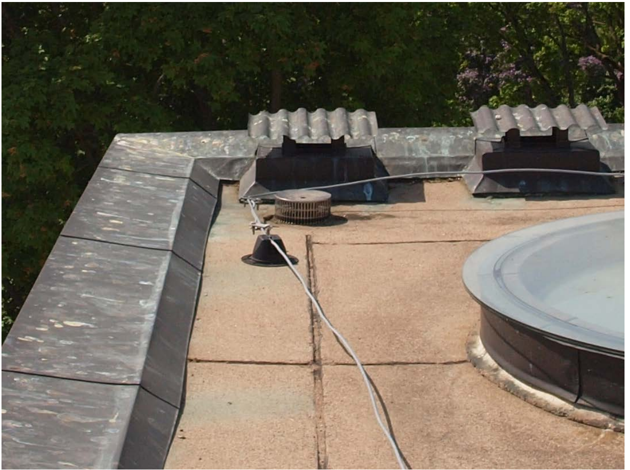
8. Кровля третьего яруса. Круглая водосточная воронка; прут громоотвода на шляповидном креплении; прямоугольные вентиляционные каналы.
