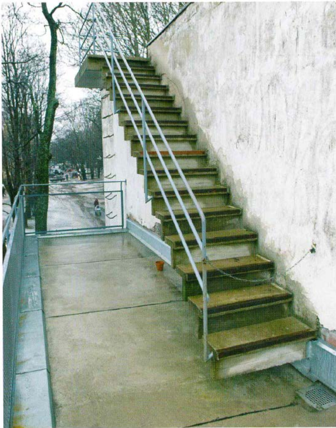
16. Терраса абонементного зала. Лестница, ведущая на крышу актового зала. Из кн.: Алвар Аалто. Карельский шедевр: сборник. - Выборг, 2008. С. 24.
