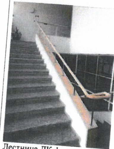
Лестница в хранилище.
