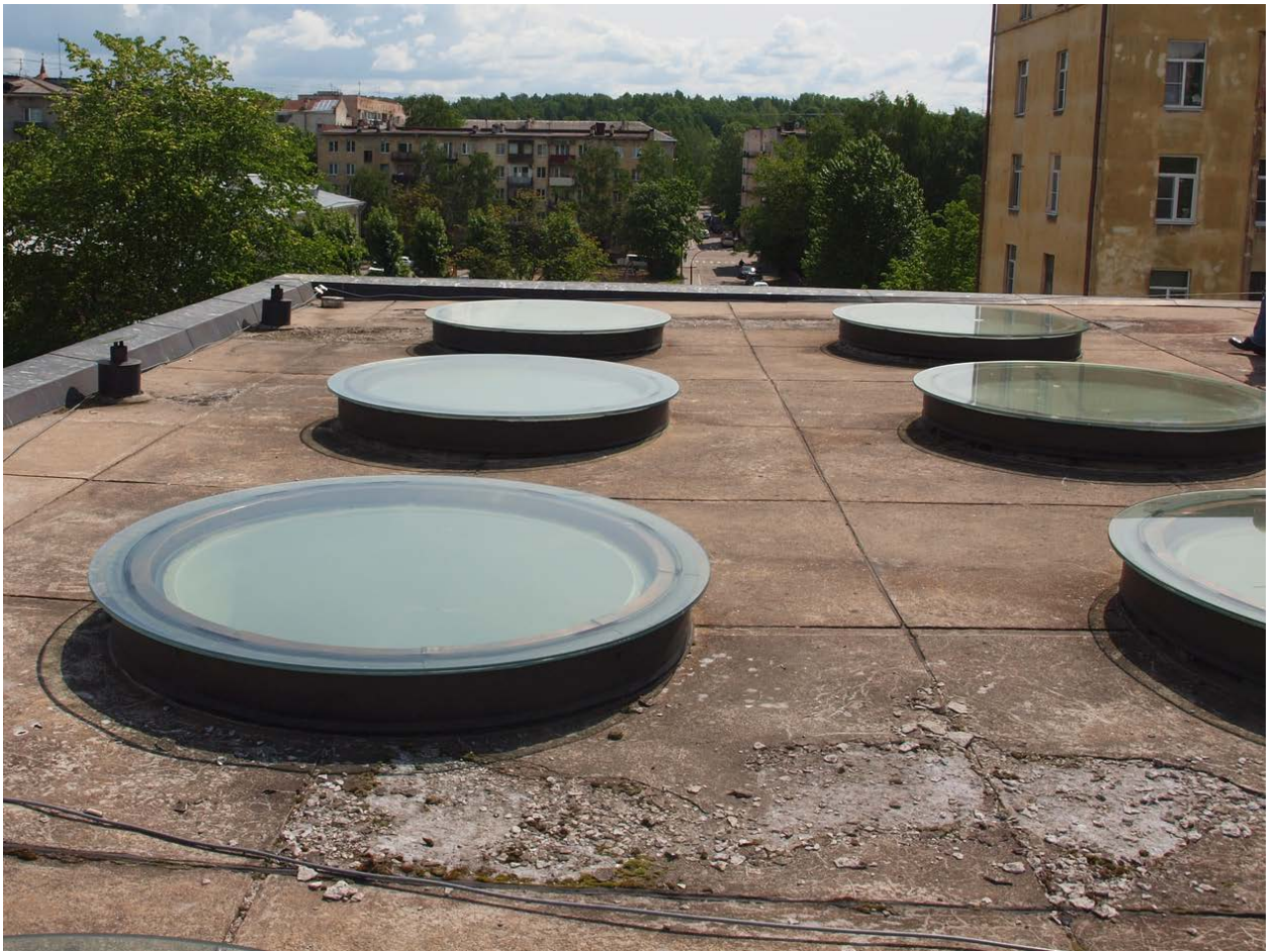
10. Кровля второго яруса. Вид на юг, в сторону пр. Суворова. Биопоражение, крошение бетона.
