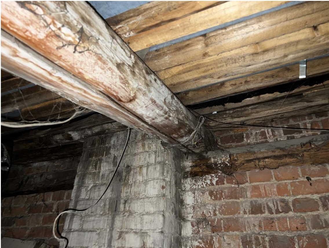
Фото 54. «Жилой флигель для рабочих с баней и конюшней». Чердак. Фрагмент юго-западной стены. Дата съемки: 25.05.2022 г. Автор съемки: Куваева Ю.П.
