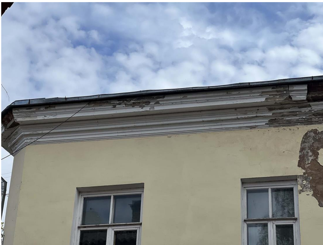
Фото 10. «Жилой дом с лавками, конторой, погребом и пекарней». Фрагмент дворового северо-западного фасада. Разрушение венчающего карниза. Дата съемки: 25.05.2022 г. Автор съемки: Куваева Ю.П.
