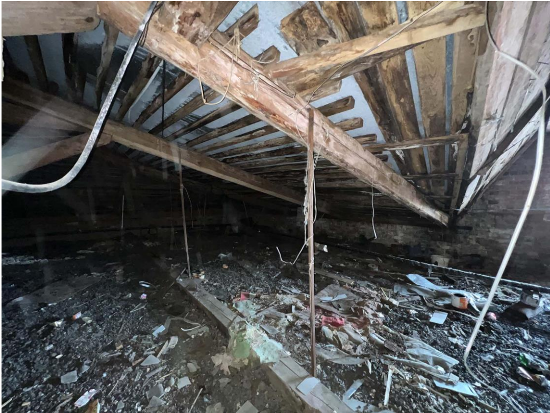
Фото 33. «Жилой дом с лавками, конторой, погребом и пекарней». Чердак. Вид на юго-восточную часть помещения. Дата съемки: 25.05.2022 г. Автор съемки: Куваева Ю.П.
