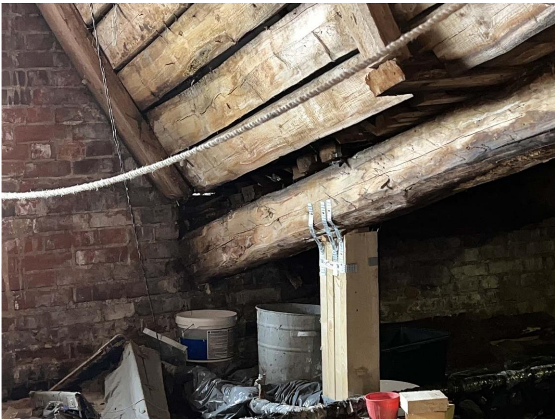
Фото 29. «Жилой дом с лавками, конторой, погребом и пекарней». Чердак. Фрагмент конструкции стропильной системы с правой стороны аттика. Дата съемки: 25.05.2022 г. Автор съемки: Куваева Ю.П.
