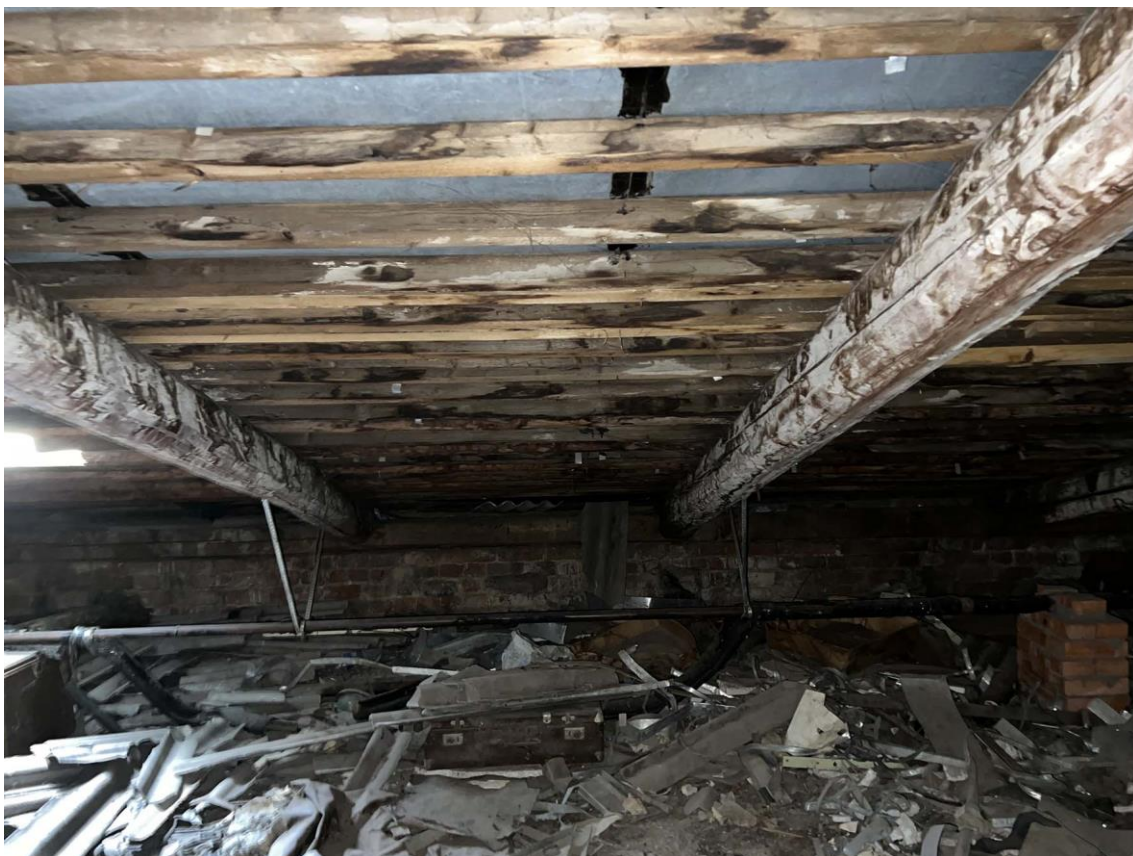
Фото 53. «Жилой флигель для рабочих с баней и конюшней». Чердак. Фрагмент северо-восточного ската. Дата съемки: 25.05.2022 г. Автор съемки: Куваева Ю.П.
