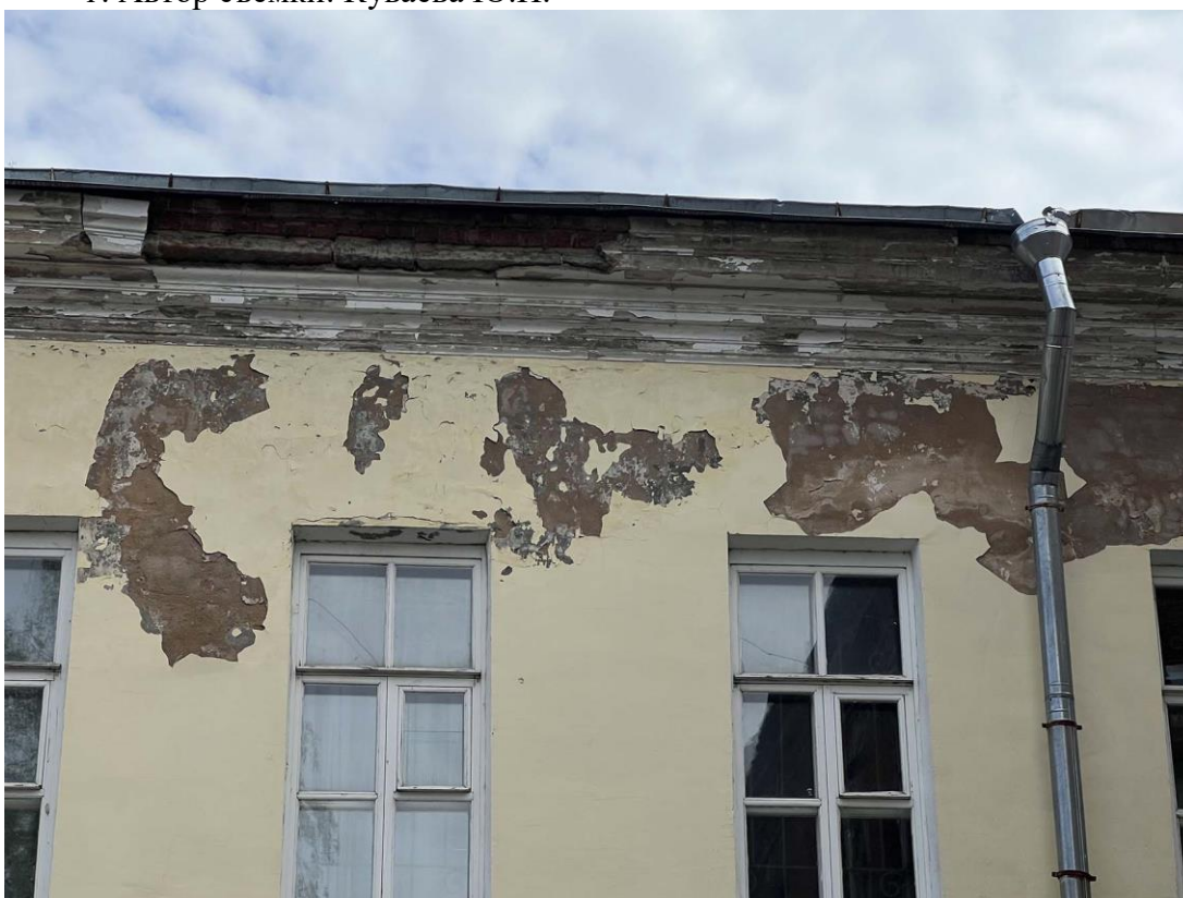
Фото 10. «Жилой дом с лавками, конторой, погребом и пекарней». Фрагмент дворового северо-западного фасада. Разрушение венчающего карниза. Дата съемки: 25.05.2022 г. Автор съемки: Куваева Ю.П.
