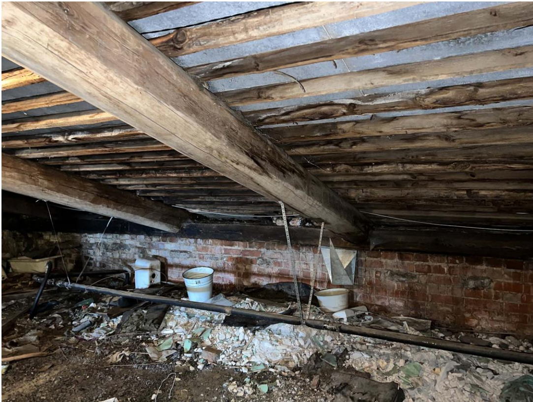
Фото 42. «Жилой дом с лавками, конторой, погребом и пекарней». Чердак. Фрагмент северо-западного ската. Дата съемки: 25.05.2022 г. Автор съемки: Куваева Ю.П.
