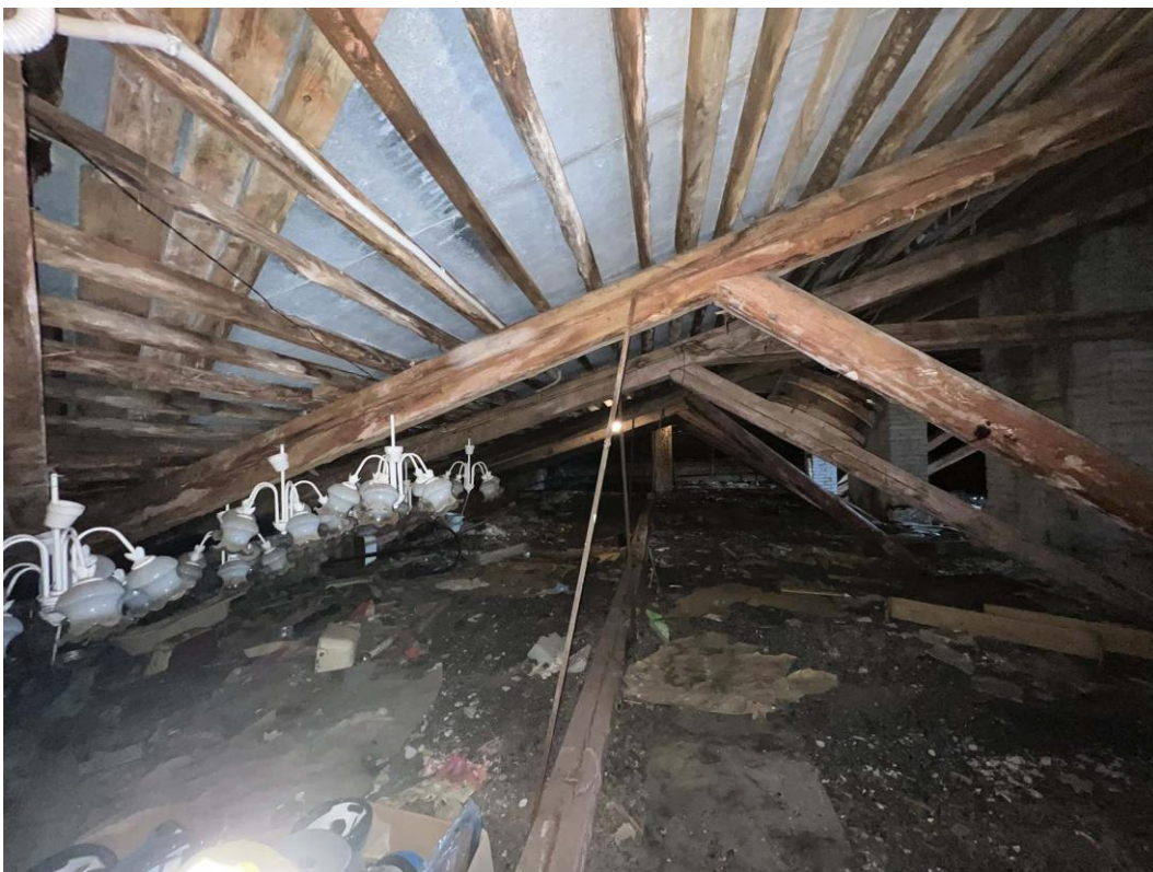
Фото 19. «Жилой дом с лавками, конторой, погребом и пекарней». Чердак. Вид на северо-западный скат крыши с юго-запада. Дата съемки: 25.05.2022 г. Автор съемки: Куваева Ю.П.
