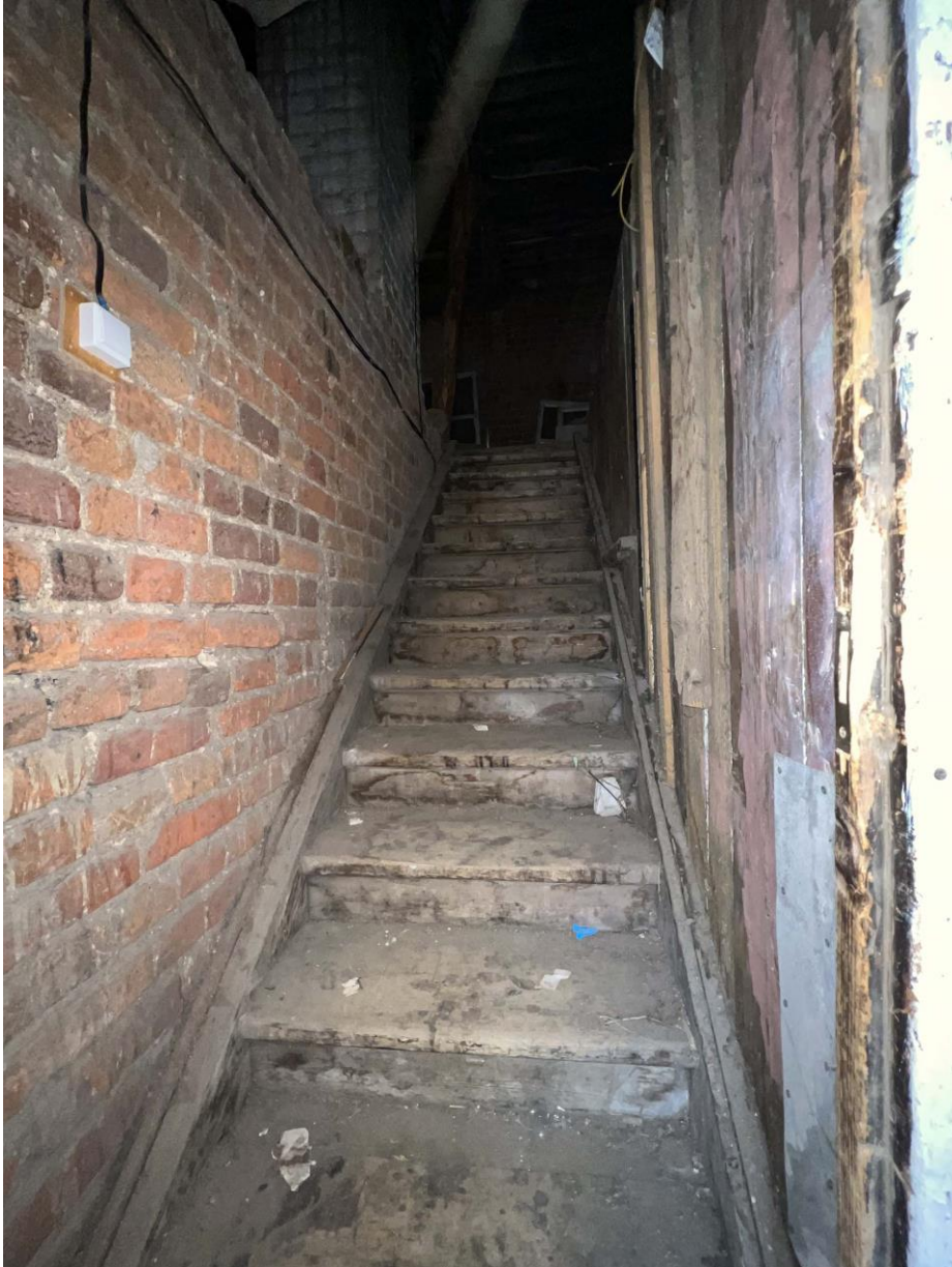
Фото 45. «Жилой флигель для рабочих с баней и конюшней». Чердак. Деревянная лестница входа в чердак. Фото с северо-востока. Дата съемки: 25.05.2022 г. Автор съемки: Куваева Ю.П.
