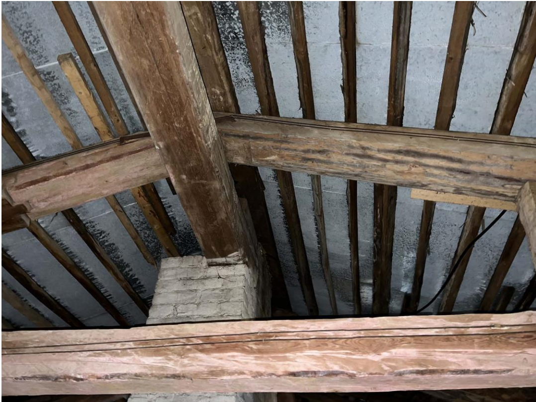
Фото 25. «Жилой дом с лавками, конторой, погребом и пекарней». Чердак. Фрагмент конструкции стропильной системы. Дата съемки: 25.05.2022 г. Автор съемки: Куваева Ю.П.
