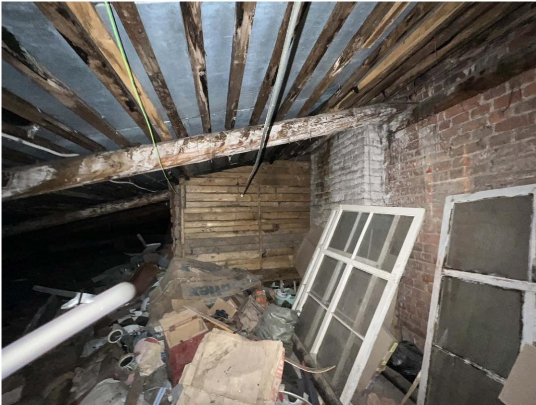
Фото 50. «Жилой флигель для рабочих с баней и конюшней». Чердак. Центральная юго-западная часть помещения. Фото с северо-запада. Дата съемки: 25.05.2022 г. Автор съемки: Куваева Ю.П.
