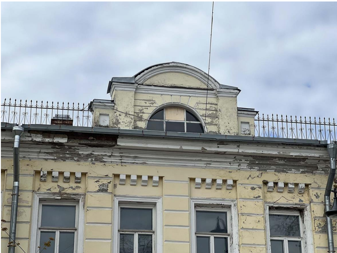
Фото 9. «Жилой дом с лавками, конторой, погребом и пекарней». Фрагмент юго-восточного фасада. Атик. Дата съемки: 25.05.2022 г. Автор съемки: Куваева Ю.П.
