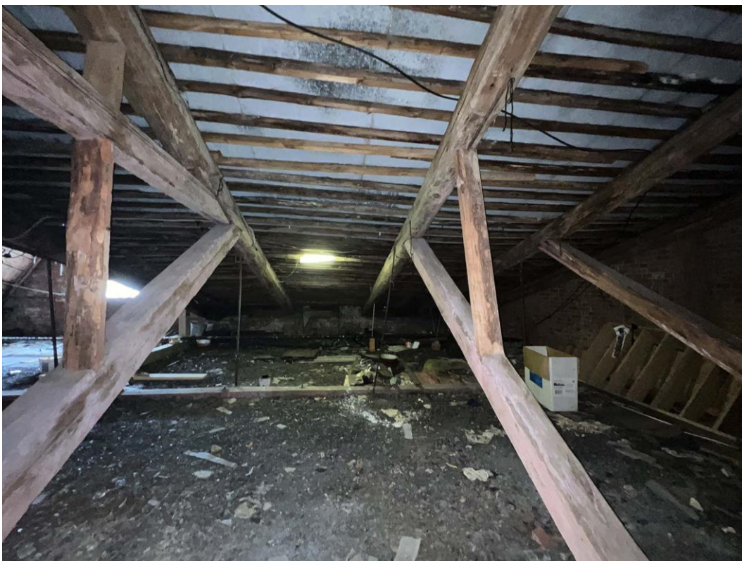
Фото 23. «Жилой дом с лавками, конторой, погребом и пекарней». Чердак. Вид на уличный юго-восточный скат с северо-запада. Дата съемки: 25.05.2022 г. Автор съемки: Куваева Ю.П.
