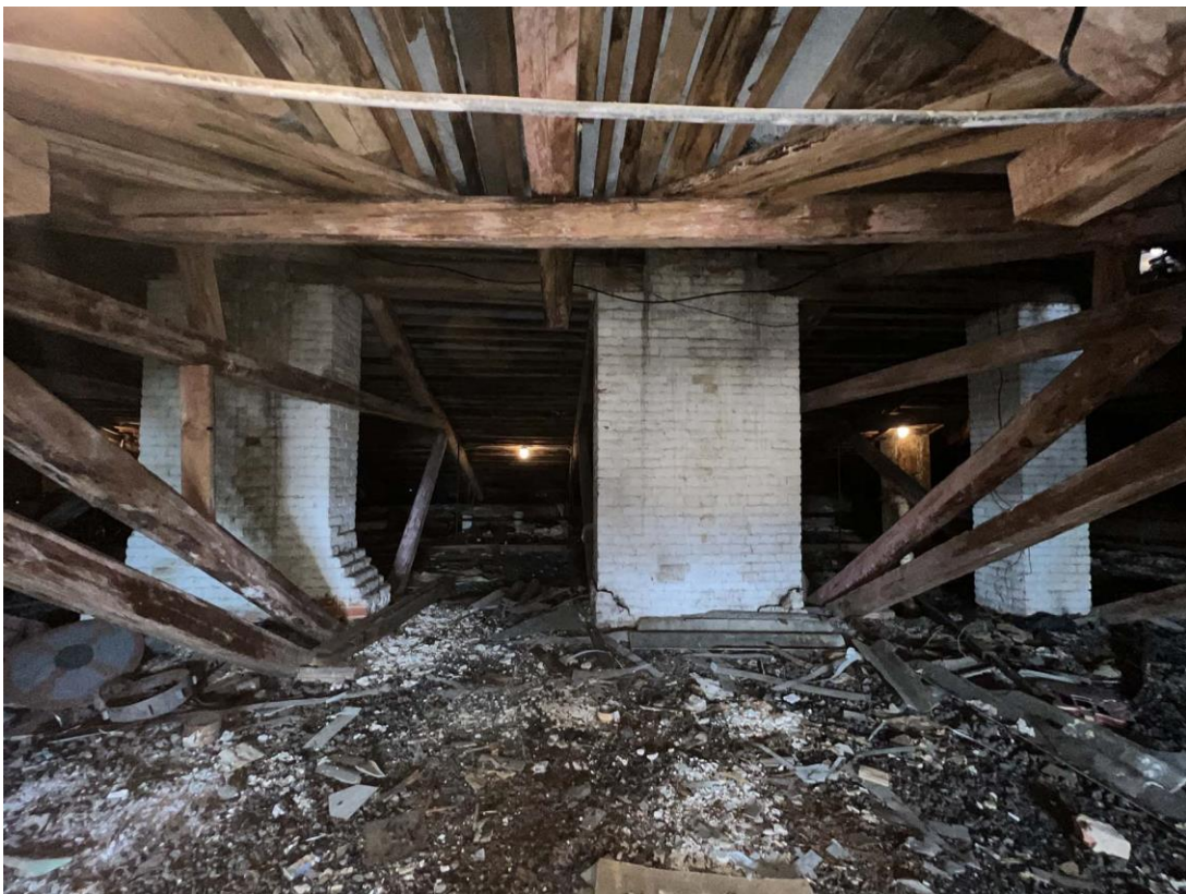
Фото 31. «Жилой дом с лавками, конторой, погребом и пекарней». Чердак. Центральная часть помещения. Фото с юго-востока. Дата съемки: 25.05.2022 г. Автор съемки: Куваева Ю.П.
