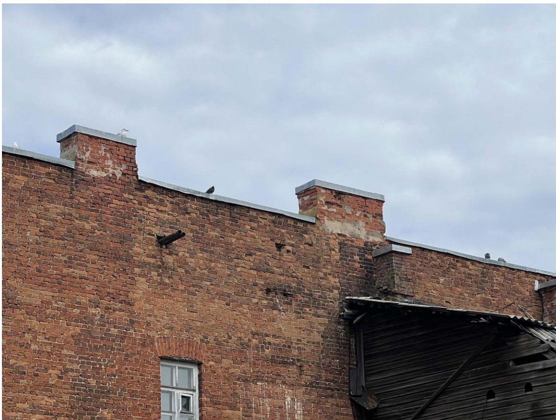
Фото 15. «Жилой флигель для рабочих с баней и конюшней». Фрагмент юго-западной стены. Дата съемки: 25.05.2022 г. Автор съемки: Куваева Ю.П.
