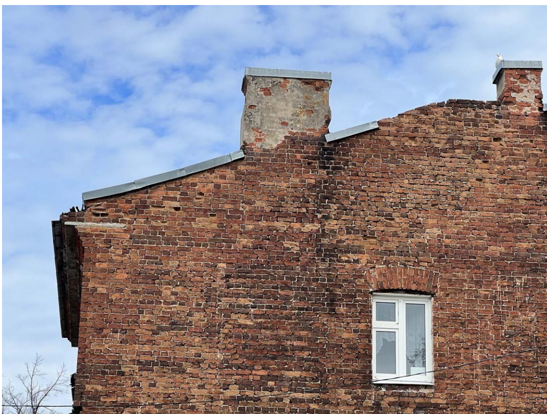
Фото 13. «Жилой флигель для рабочих с баней и конюшней». Фрагмент юго-западной стены. Дата съемки: 25.05.2022 г. Автор съемки: Куваева Ю.П.
