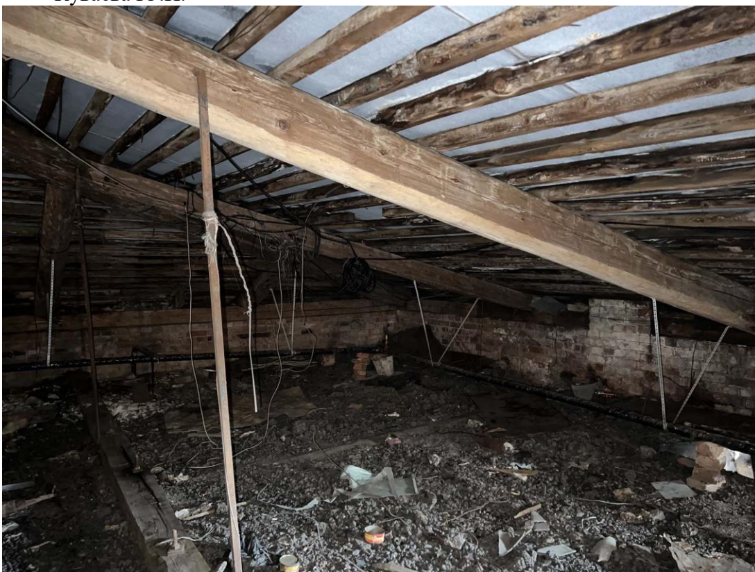
Фото 35. «Жилой дом с лавками, конторой, погребом и пекарней». Чердак. Вид на восточную часть помещения с запада. Дата съемки: 25.05.2022 г. Автор съемки: Куваева Ю.П.
