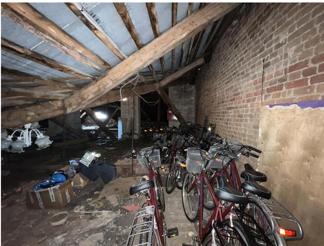
Фото 17. «Жилой дом с лавками, конторой, погребом и пекарней». Вид на юго-западную часть помещения с северо-запада. Чердак. Дата съемки: 25.05.2022 г. Автор съемки: Куваева Ю.П.
