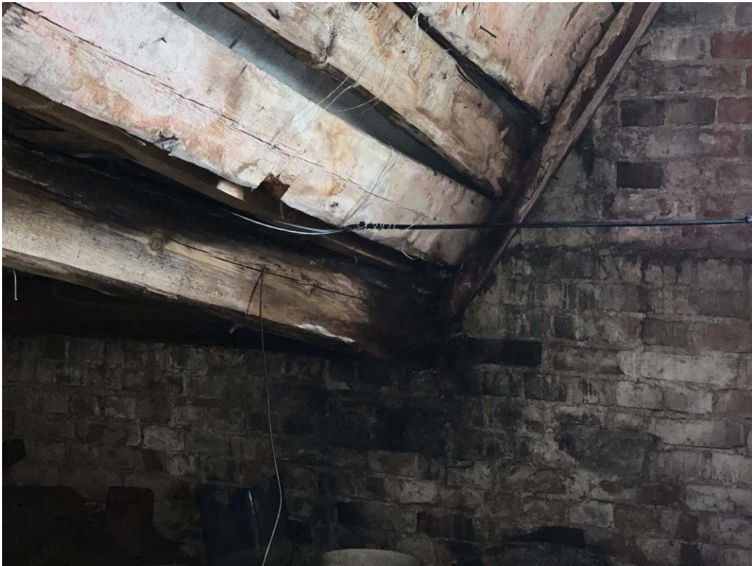
Фото 30. «Жилой дом с лавками, конторой, погребом и пекарней». Чердак. Фрагмент конструкций стропильной системы с левой стороны аттика. Дата съемки: 25.05.2022 г. Автор съемки: Куваева Ю.П.
