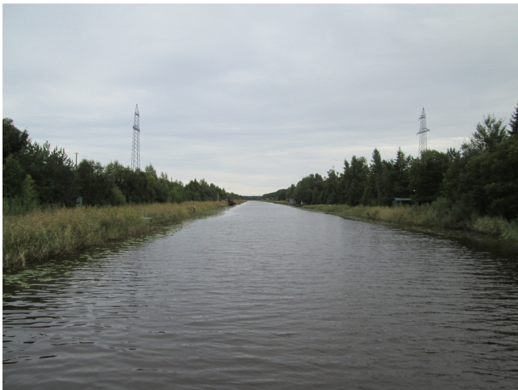
Илл. 42. Ленинградская обл., Волховский р-н. ОКН «Новосясский канал (б. канал Императрицы Марии Федоровны)». Точка фотофиксации Ф10. Вид с юго-запада на русло канала, д. Немятово 1.
