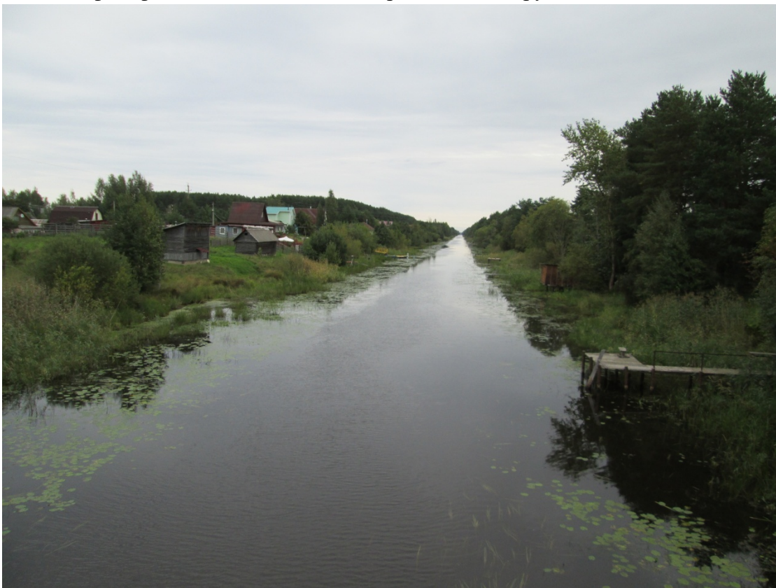
Илл. 44. Ленинградская обл., Волховский р-н. ОКН «Сясьский канал (б. канал Екатерины II)». Точка фотофиксации Ф11. Вид с юго-запада на русло канала, д. Немятово 2.
