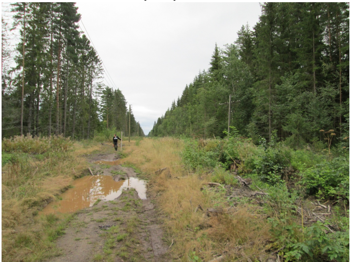
Илл. 28. Ленинградская обл., Волховский р-н. ОКН «Сясьский канал (б. канал Екатерины II)», южный берег. Точка фотофиксации Ф4. Вид с юго-запада на трассу проектирования.
