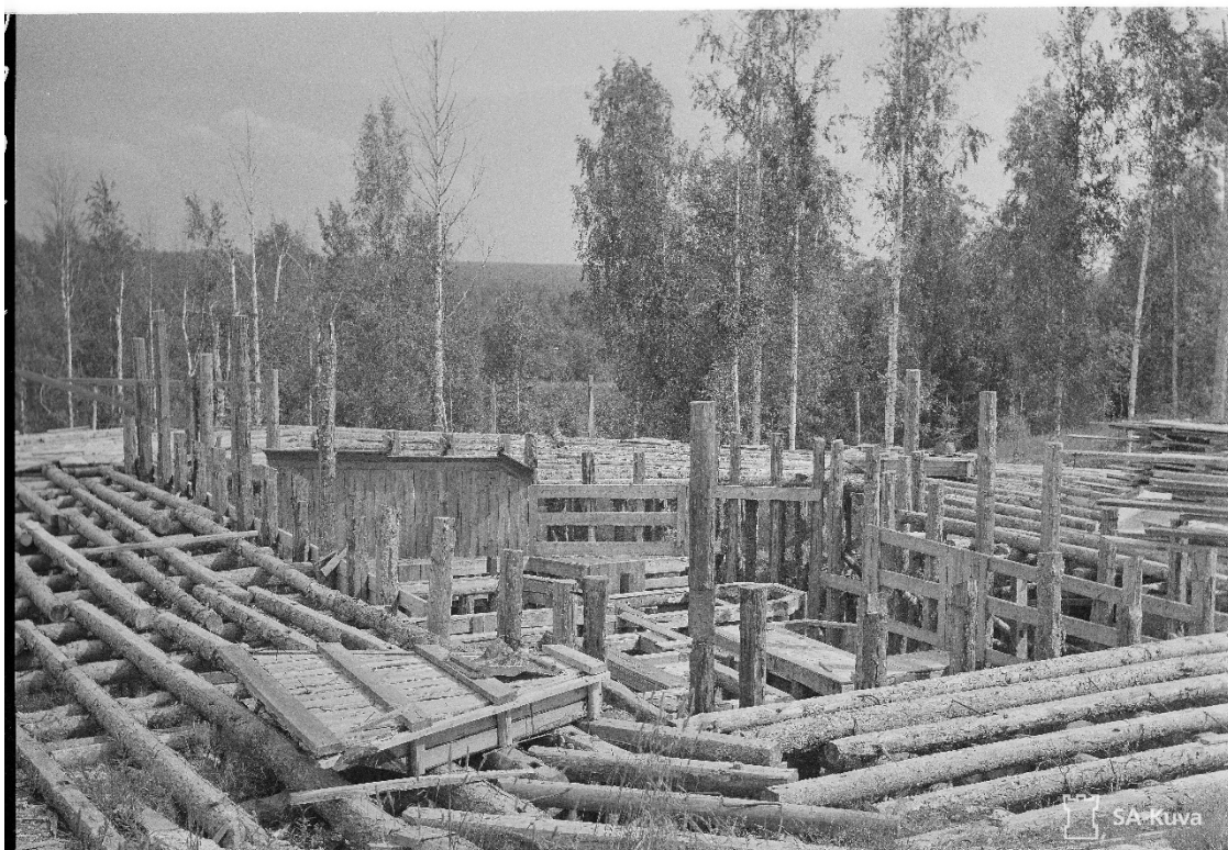
Опалубка советского ДОТ, так и оставшегося недостроенным. Высота Кумури под Сортавалой. Фотография сделана финским военным корреспондентом в 1943 году.
