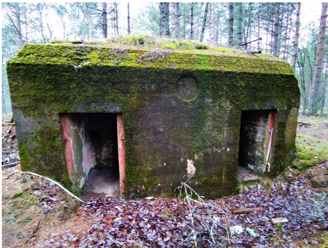
1. Вид на сооружение с тыла. ДОТ № 633.
