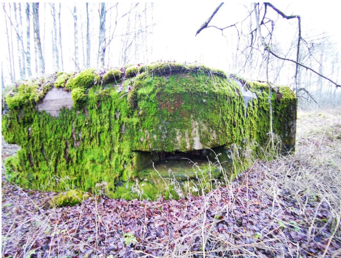
3. Вид на сооружение с угла. ДОТ № 627.
