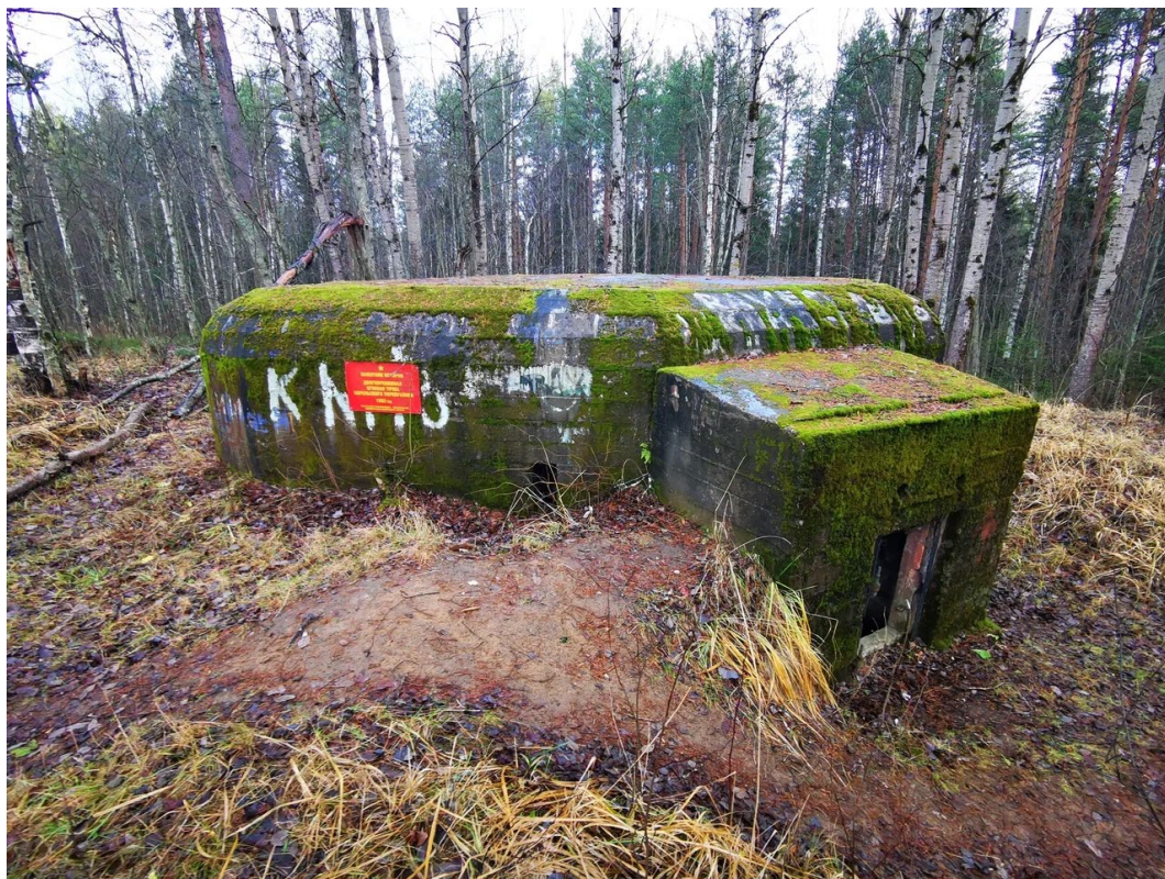
2. Вход в сооружение
