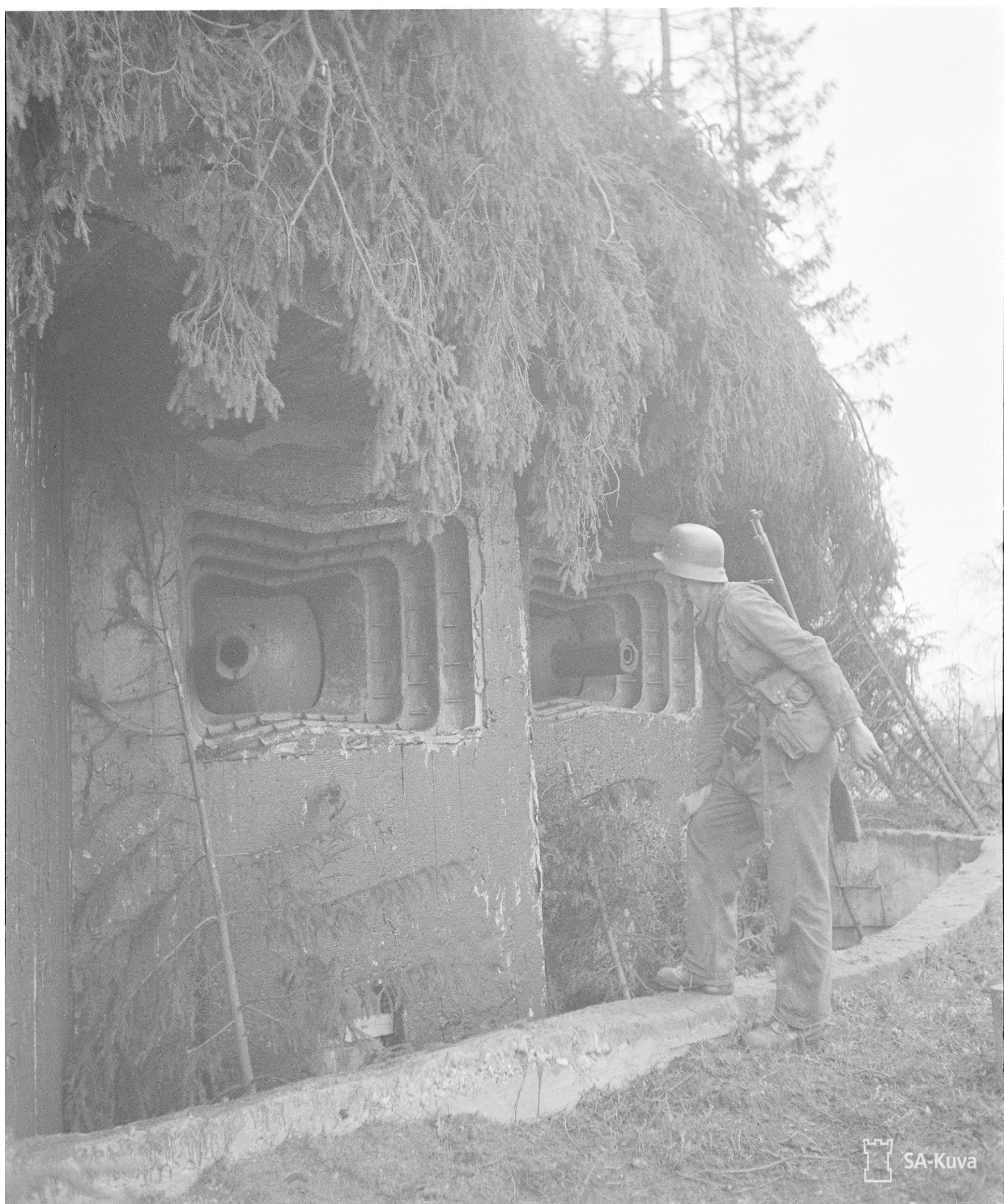
Советский полукапонир на два орудия Л-17 под Светогорском, 1941 год. Фото сделано финскими военными корреспондентами.
