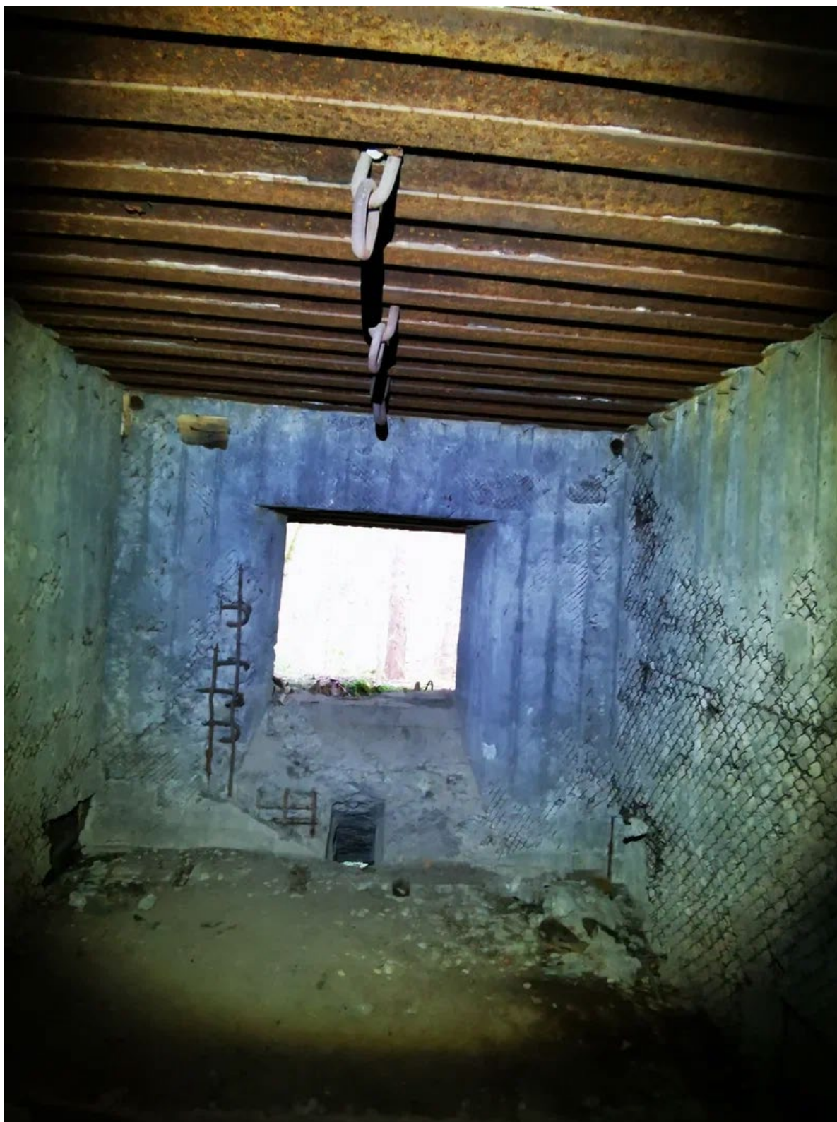
6. Боевой каземат для 76,2 мм орудия, противооткольное покрытие потолка из швеллеров и кольца для монтажа орудия. Фото: 08.11.21
