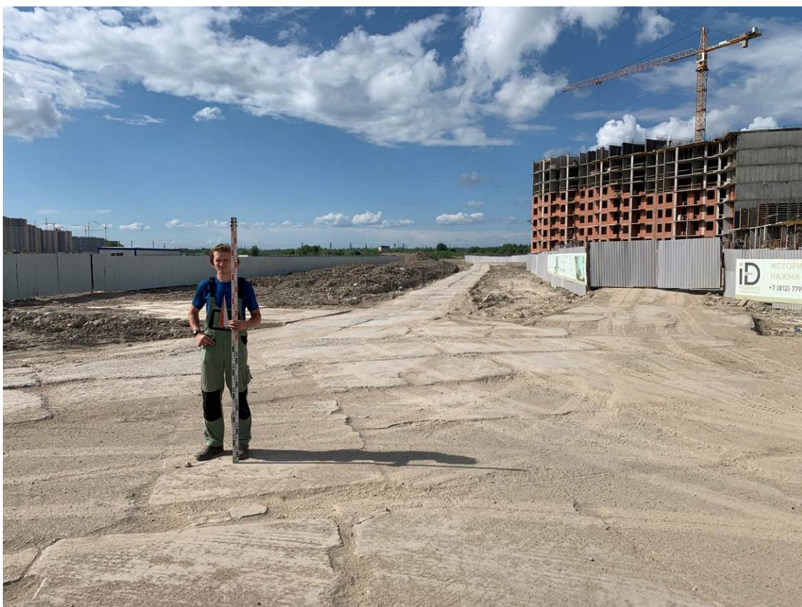
Илл. 32. Ленинградская обл., Всеволожский р-н, Муринское городское поселение. Общий вид участка обследования. Точка съемки 9. Вид с ЮЮВ.
