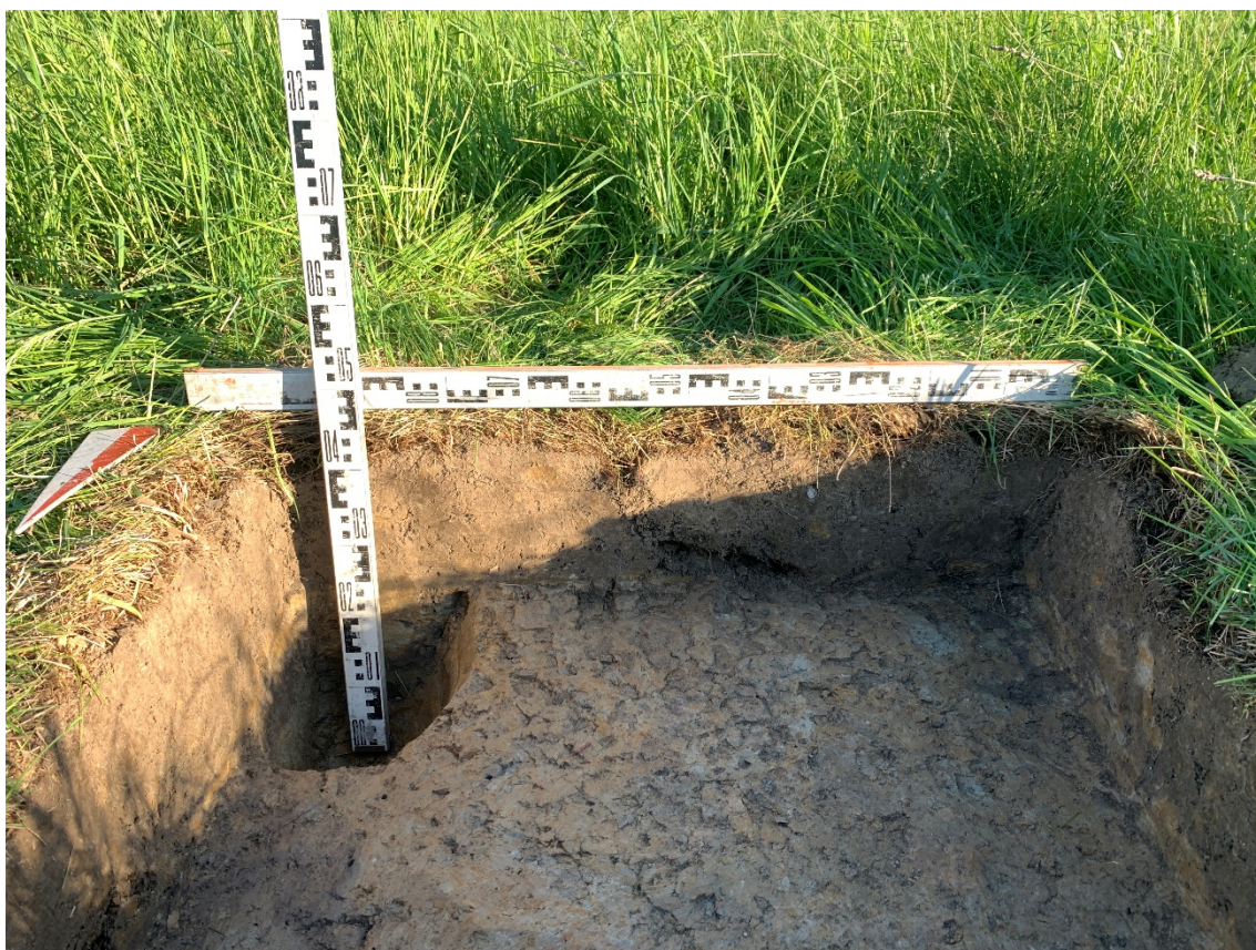
Илл. 99. Ленинградская обл., Всеволожский р-н, Муринское городское поселение. Шурф 5. Ю стенка.
