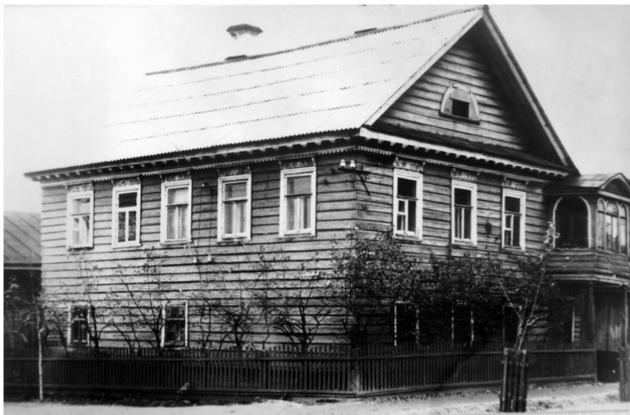
Илл. 6. Дом по Новгородской ул., 40. Фото из техпаспорта 1956 г. Архив Комитета по сохранению культурного наследия Ленинградской области
