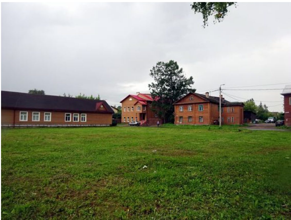
4. Участок б. домов 38 и 40 по ул. Новгородской. Вид с северо-востока. Фото 29.07.2022.
