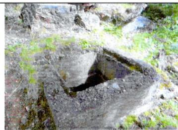
Фундамент казармы № 2\*: исторические местоположение, конфигурация в плане, габариты, материал (гранитные блоки «рваной» фактуры);
