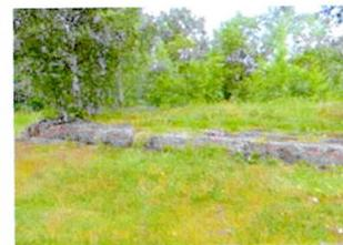
Фундамент конюшни № 1: исторические местоположение, конфигурация в плане, габариты, материал (гранитные блоки «рваной» фактуры);
