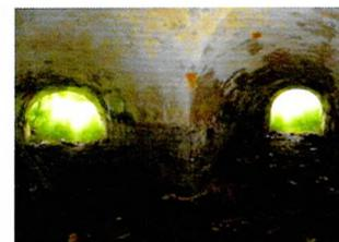
Исторические перекрытия цокольного этажа казармы № 1 - плоские по металлическим балкам с бетонным заполнением;
