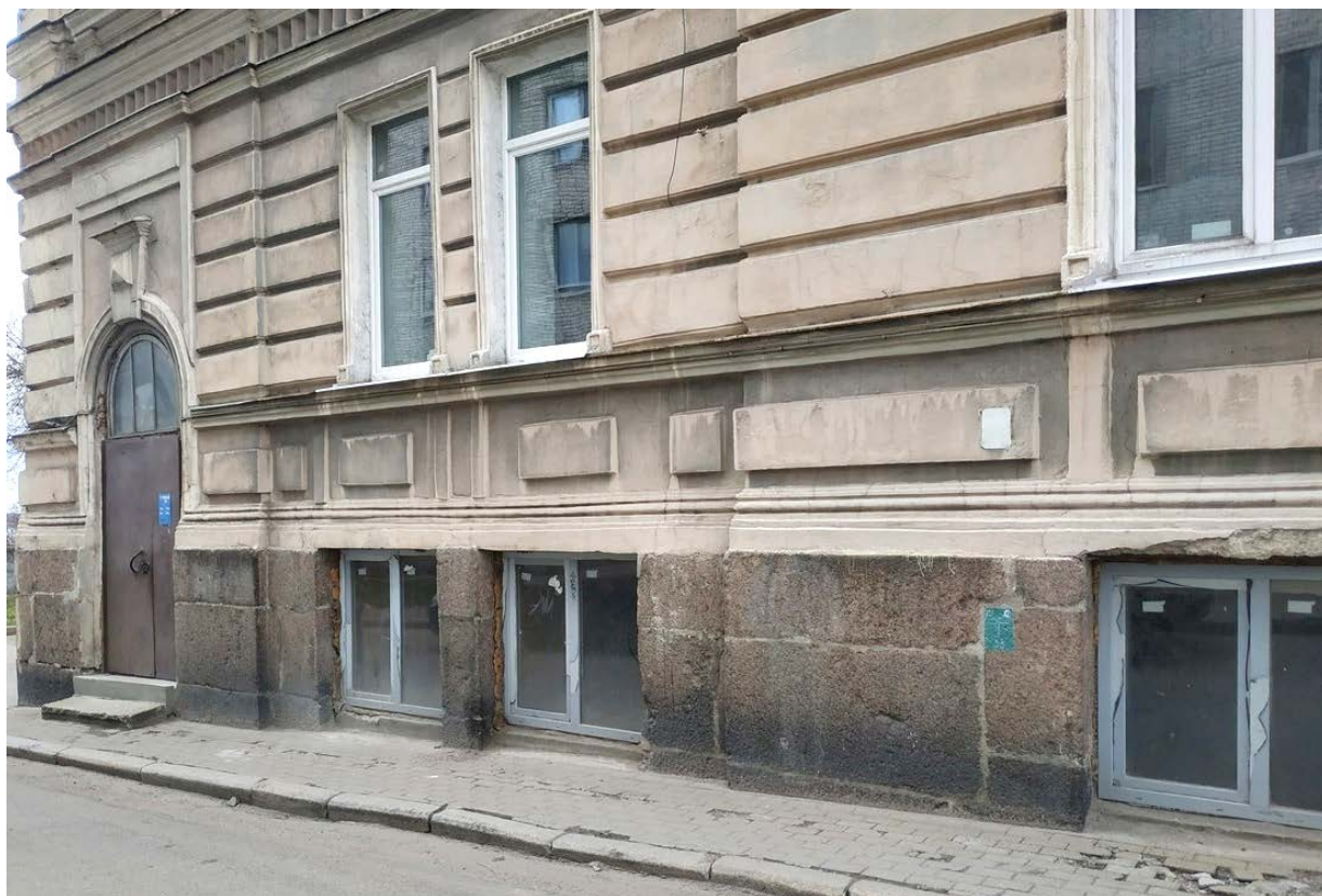
9. Фрагмент фасада по ул. Новой заставы. Поздние металлопластиковые заполнения проёмов помещения 1-Н.
