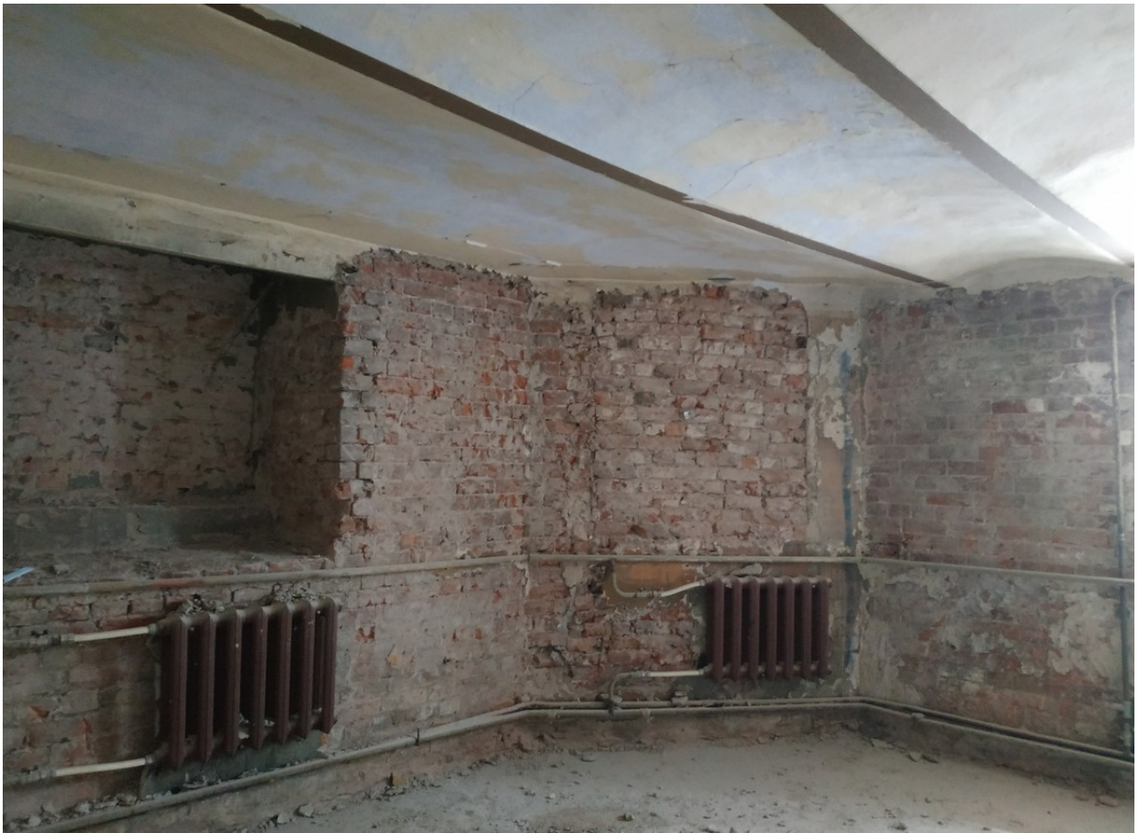
21. Помещение №1 (угловое). Заложенные исторические проёмы: оконный и дверной.
