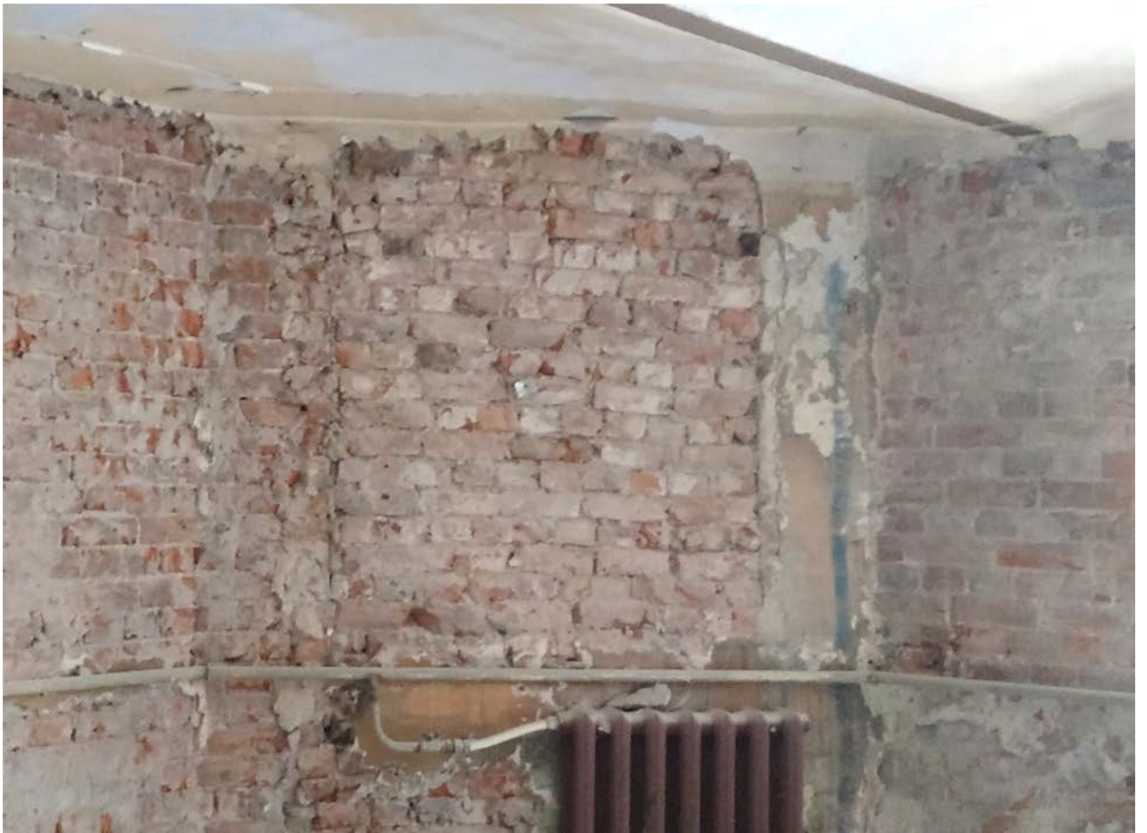
22. Заложенный исторический дверной проём в угловой ясти здания.
