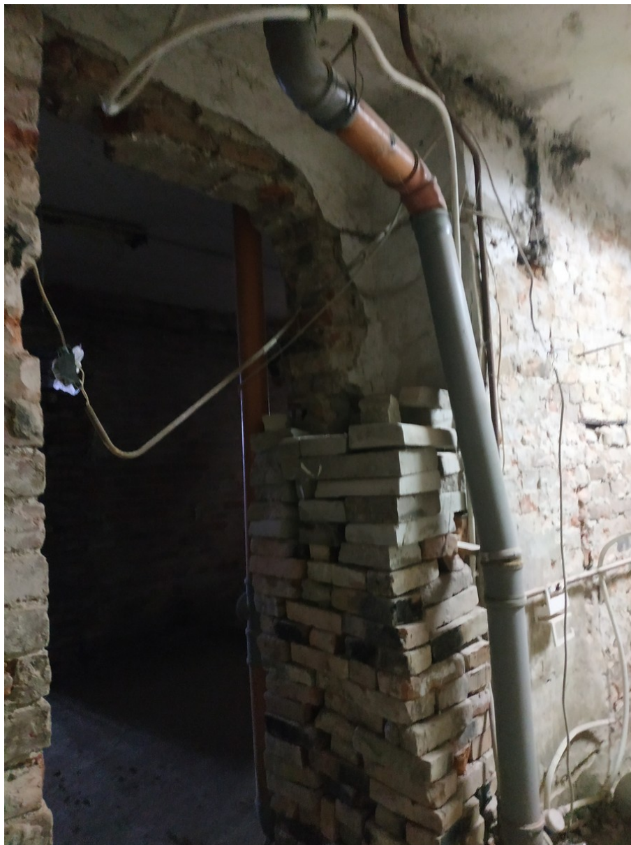
33. Дверной проём между помещениями 4 и 5. Частичная закладка.
