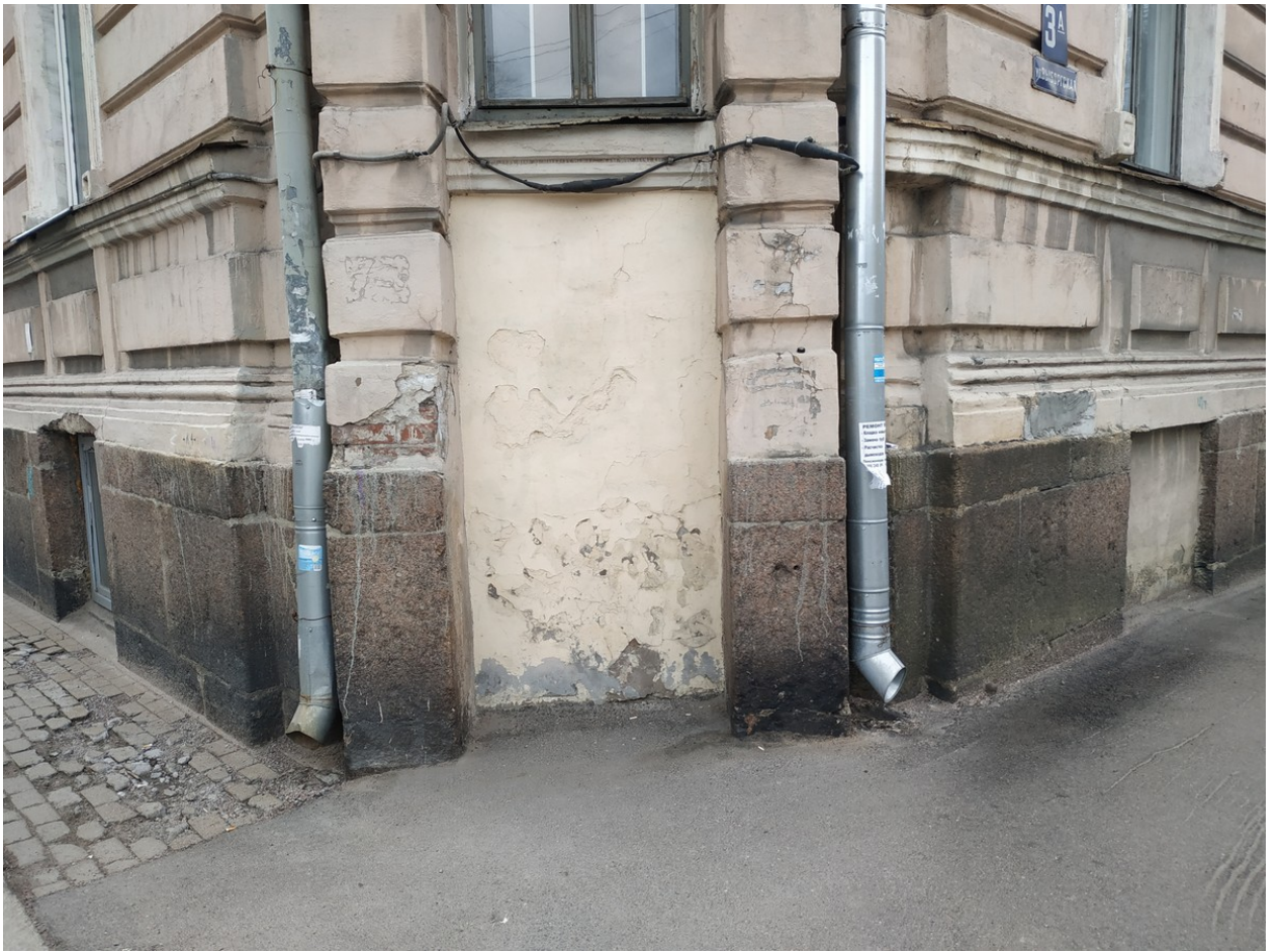
2. Заложенный входной проём в уровне цоколя.
