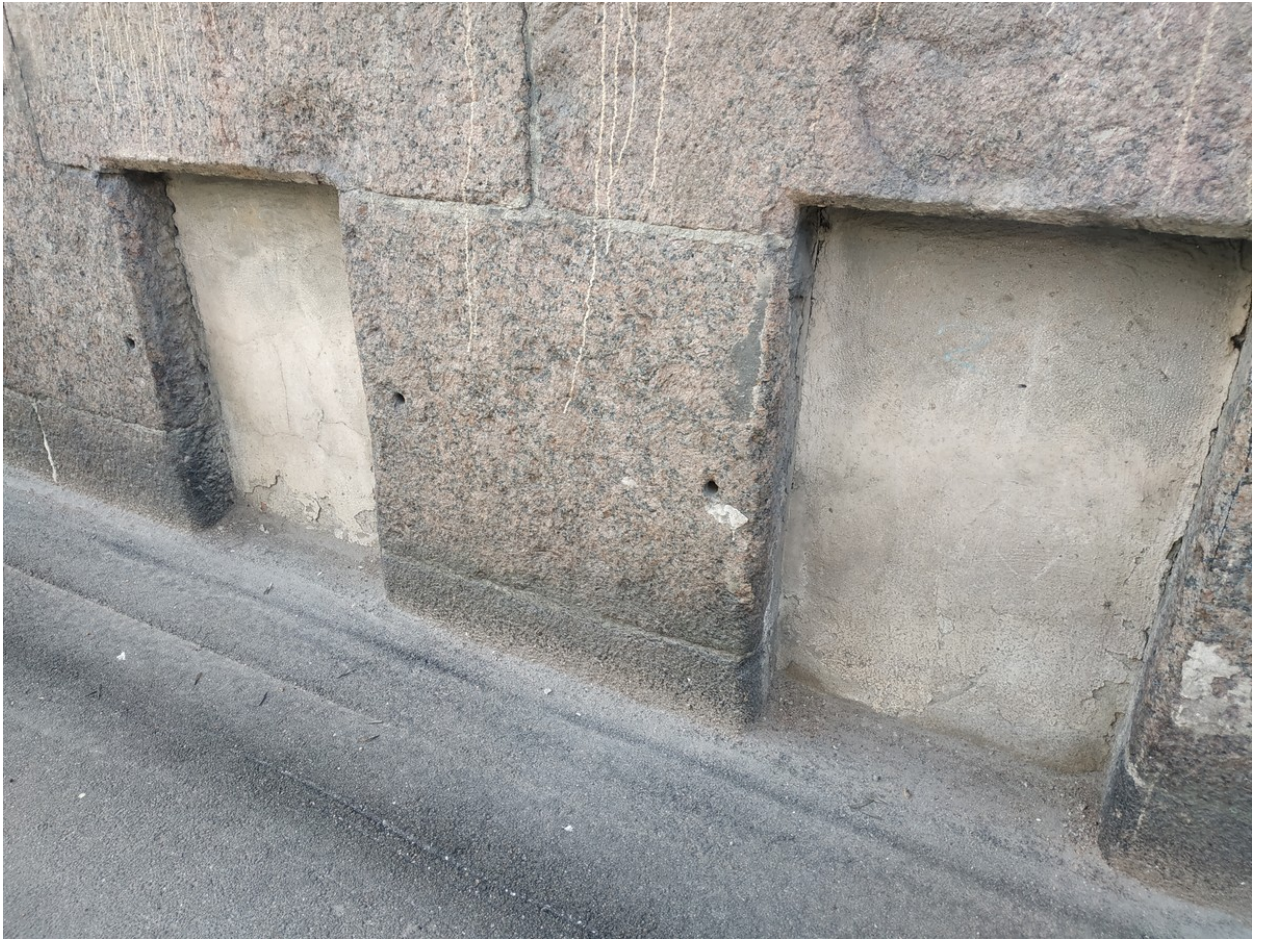
7. Следы крепления ограждения оконных проёмов, фасад по Выборгской ул.
