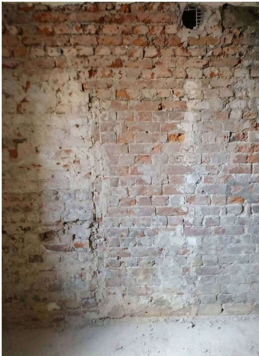
24. Заложенный проём и вентиляционное отверстие во внутренней стене помещения 1.
