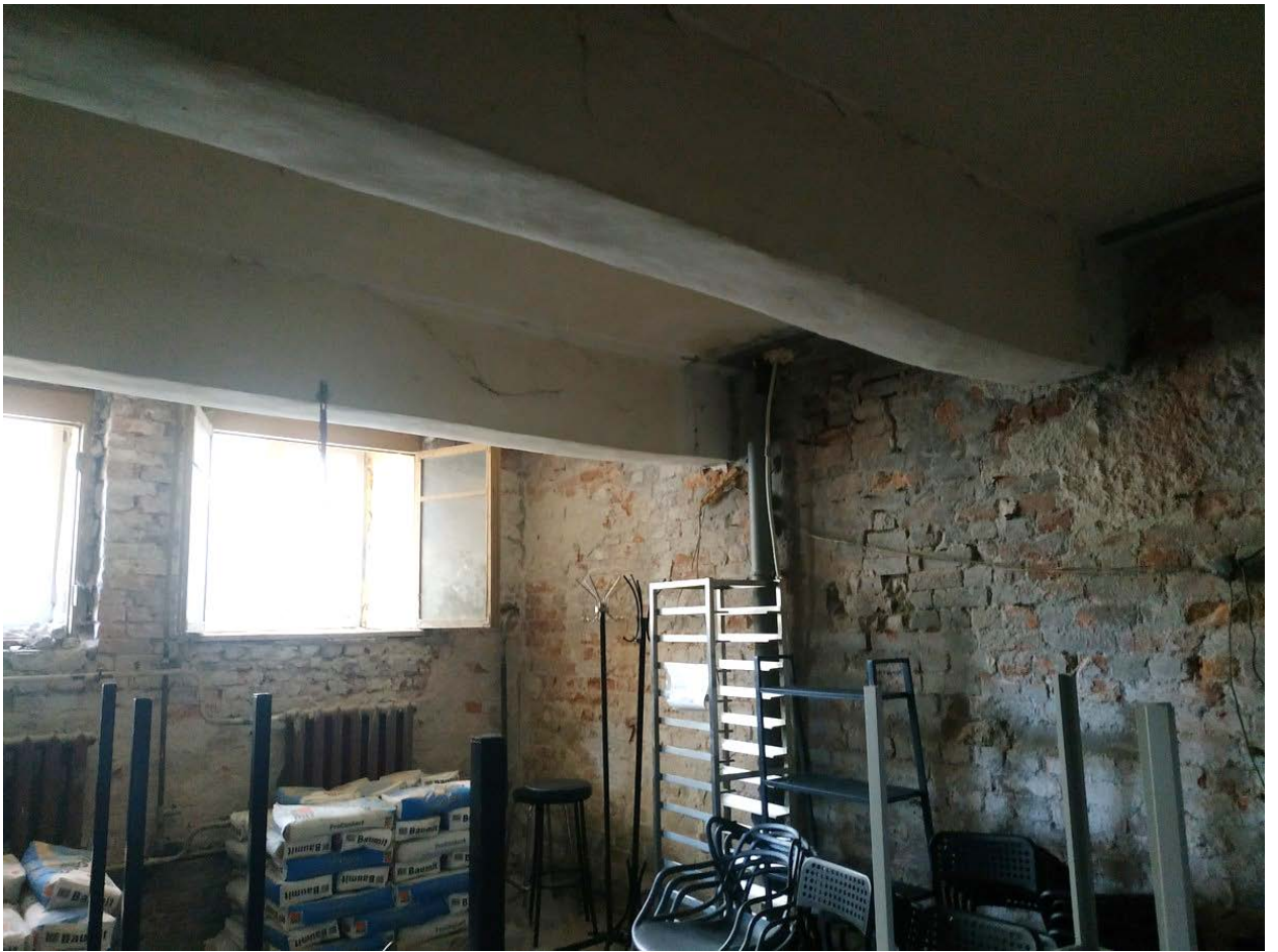
18. Помещение №3. Перекрытие по железобетонным балкам.
