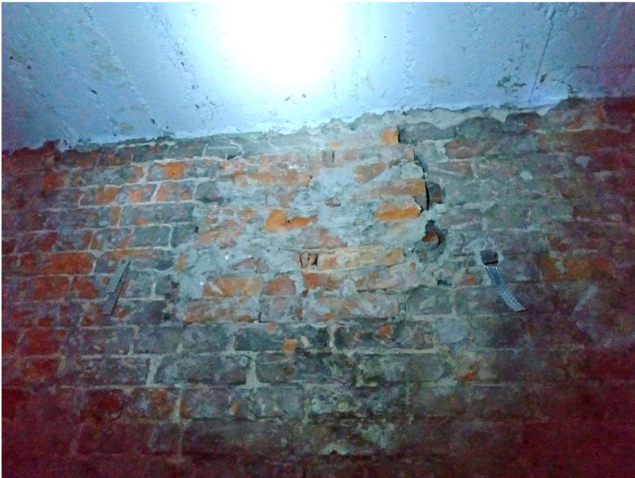
27. Заложенное отверстие (дымовой канал?) в стене между помещениями 1 и 2.
