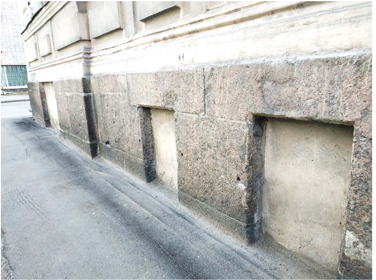
6. Заложенные оконные проёмы помещения 1-Н (фасад по Выборгской ул.)
