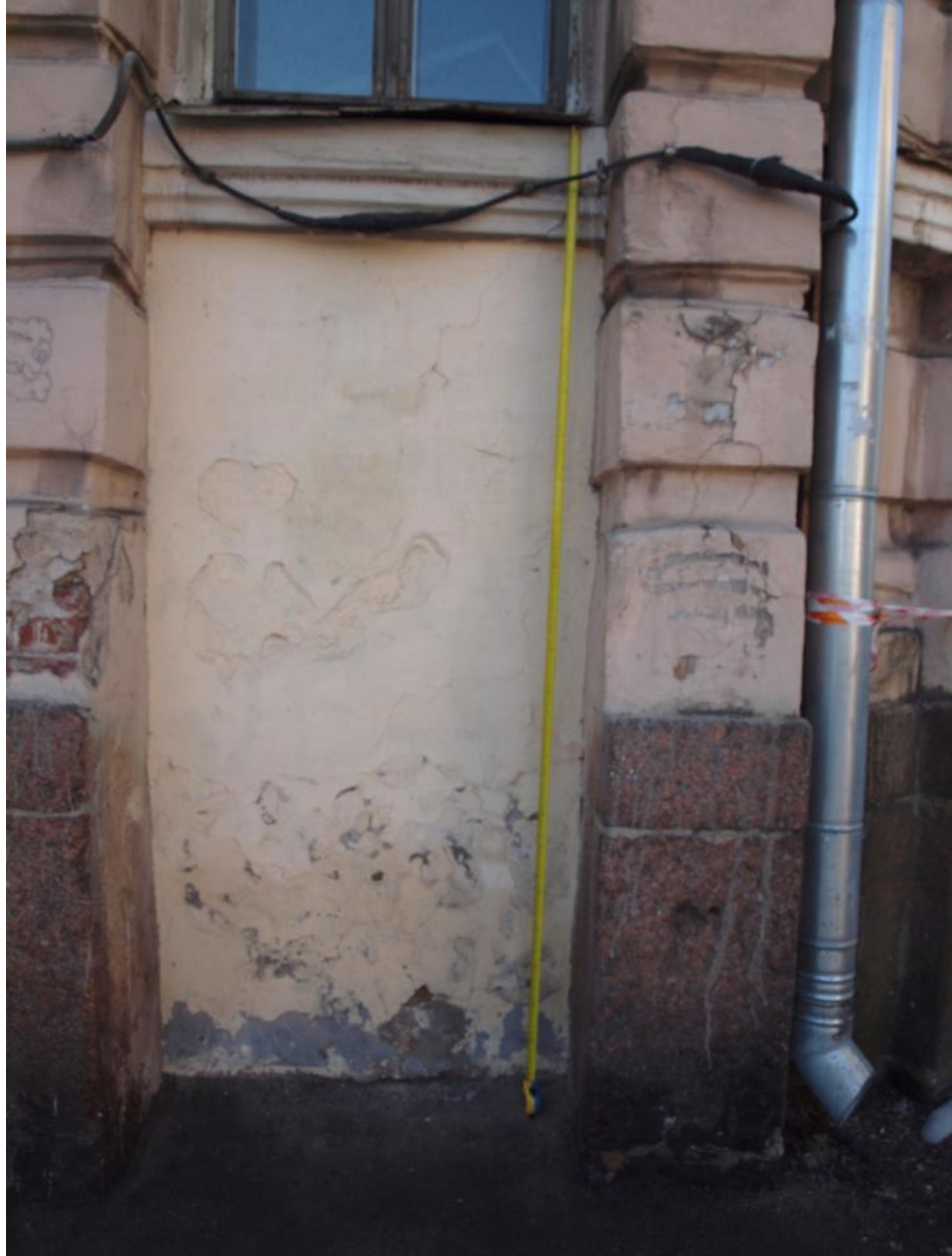
20. Общий вид заложённого дверного проёма
