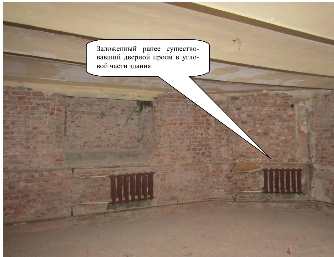
Фото № 5.3-1. Вид со стороны интерьера на стену по оси «1» и угловую часть в осях «1-1/1». Видны заложенный оконный и дверной проемы.
