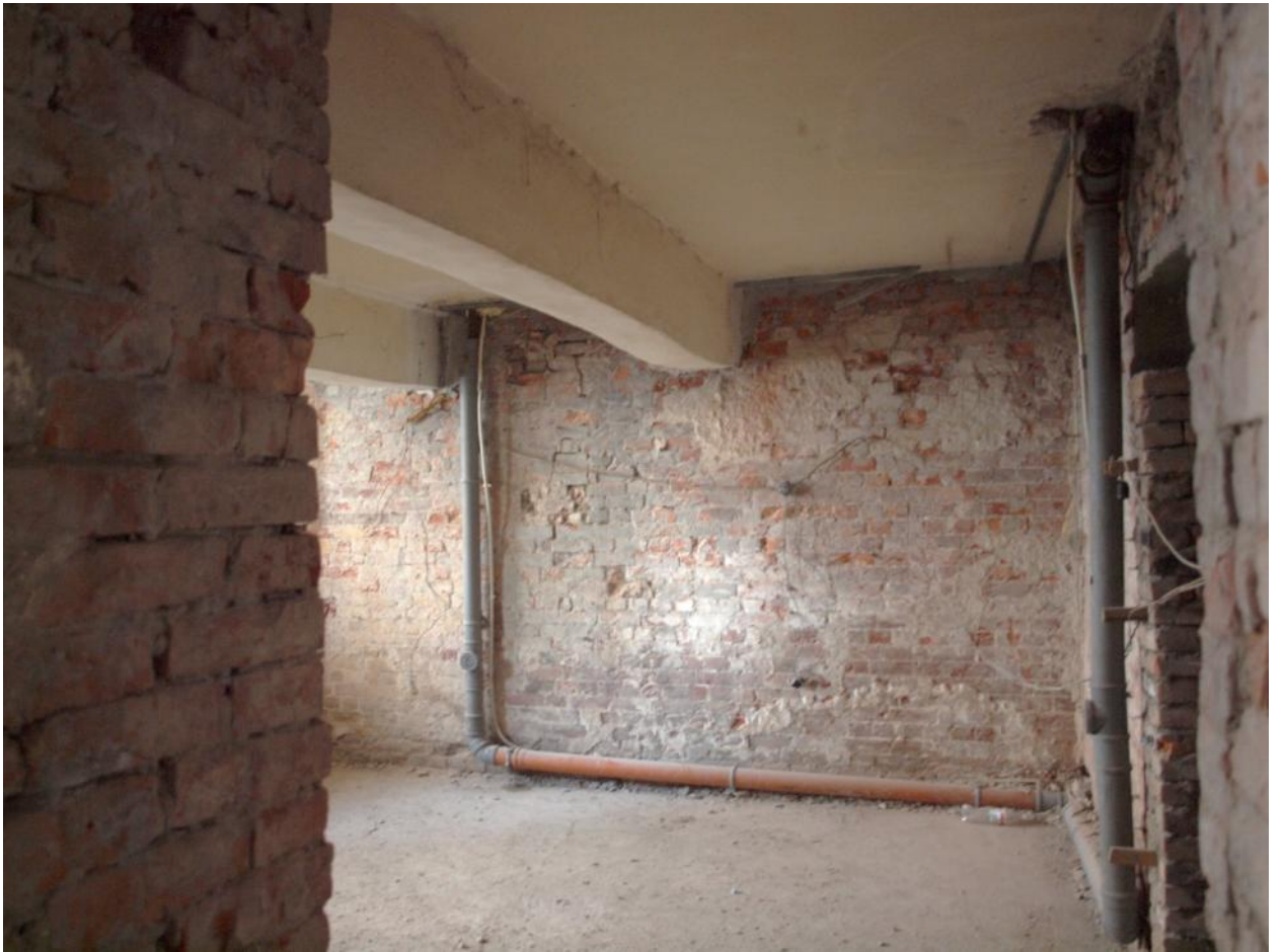
27. Пом 3. Общий вид стены по оси «3».
