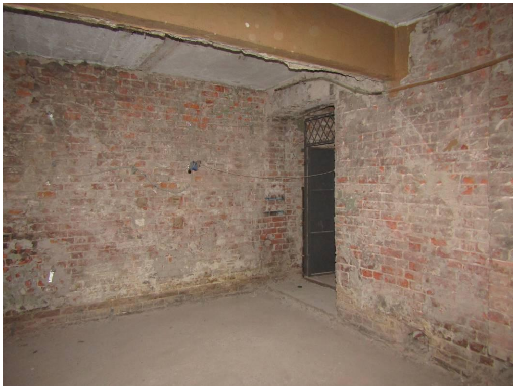
Фото № 5.2-5. Несущая ж/б балка перекрытия над помещением в осях 1-2/А-Г с опиранием на стену по оси «2»
