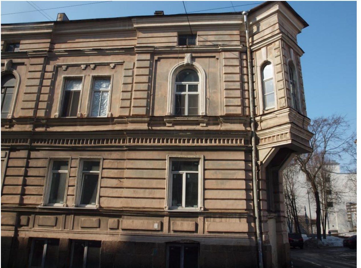
2. Фрагмент фасада по ул. Новой Заставы.
