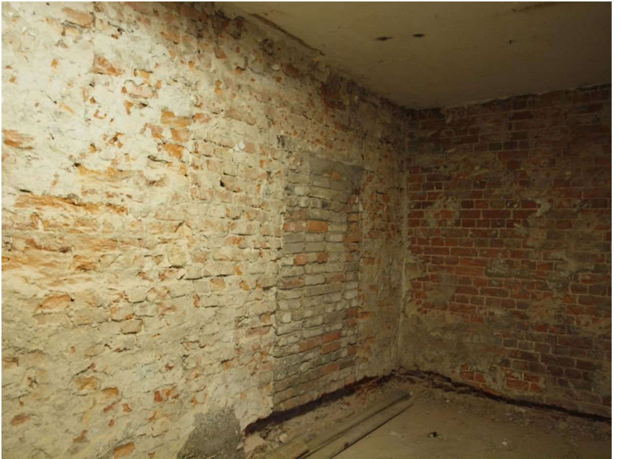
37. Пом. 5. Заложенный дверной проем в стене по оси «Б».
