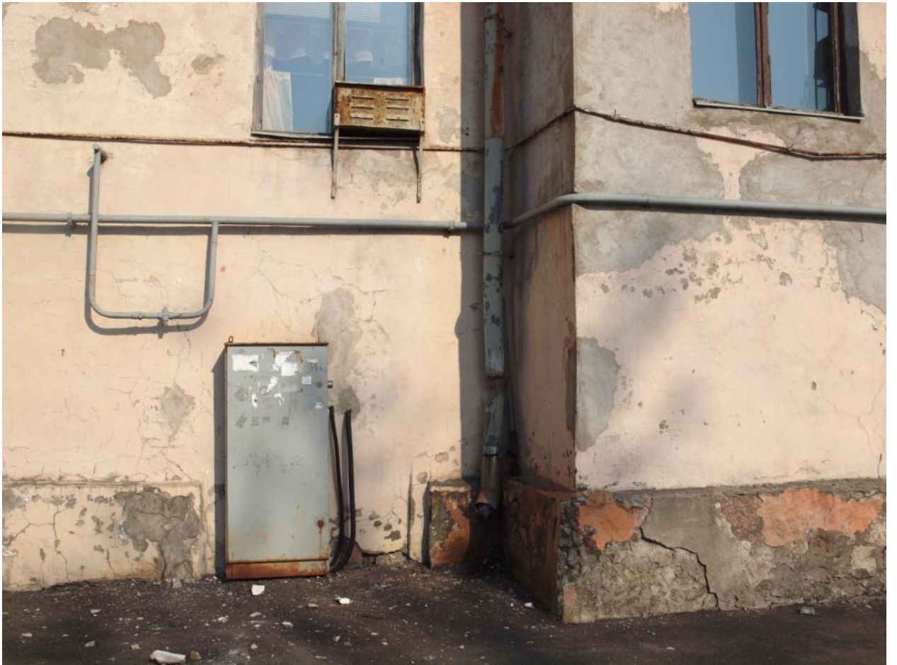
8. Фрагмент юго-западного фасада
