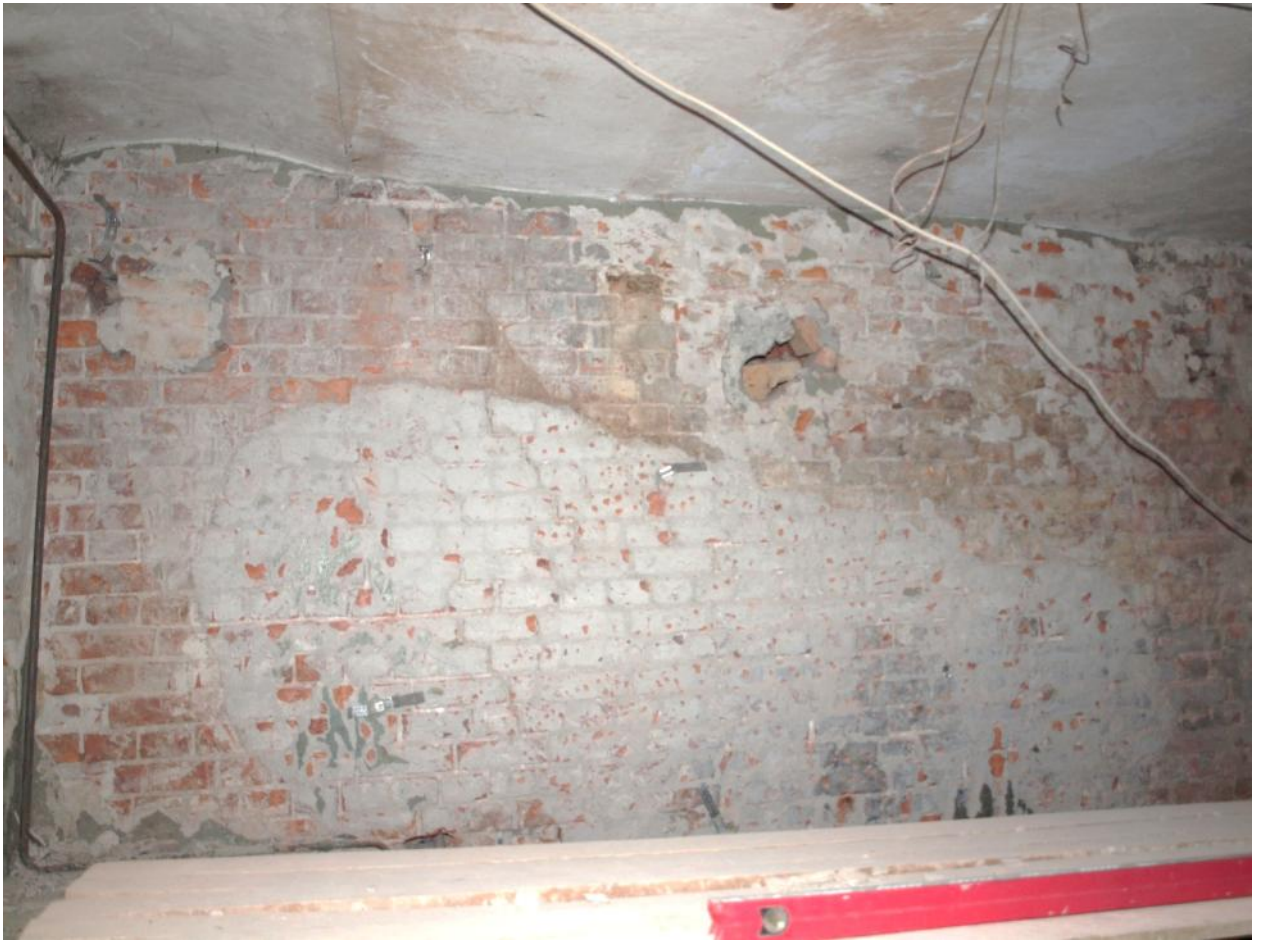
33. Пом. 4. Стена по оси «В».
