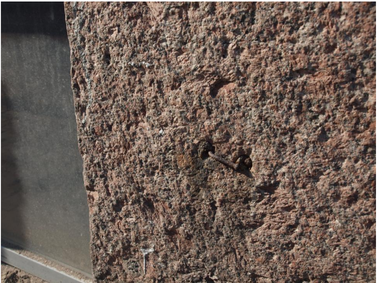
13. Отверстия в граните по обеим сторонам от оконных проёмов юго-восточного фасада
