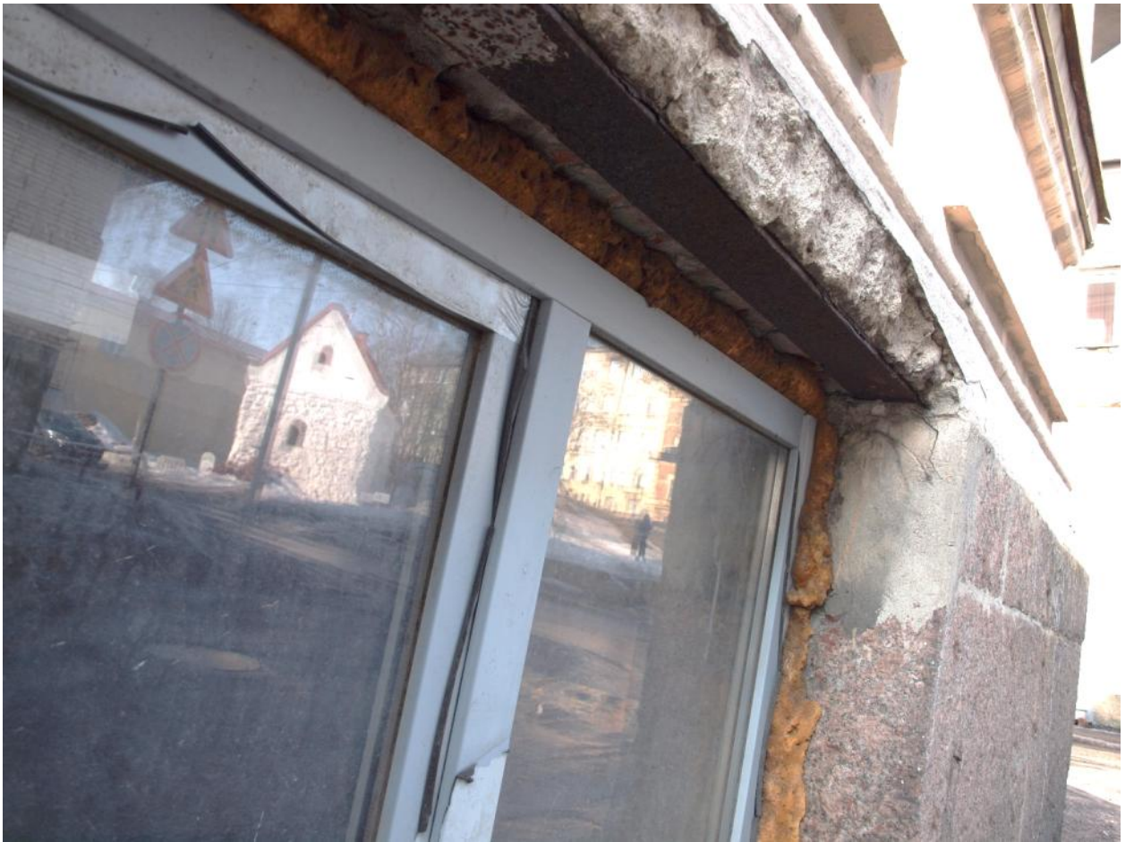
14. Состояние верхнего откоса оконного проёма юго-восточного фасада
