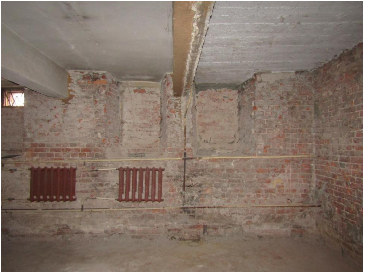
30. Пом. 2. Вид стены по оси «1». Поздние закладки оконных проемов.
