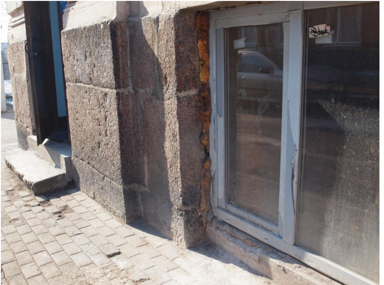
11. Поздние оконные заполнения оконных проемов юго-восточного фасада
