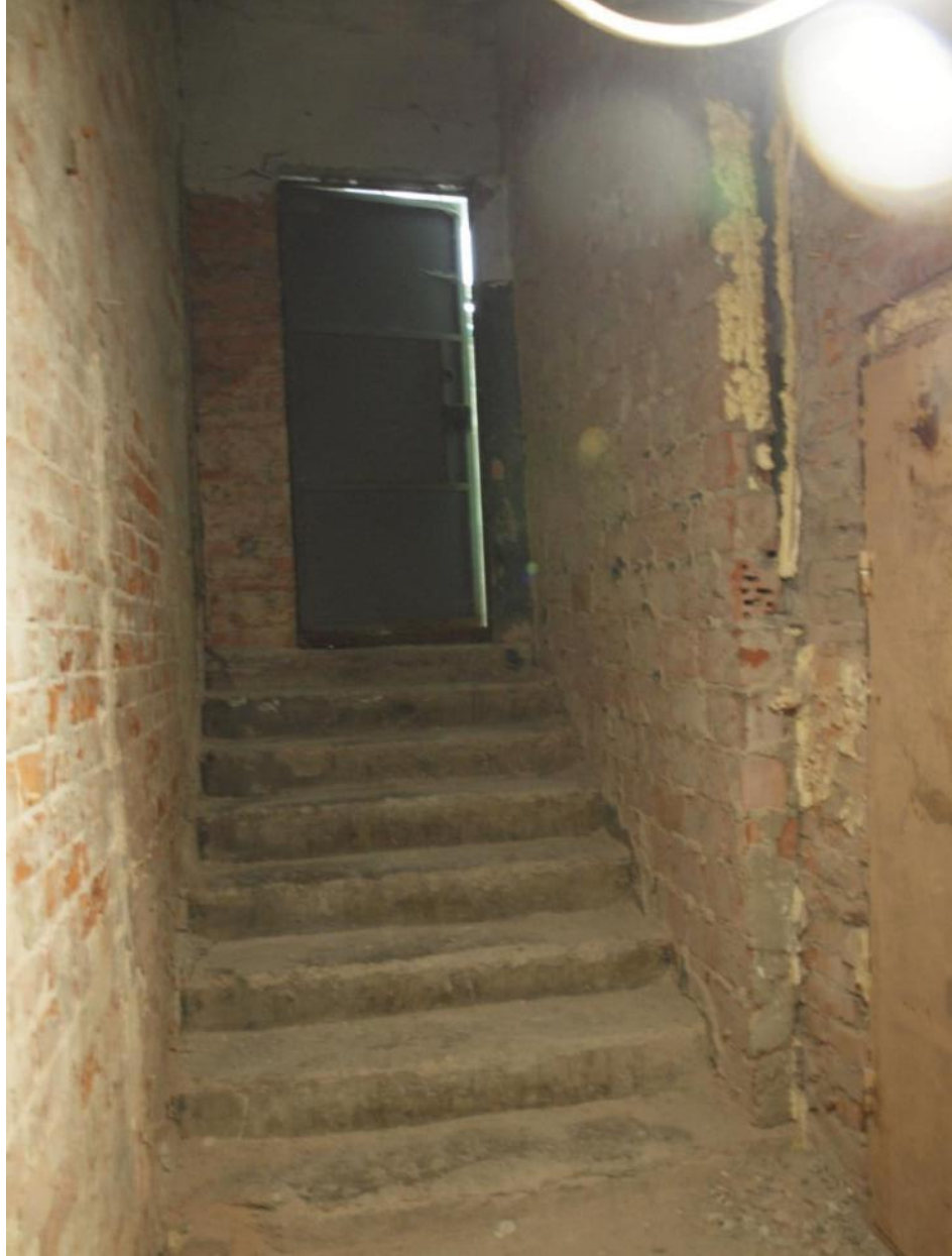
38. Пом. 6. Общий вид. Поздняя кирпичная кладка справа от лестничного марша.
