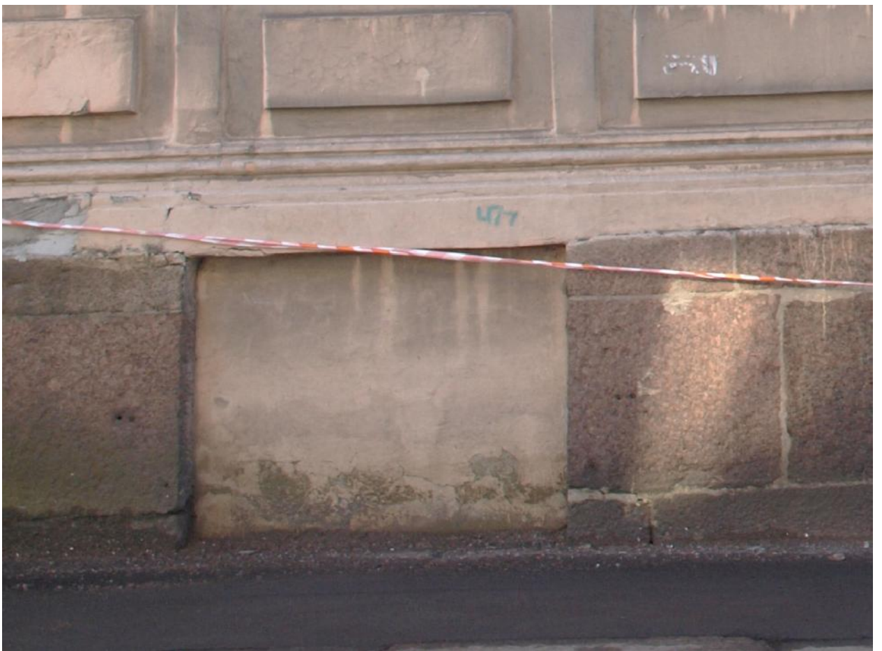
16. Отверстия в гранитных блоках, по обеим сторонам от оконного проёма
