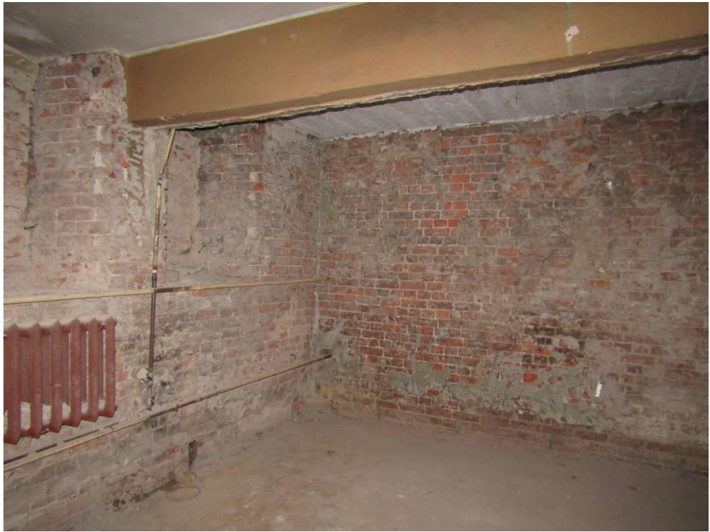
Фото № 5.2-4. Несущая ж/б балка перекрытия над помещением в осях 1-2/А-Г с опиранием на наружную стену по оси «1»
