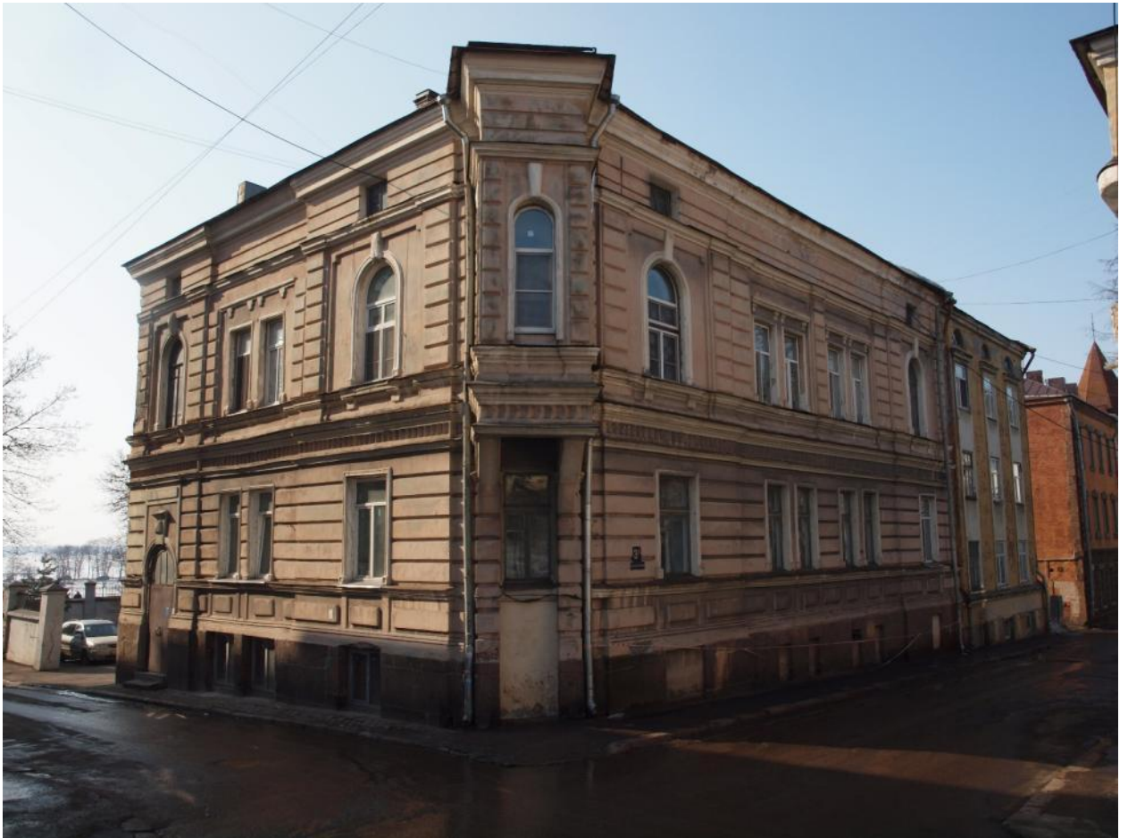
1. Общий вид здания с пересечения ул. Выборгской и ул. Новой заставы.
