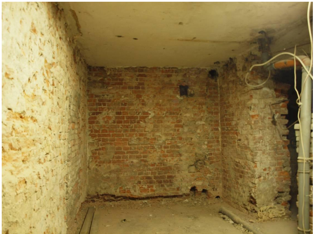
Фото № 5.3-8. Стен по оси «2» и монолитный ж/б потолок помещения в осях Б-В/2-4.
