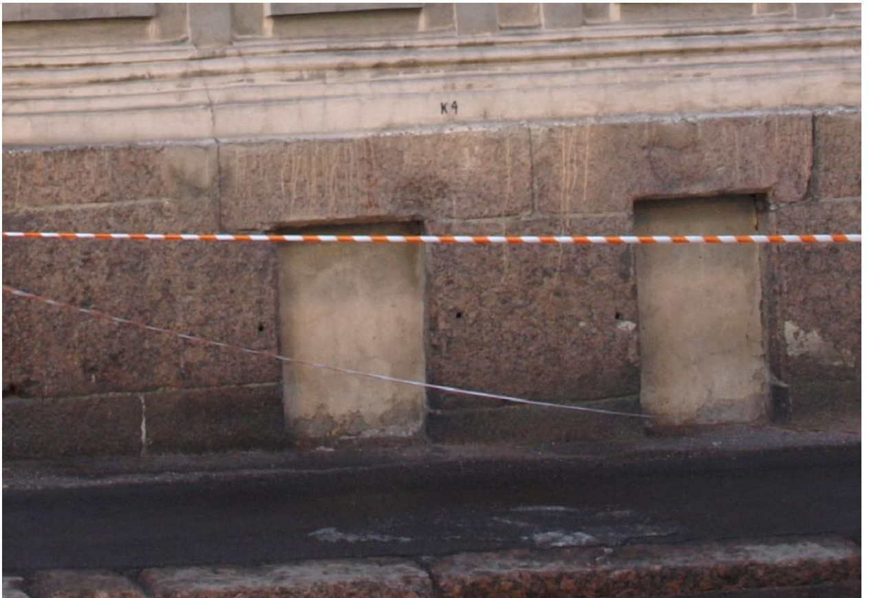
17. Отверстия в гранитных блоках по обеим сторонам оконного проёма
