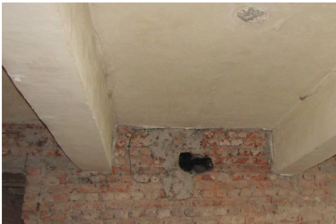
Фото № 5.3-4. Дымовой канал по оси «2».
