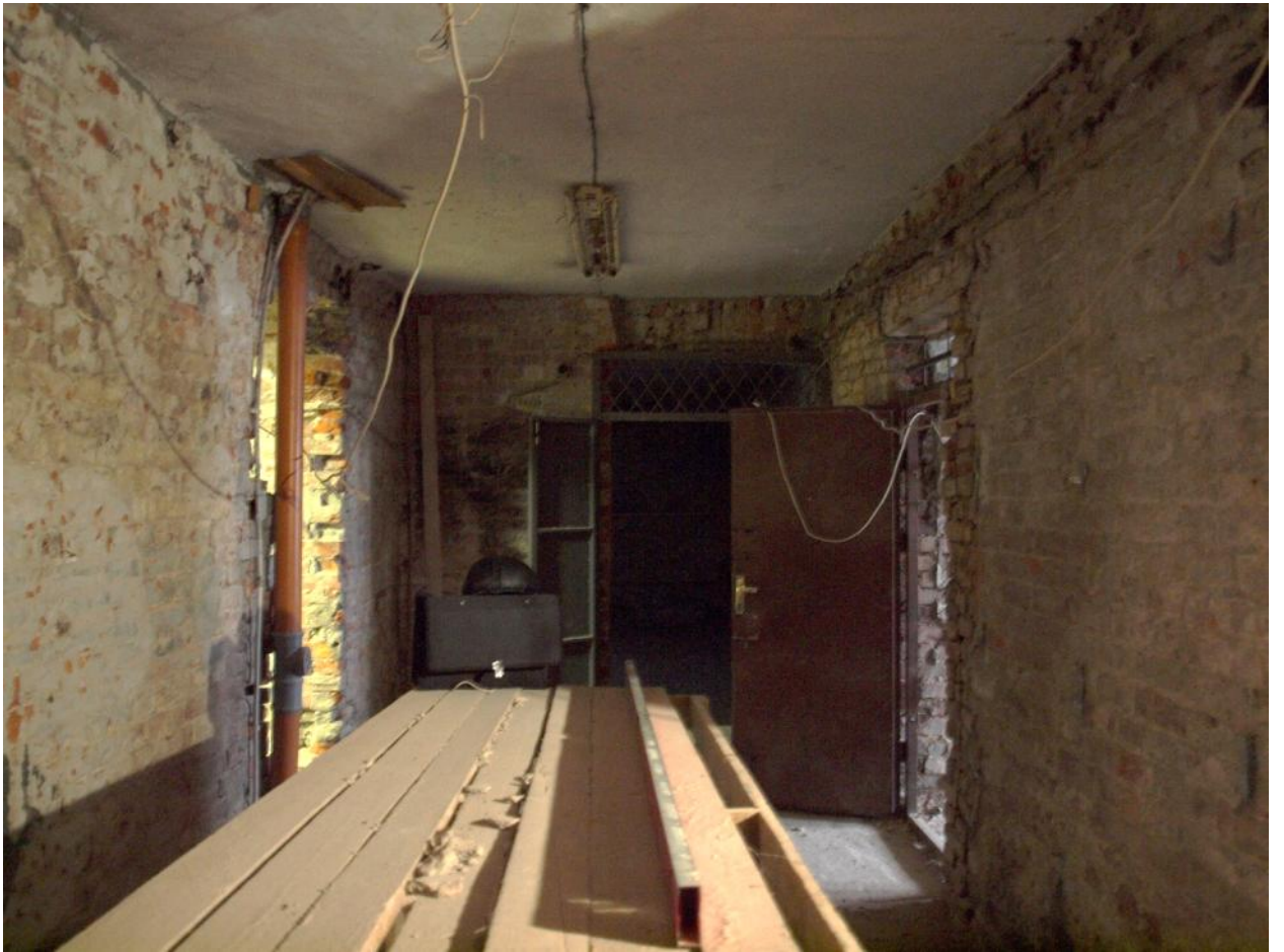
32. Пом. 4. Общий вид.
