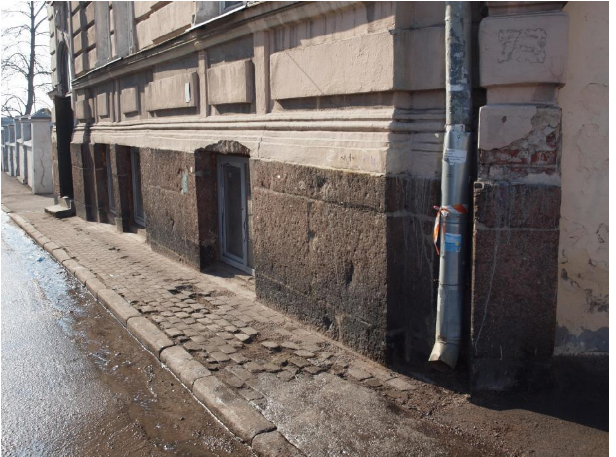
10. Цокольный этаж юго-восточного фасада
