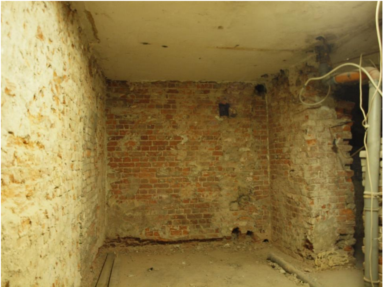
36. Пом. 5. Вид на стену по оси «2».
