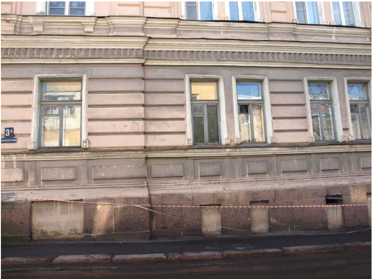
15. Заложенные оконные проёмы цокольного этажа на северо-восточном фасаде
