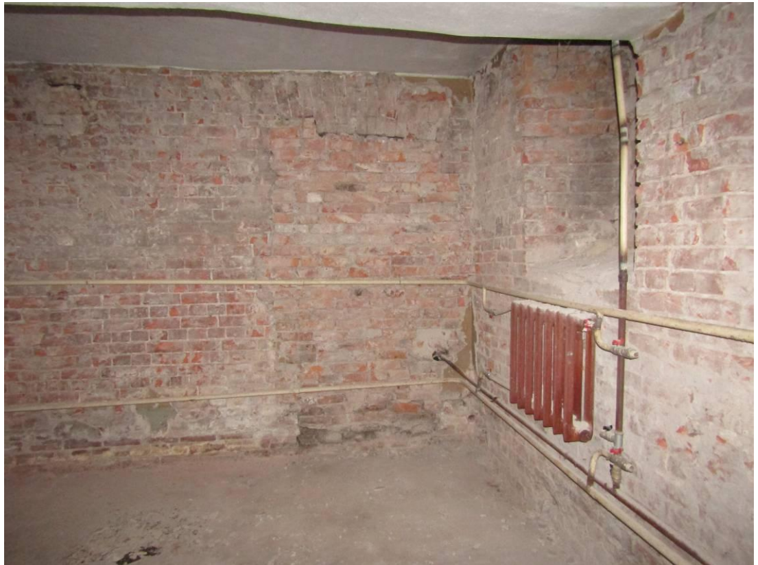
Фото № 5.3-2. Заложенный ранее существовавший дверной проем в кирпичной стене по оси «2» в осях «Г-Д», имевший кирпичную арочную перемычку.
