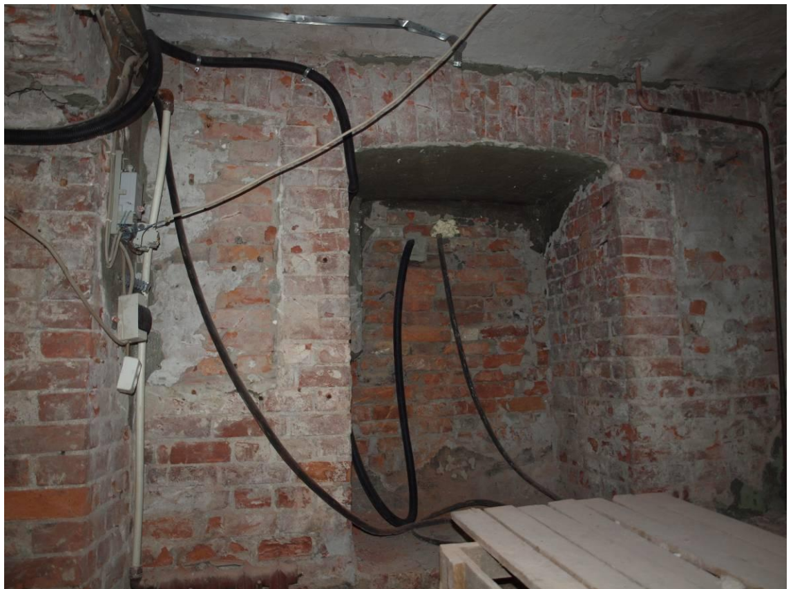
Фото № 5.3-6. Фрагмент торцевой стены помещения в осях В-Г/2-4.
