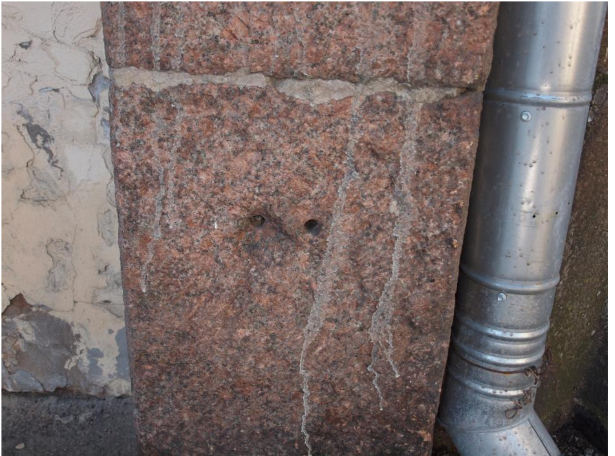
22. Следы креплений ограждения утраченного прямка
