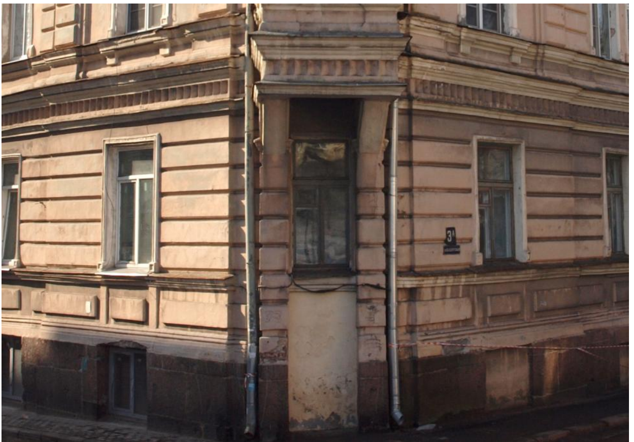
19. Общий вид угловой части здания в уровне цокольного и первого этажей
