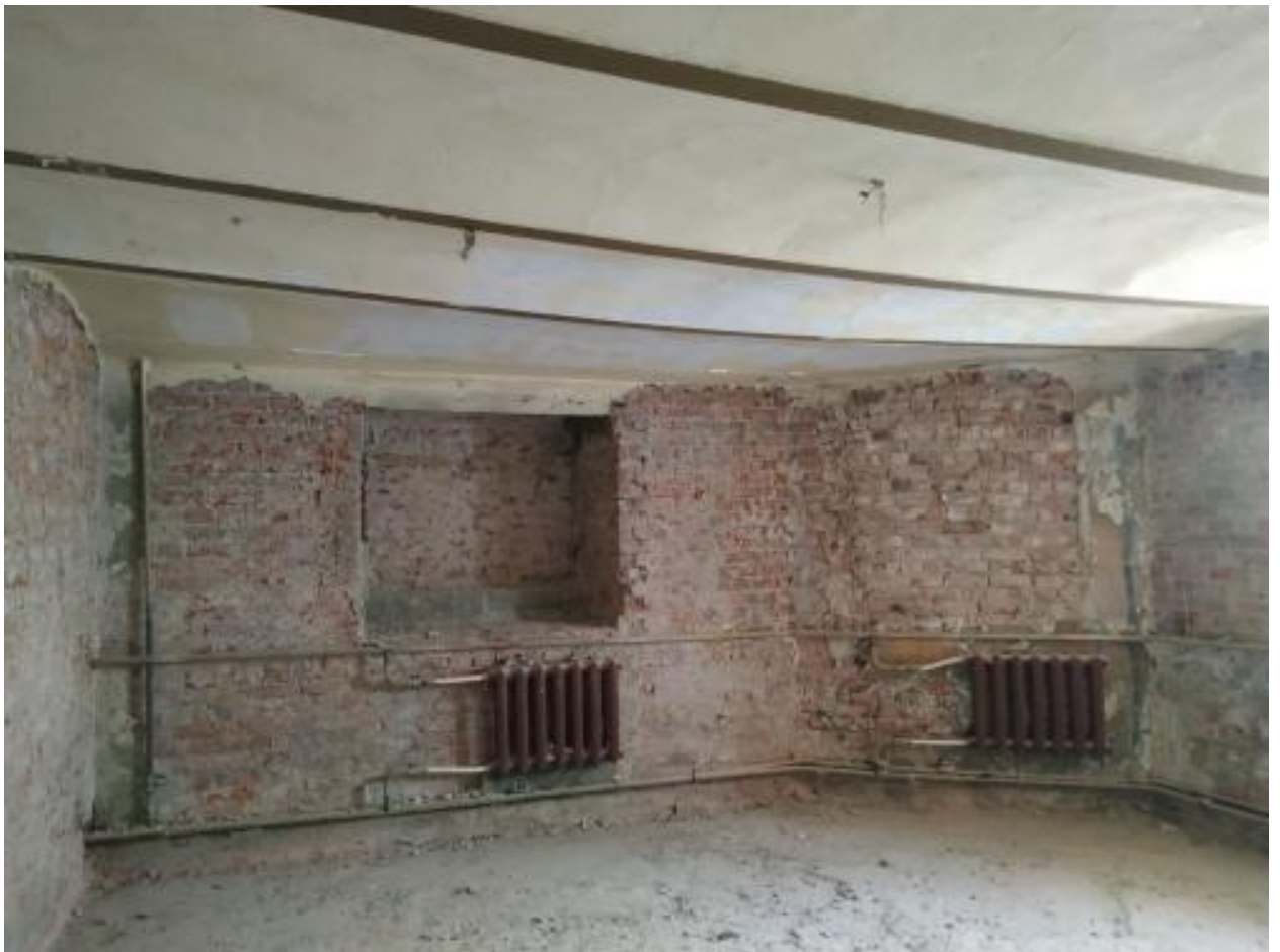
23. Пом. 1. Стена по оси «1» и «1.1». Заложённый оконный проём, выходящий на ул. Выборгская и следы заложённого дверного проёма, выходящего на угол здания. Вид из помещения 1.
