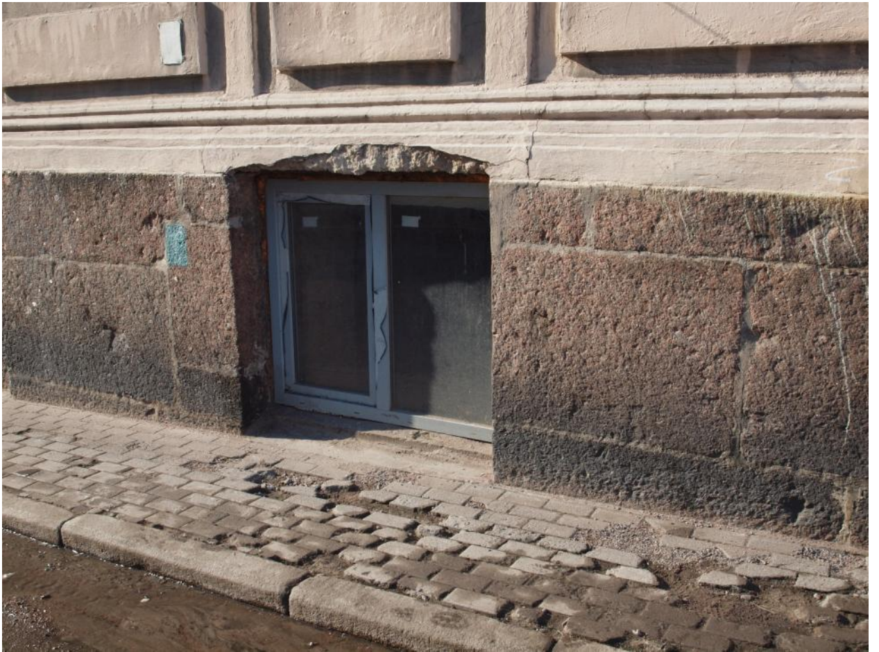
12. Оконное заполнение юго-восточного фасада
