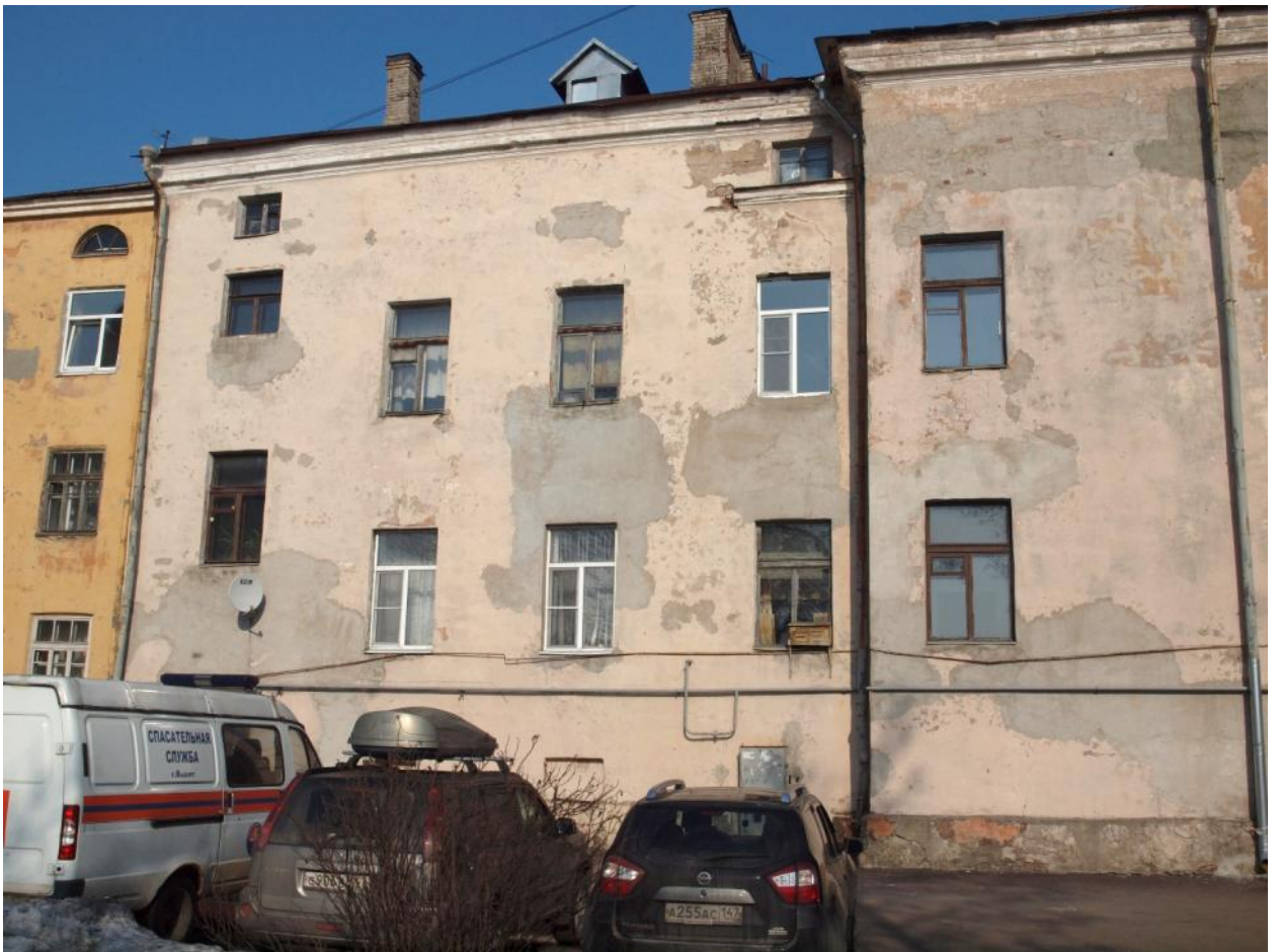
7. Общий вид дворового (юго-западного) фасада
