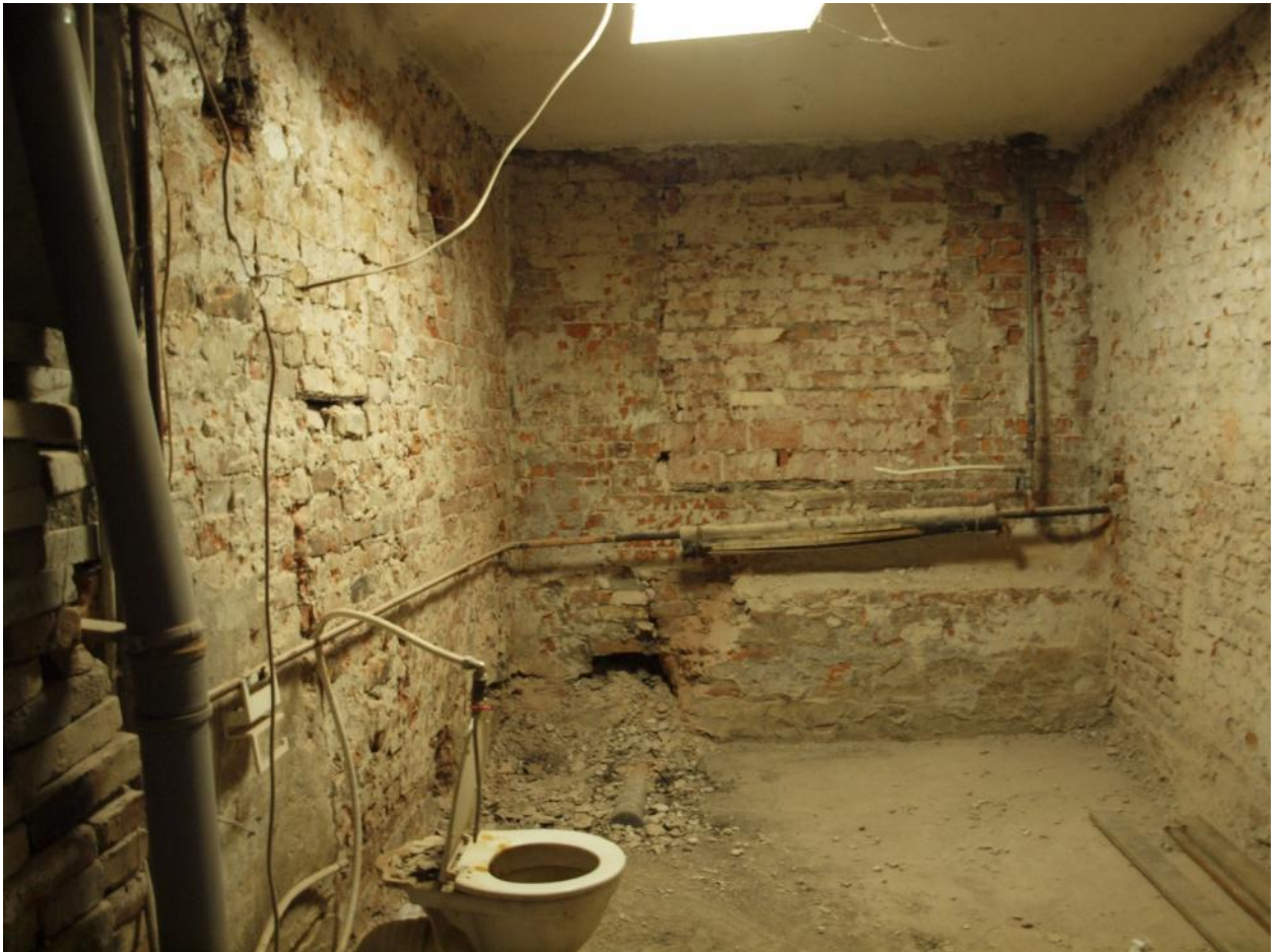
35. Пом. 5. Общий вид помещения. Заложенный оконный проем в стене по оси «4».
