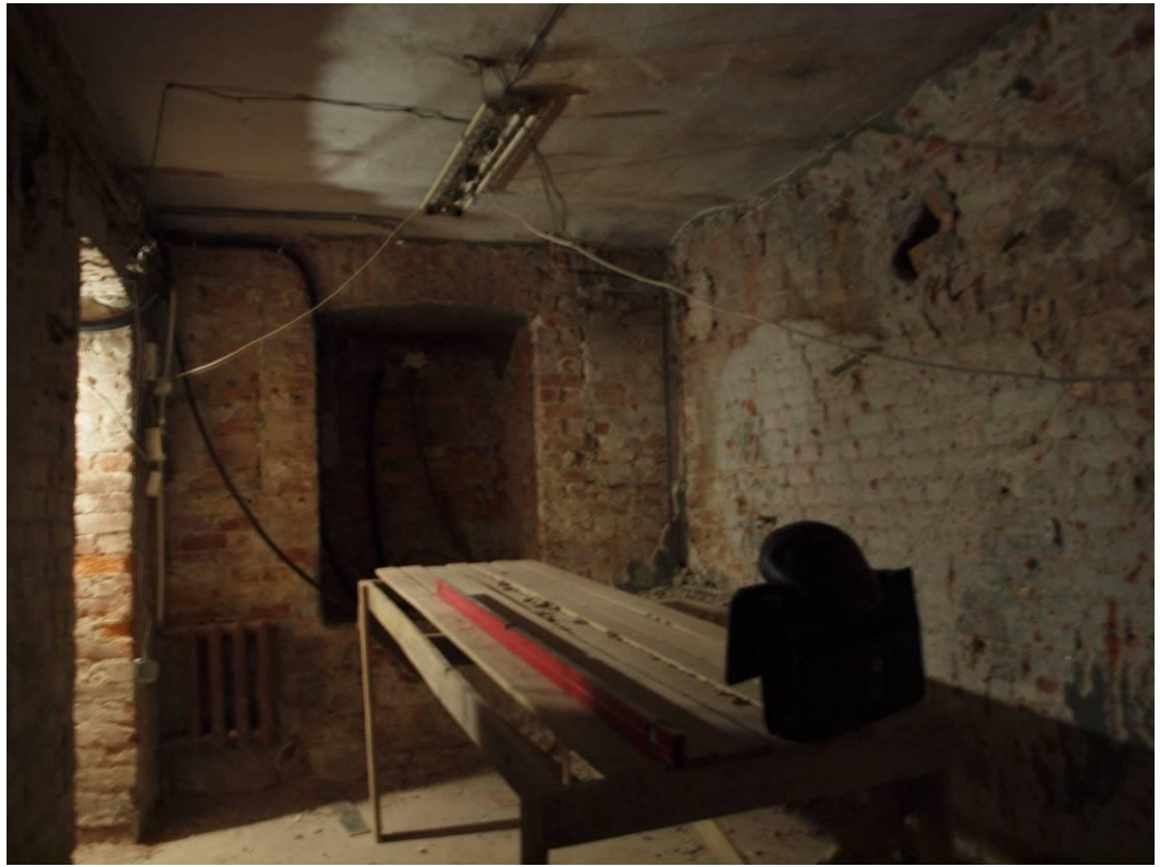
Фото № 5.3-5. Вид стен и монолитного ж/б потолка помещения в осях В-Г/2-4. На торцевой стене видна ниша, образовавшаяся при закладке оконного проема.
