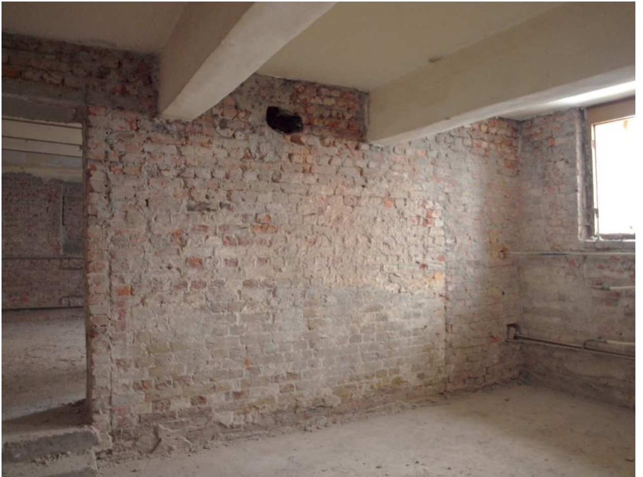
28. Пом. 3. Общий вид стены по оси «2». Заложенный дверной проем справа.
