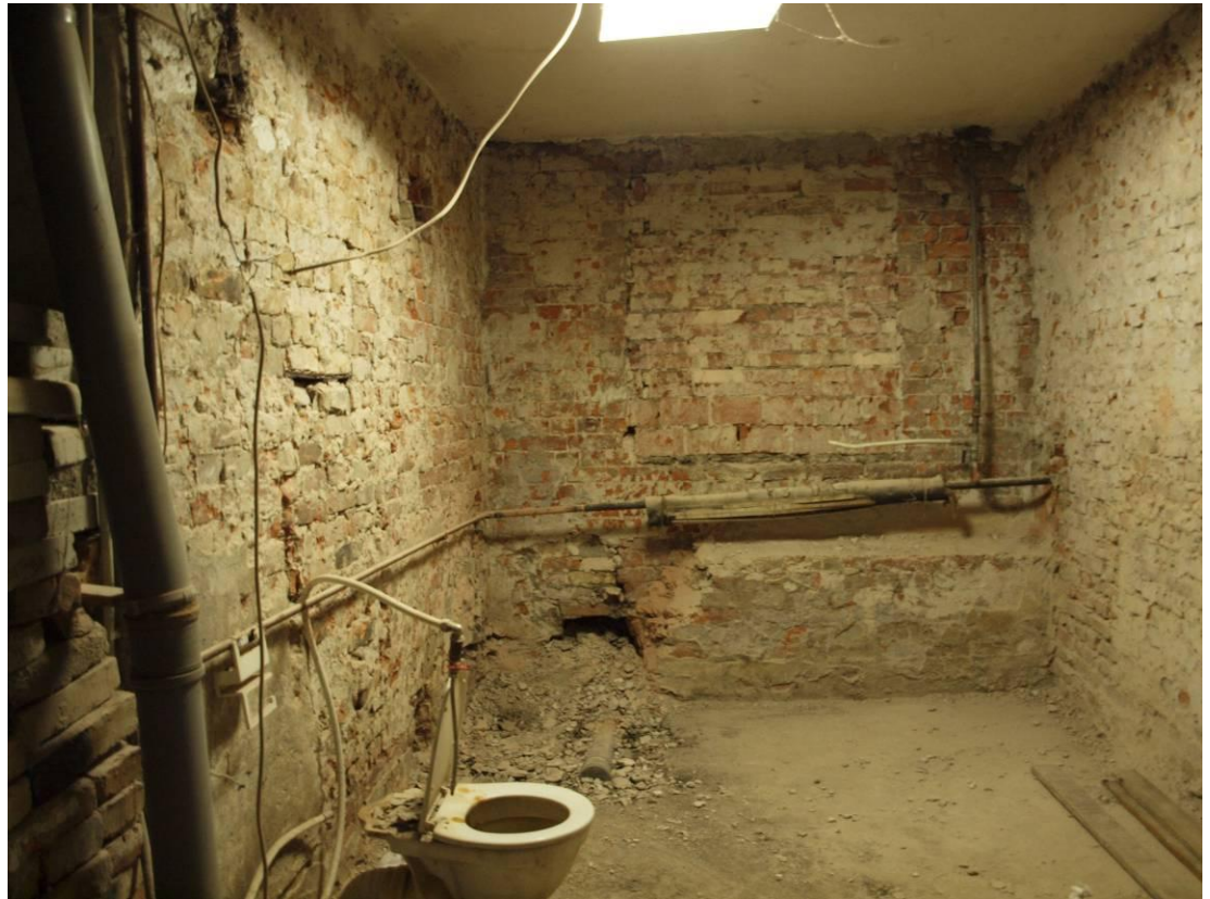
Фото № 5.3-7. Стены помещения в осях Б-В/2-4. На торцевой стене заложен ранее существовавший оконный проем.
