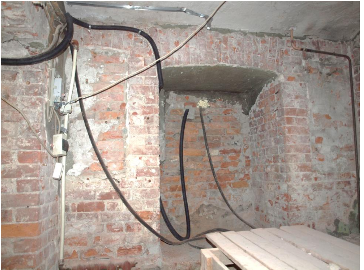
34. Пом. 4. Стена по оси «4». Заложённые проёмы, лучковые перемычки проёмов.
