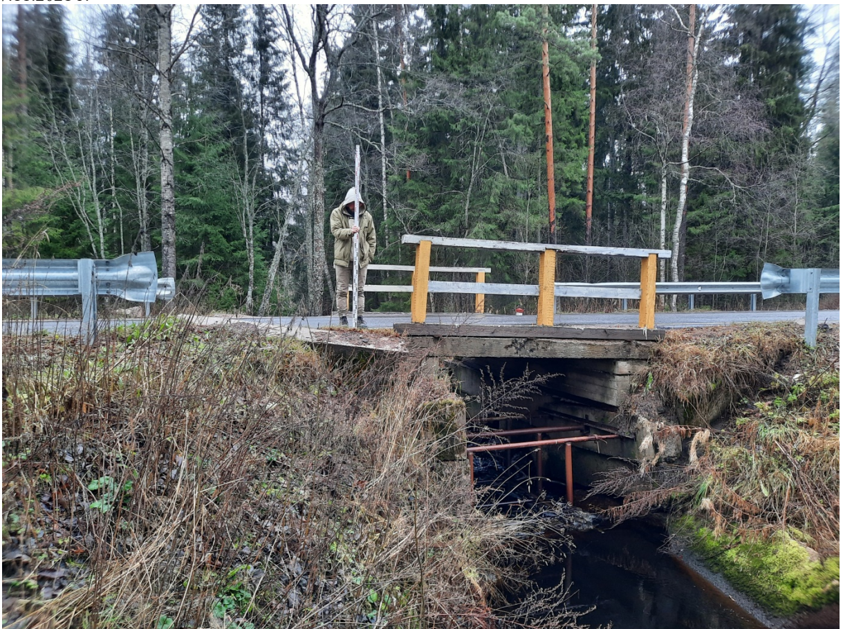
Илл. 17. Ленинградская обл., Выборгский р-н, участок обследования. Точка фотофиксации 5. Вид с юга. 17.11.2021 г.
