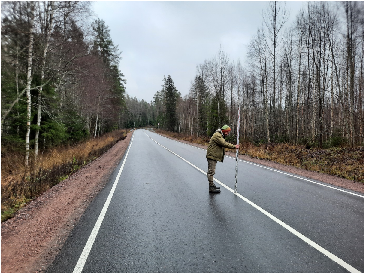
Илл. 13. Ленинградская обл., Выборгский р-н, участок обследования. Точка фотофиксации 1. Вид с запада. 17.11.2021 г.
