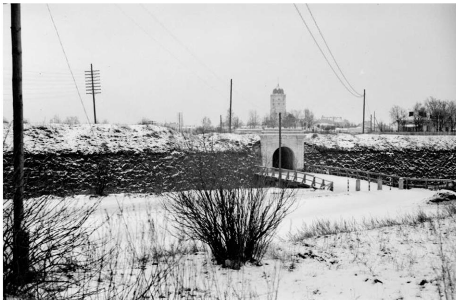
24. Вид на второй рavelин, Рavelинные ворота и мост через ров. 1939 г. Фотография. wiipuri.fi .
