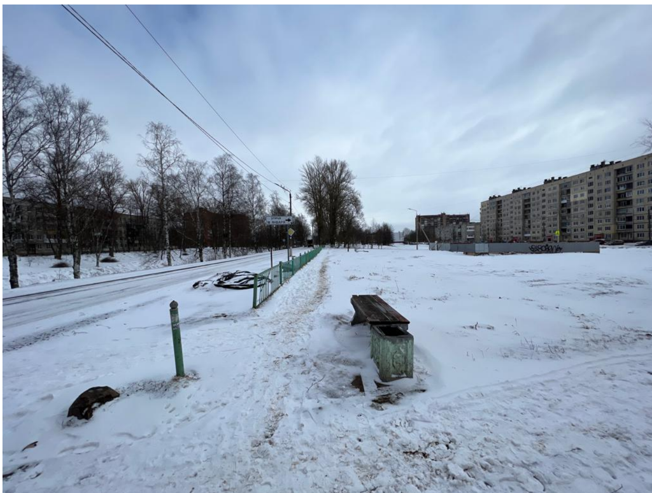
3. Вид с юго-запада на зону производства работ. С запада - Малоневский канал объекта культурного наследия регионального значения «Комплекс зданий и сооружений на Староладожском канале», расположенного по адресу: Ленинградская область, Кировский муниципальный район, Шлиссельбургское городское поселение, г. Шлиссельбург, ул. Малоневский канал, соор. 1.
