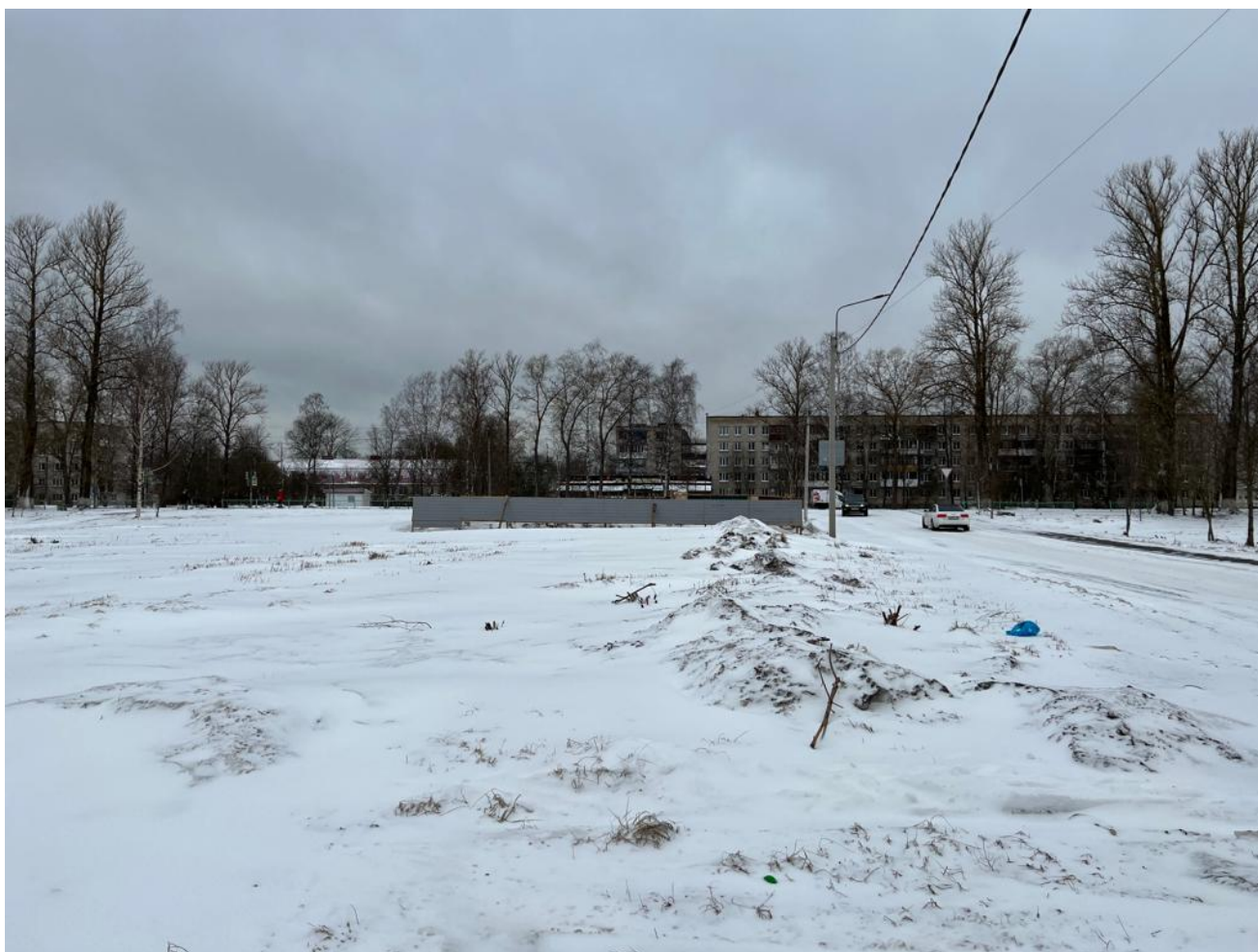
1. Вид с юго-востока на зону производства работ и Малоневский канал объекта культурного наследия регионального значения «Комплекс зданий и сооружений на Староладожском канале», расположенного по адресу: Ленинградская область, Кировский муниципальный район, Шлиссельбургское городское поселение, г. Шлиссельбург, ул. Малоневский канал, соор. 1.
