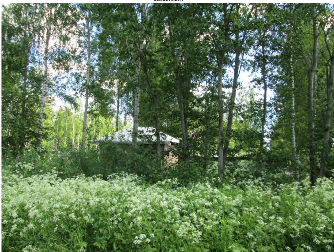
Илл. 64. Ленинградская обл., Ломоносовский р-н. Территория ОКН у западной окраины д. Узигонты. Точка фотофиксации Ф14. Вид с запада, в сторону д. Узигонты.
