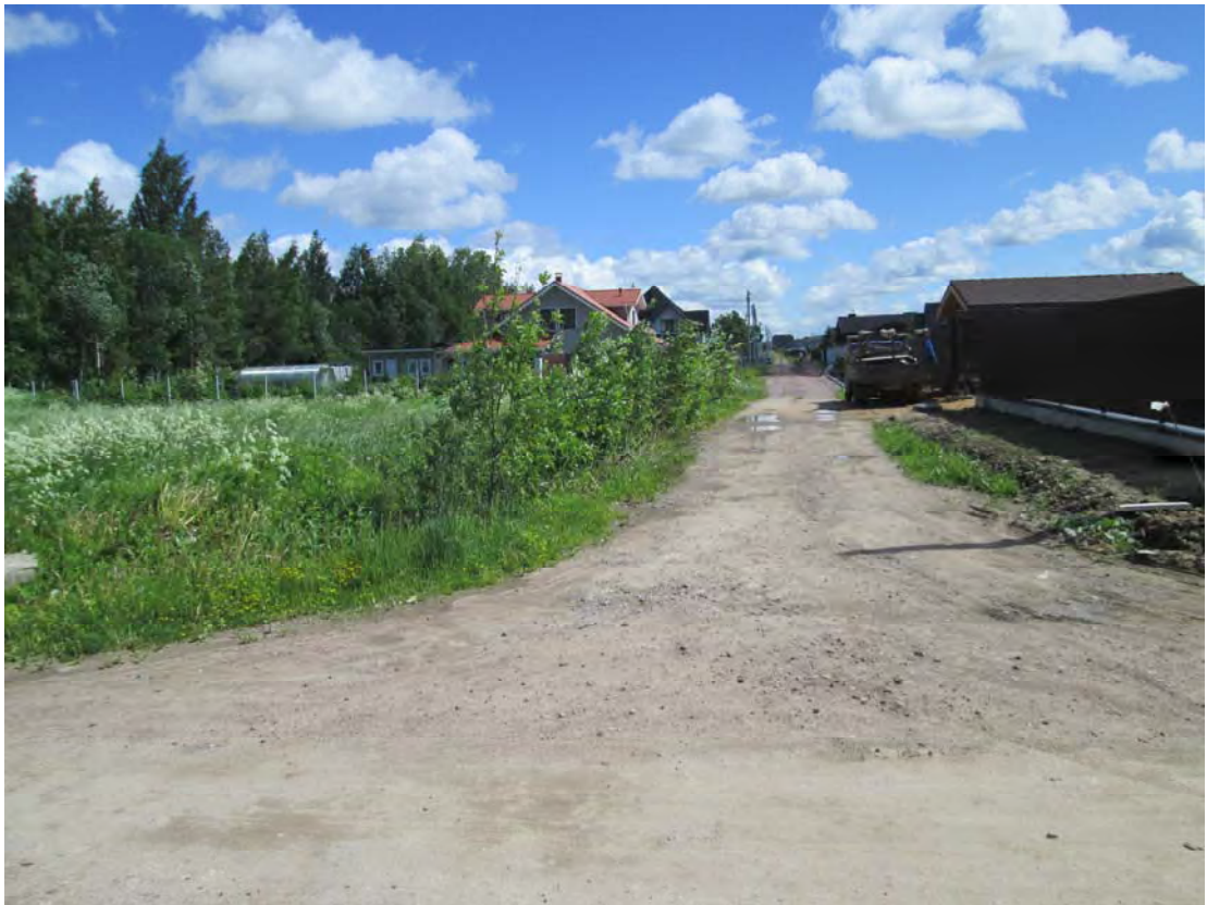
Илл. 37. Ленинградская обл., Ломоносовский р-н, д. Узигонты. Точка фотофиксации Ф7. Вид с запада на трассу проектирования и защитную зону ОКН, 11-й Международный пр-д.
