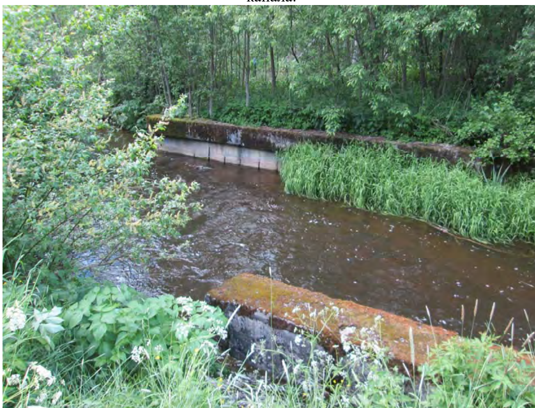
Илл. 60. Ленинградская обл., Ломоносовский р-н. Территория ОКН у западной окраины д. Узигонты. Точка фотофиксации Ф13. Вид с северо-востока на русло и берега Старопетергофского канала.
