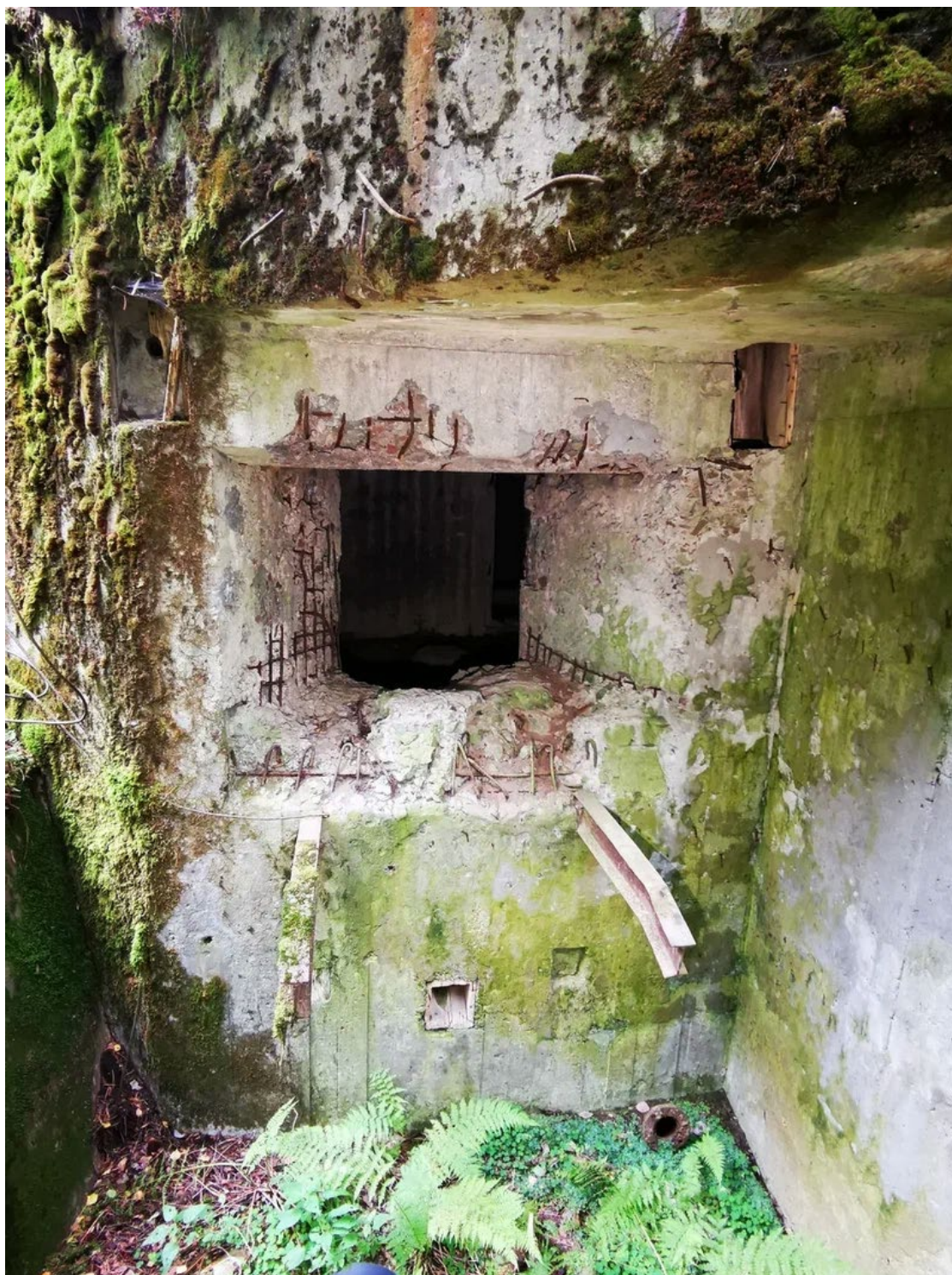
3. Амбразура для 76,2 мм орудия. Фото: 19.05.22
