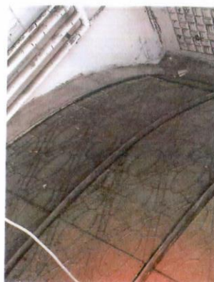
Конструкция крепления витража на металлические направляющие
