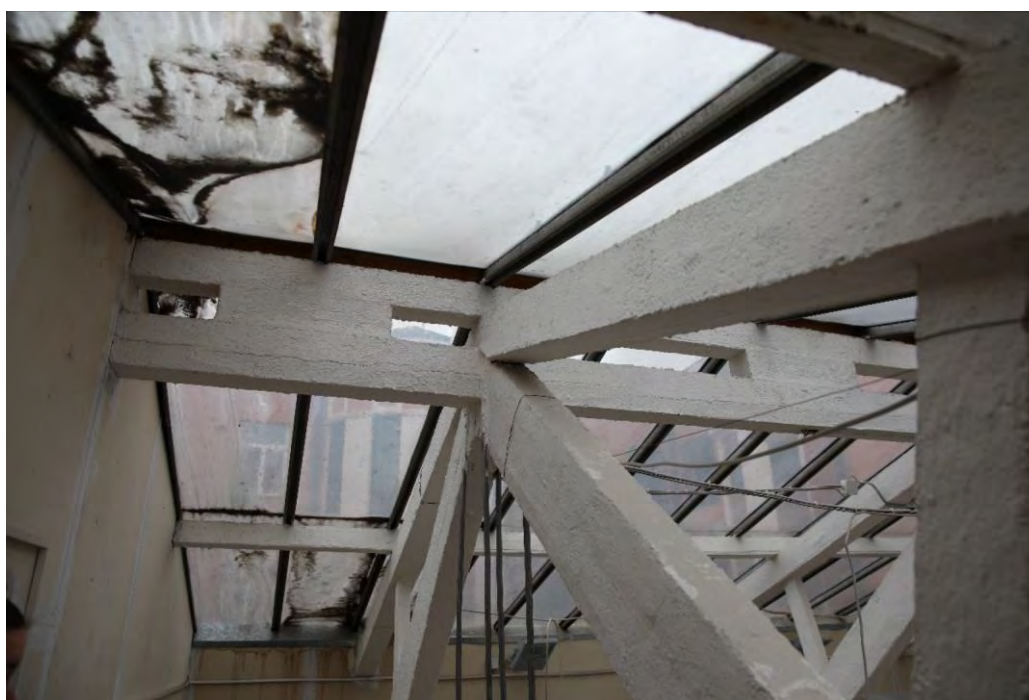
15. Объект культурного наследия регионального значения «Жилой и торговый дом «Карьяла» по адресу: Ленинградская область, Выборгский район, город Выборг, проспект Ленина, д.12/10. Конструкции кровли и светового фонаря над витражом.
