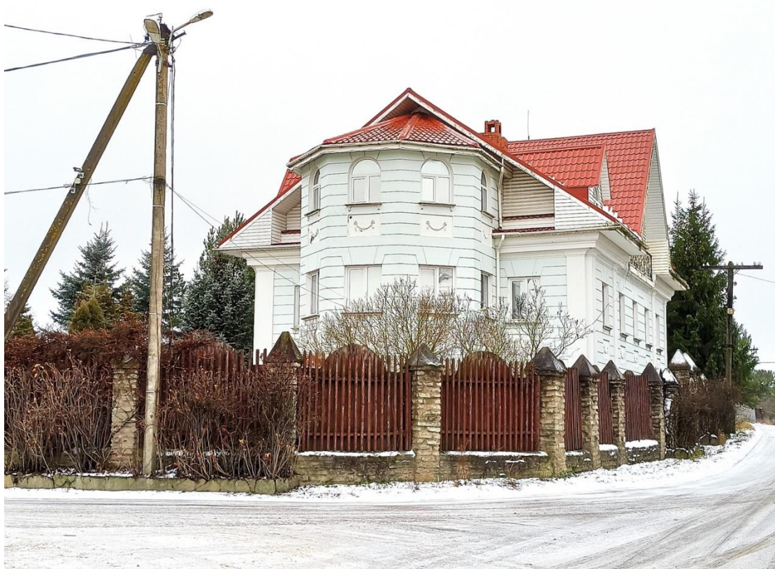
6. Вид объекта с юго-востока
