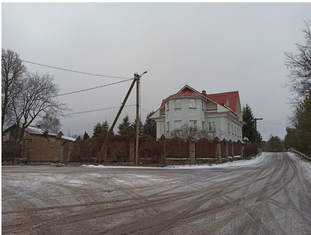
5. Вид объекта с юго-востока
