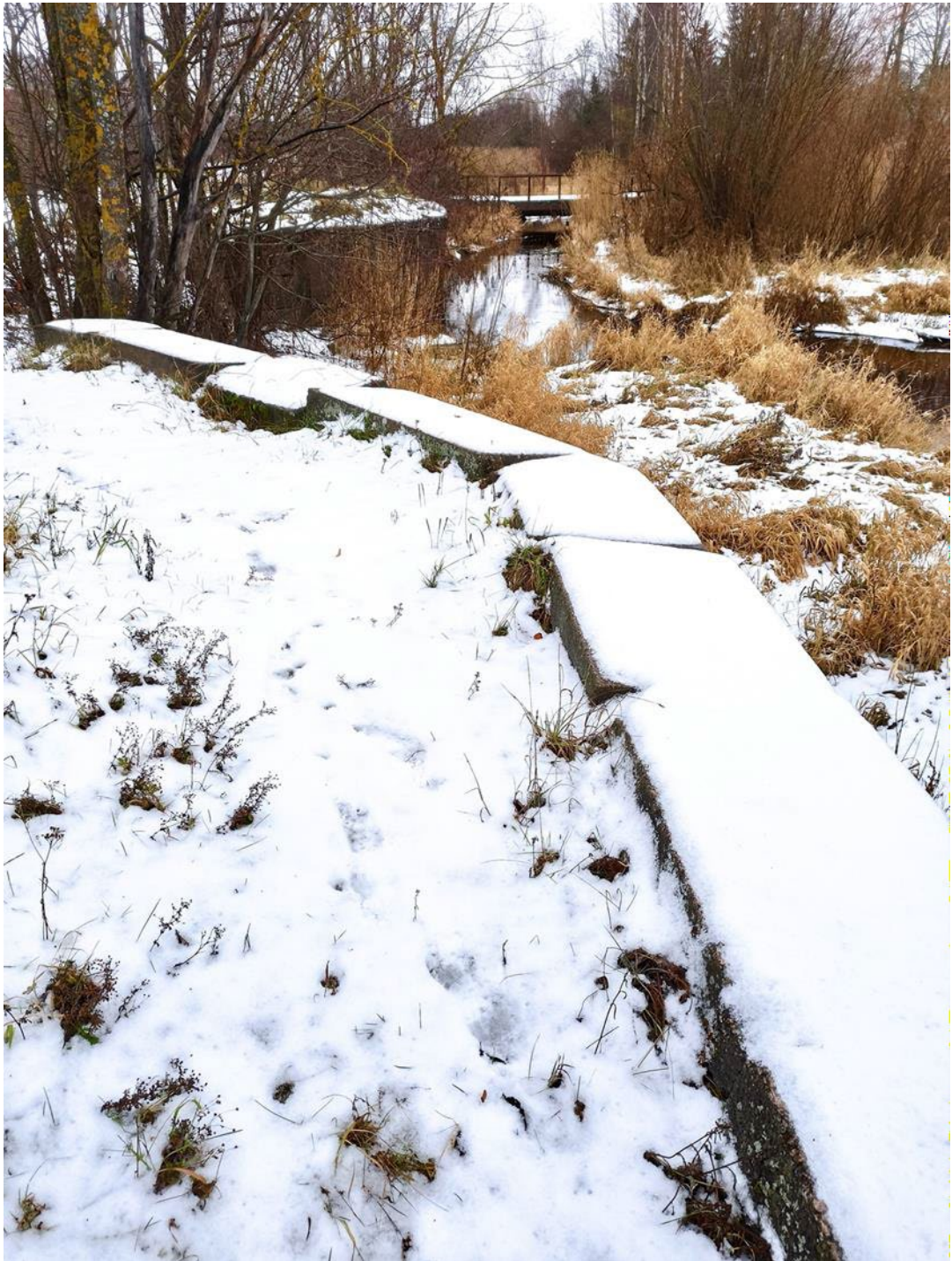
5. Фрагмент объекта. Вид с запада в сторону новог мост
