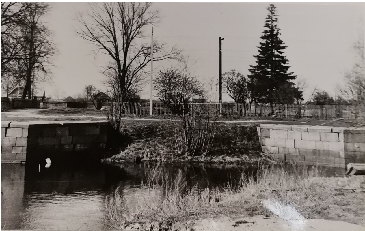
23.1998 г. Водоспуск в Нижней Шальдихе. Источник - Лермонтова М.А. Старо-Ладожский канал. История строительства и архитектура его зданий и сооружений. Диссертация на соискание ученой степени кандидата искусствоведения. РАХ, СПб Государственный академический институт живописи, скульптуры и архитектуры им. И.Е.Репина, 1997, с. 327
