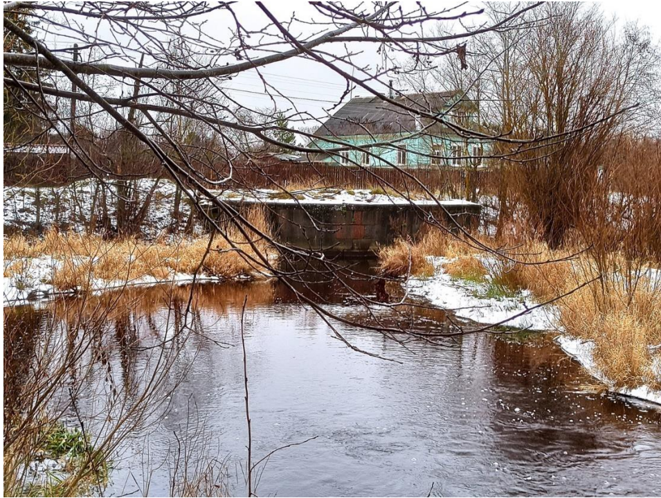
1. Вид на объект с юго-запада
