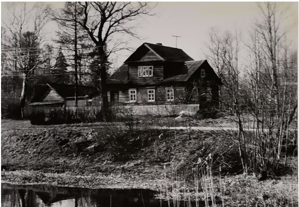
26.1997 г. Жилые дома на дамбе Староладожского канала в Шальдихе. — Лермонтова М.А., ук. соч., с. 371
