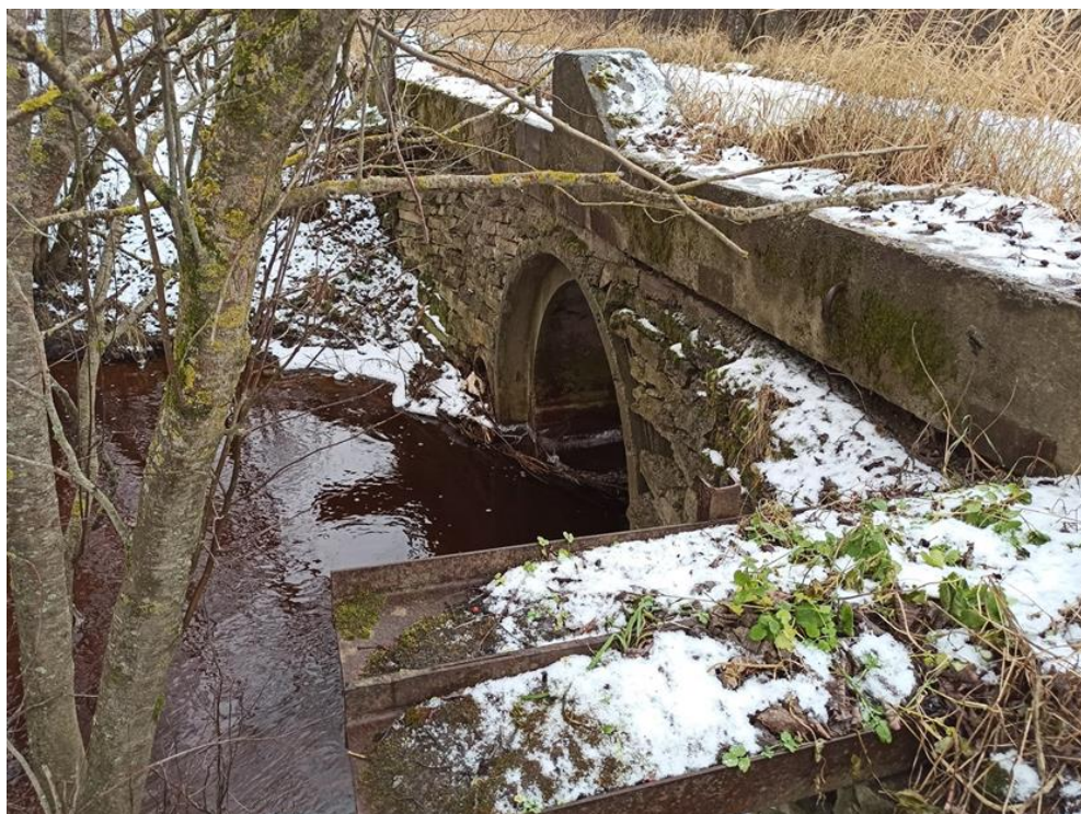
2. Вид объекта с юго-востока.
