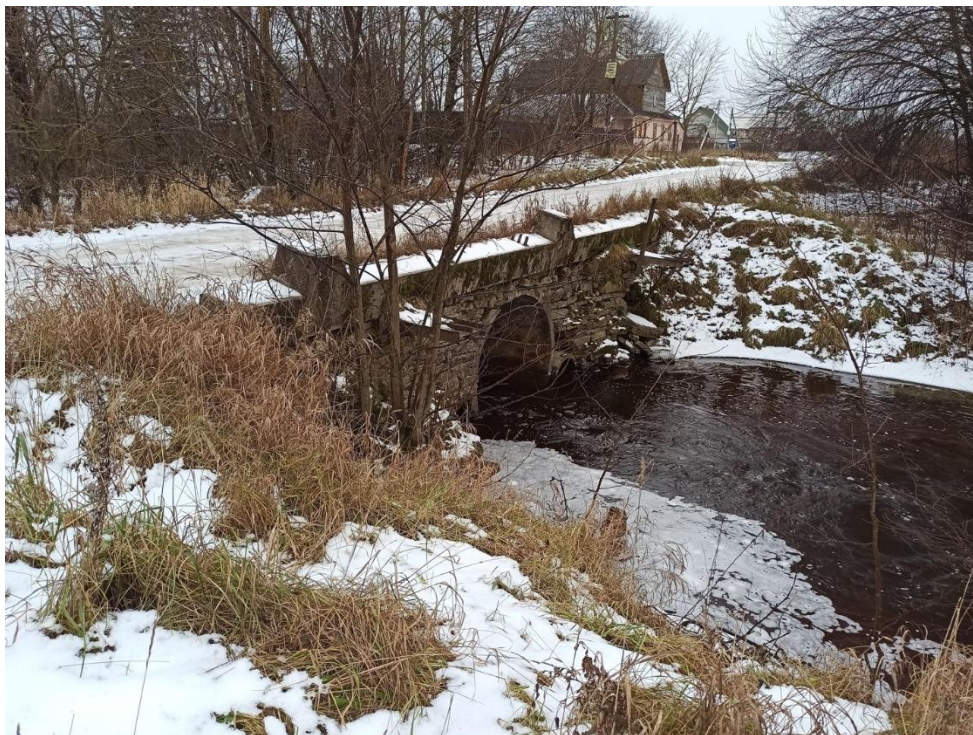
1. Вид объекта с северо-
