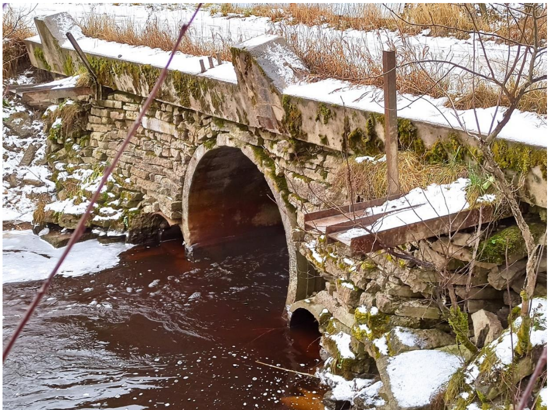
4. Вид объекта с северо-запада.
