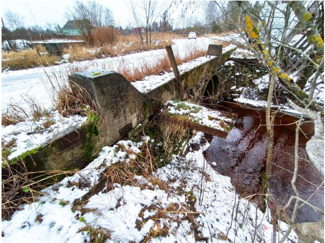
5. Вид объекта с юго-запада.
