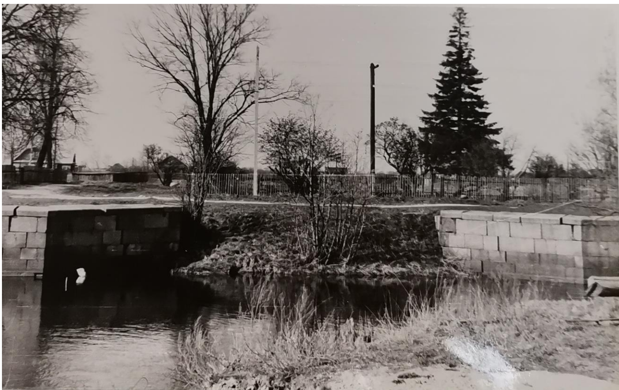
16.1998 г. Водоспуск в Нижней Шальдихе. Источник - Лермонтова М.А. Старо-Ладожский канал. История строительства и архитектура его зданий и сооружений. Дисс. на соискание ученой степени кандидата искусствоведения. СПб, 1998, с.327
