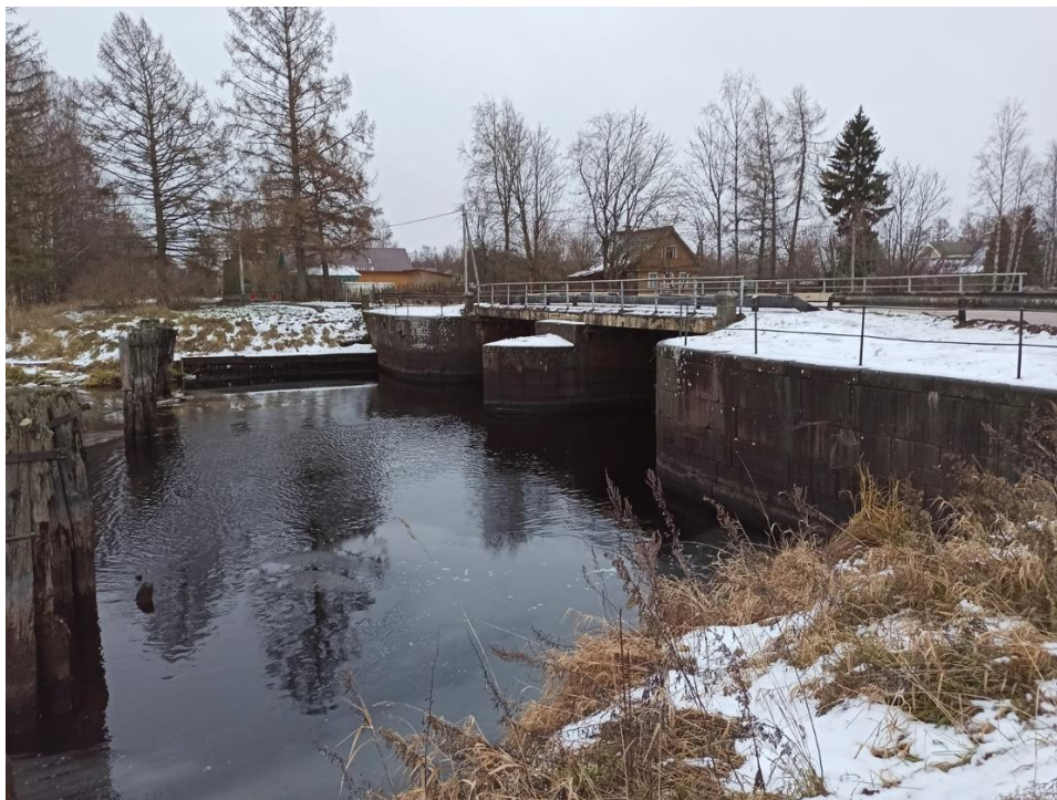
1. Вид объекта с севера.
