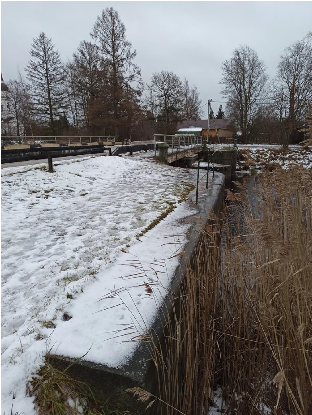
7. Вид объекта с севера.
