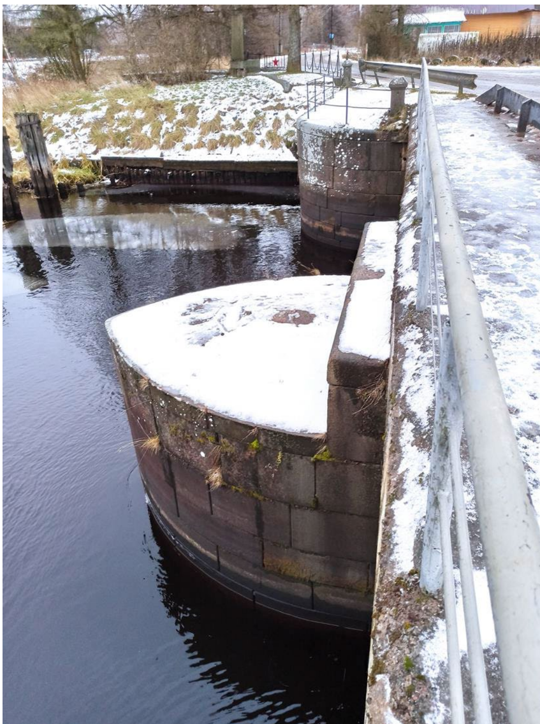
3. Вид объекта с севера.
