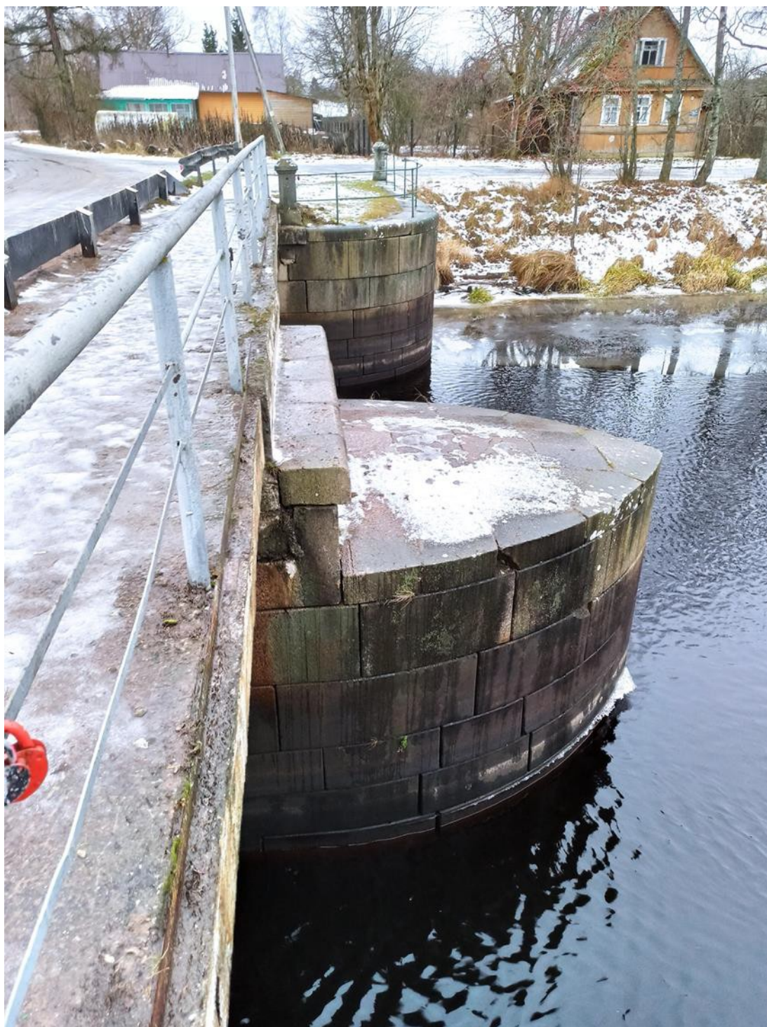
4. Вид объекта с севера.
