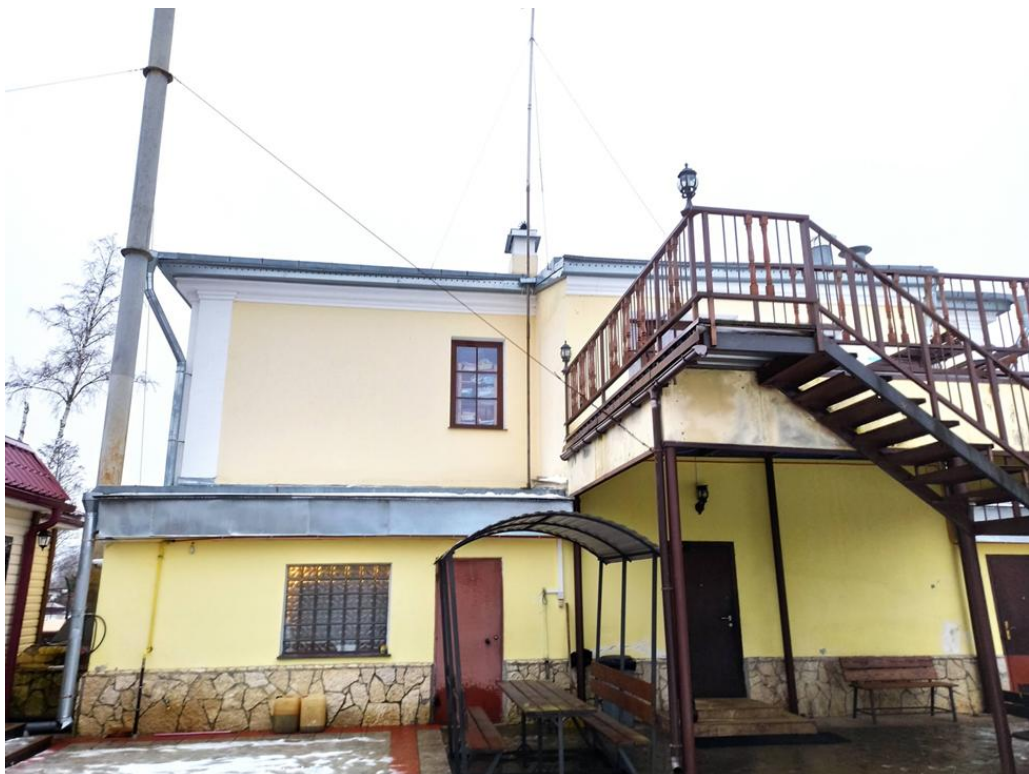
4. Вид здания с востока.
