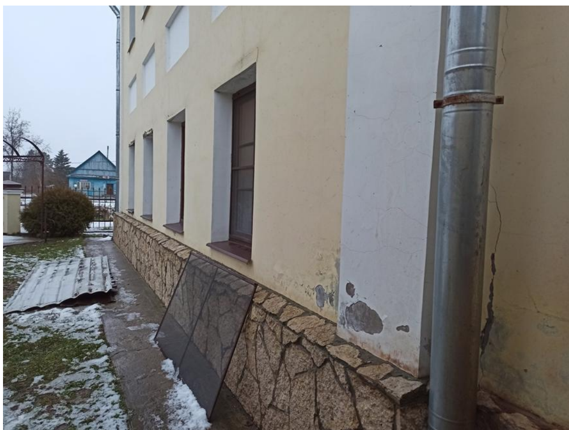
7. Фрагмент фасада здания. Вид с юго-востока.
