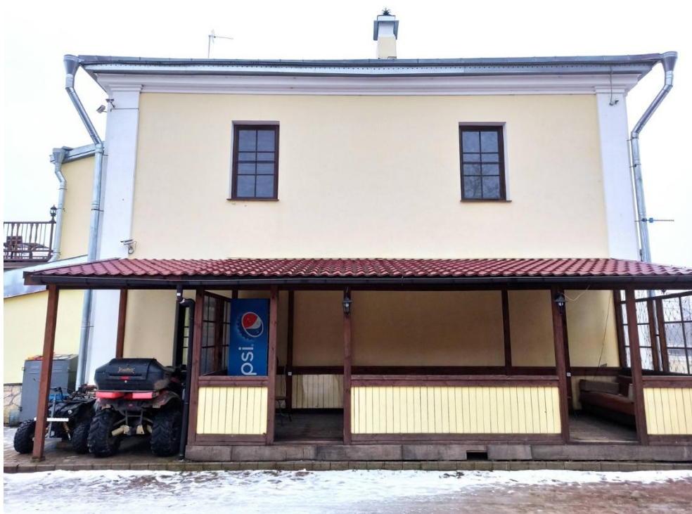
2. Вид здания с севера.
