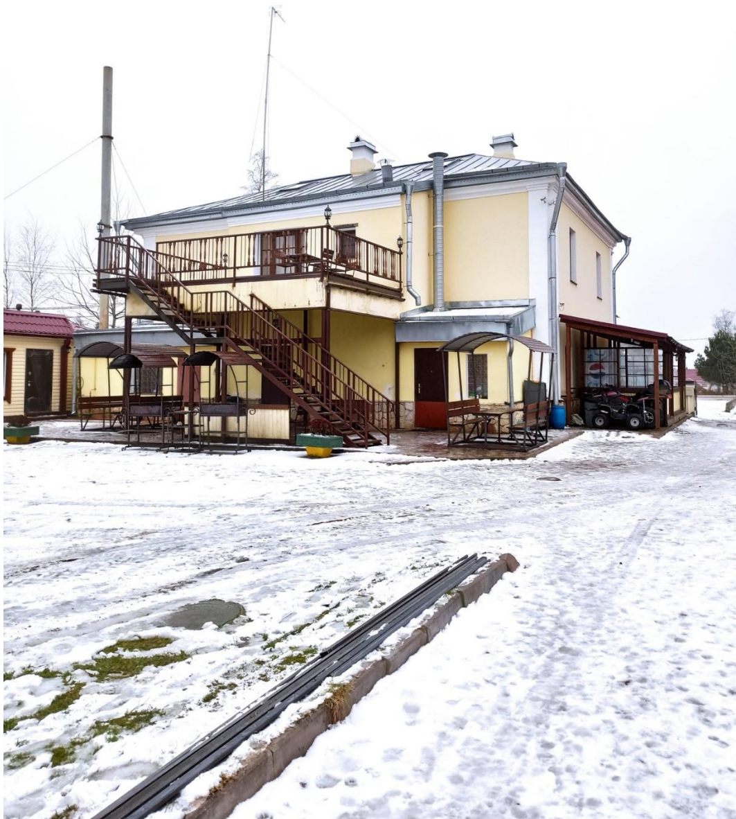
5. Вид здания с северо-востока.
