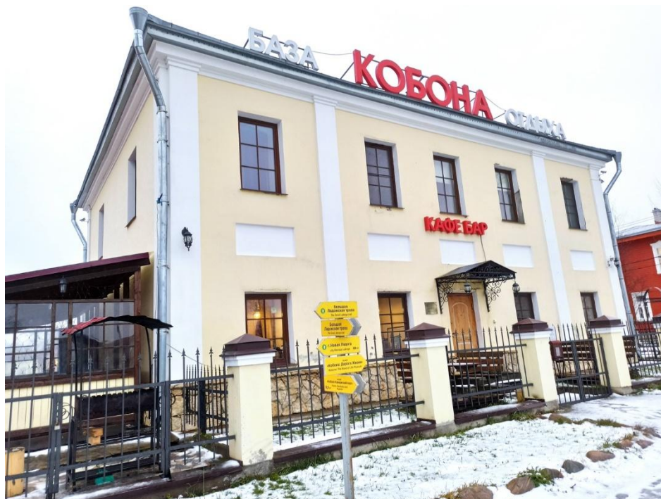
1. Вид здания с северо-запада.
