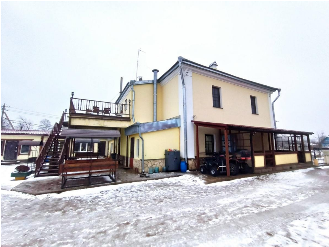
3. Вид здания с северо-востока.
