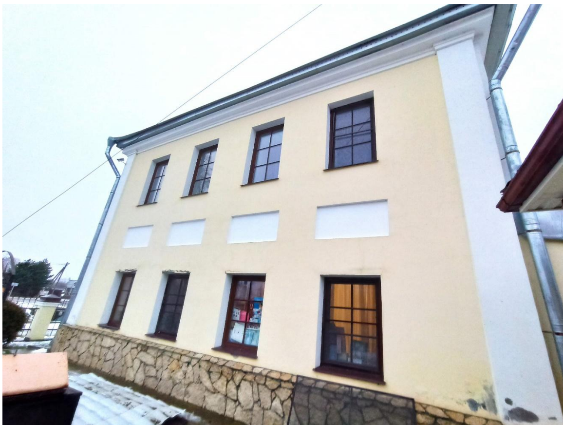
6. Фрагмент фасада здания. Вид с юго-востока.
