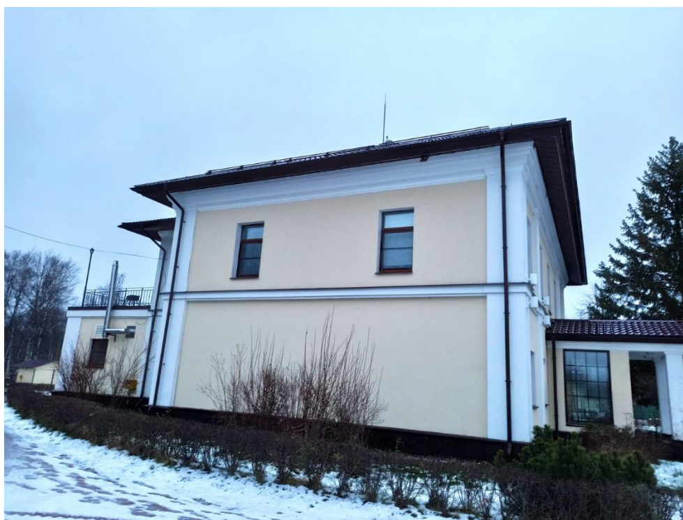
2. Вид объекта с юго-запада.
