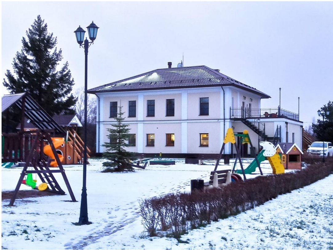
3. Вид обьекта с северо-востока.
