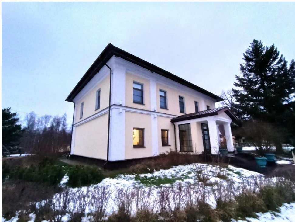
1. Вид объекта с юга.
