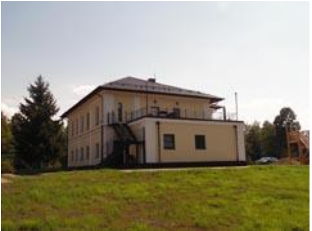
16. 2015 г. Общий вид караульного дома. Источник - http://photoprogulki.narod.ru/lad1_b_ozerki.htm .
