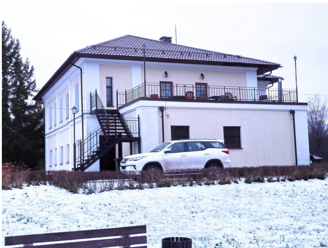
6. Вид обьекта с севера.
