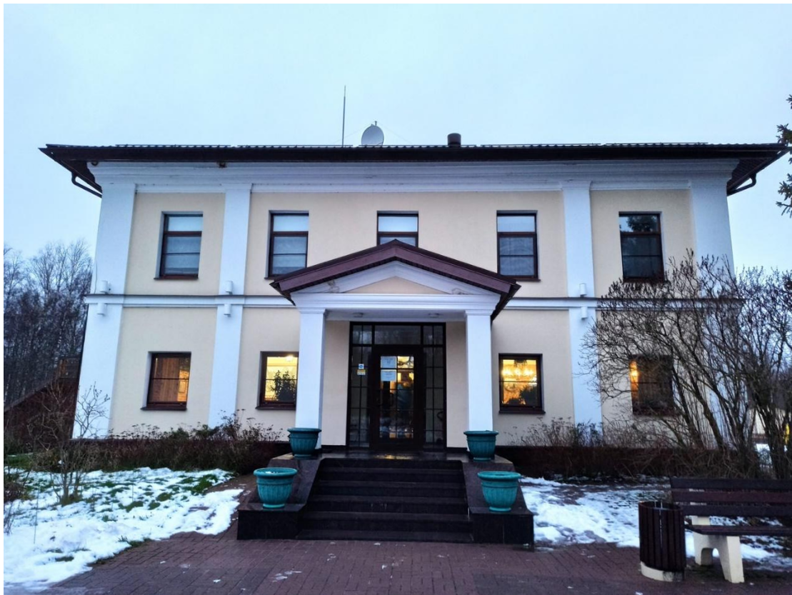
4. Вид обьекта с юго-востока.
