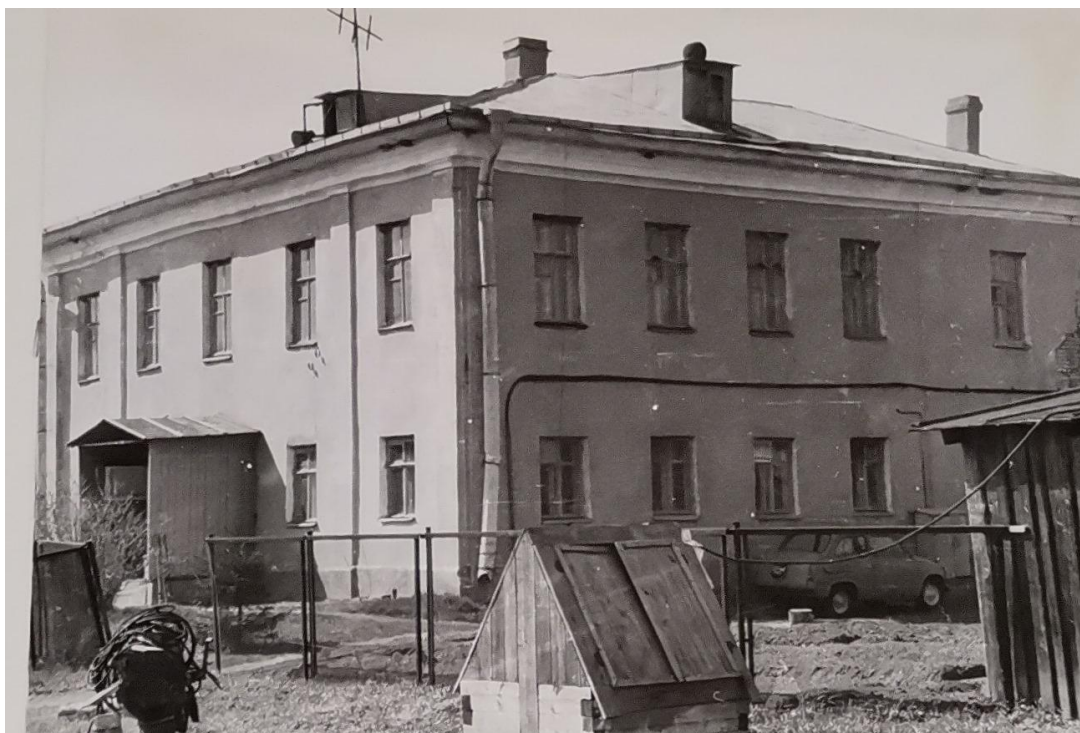
12. 1997 г. Общий вид караулки в Белозерке. Фото из: Лермонтова М.А. Старо-Ладожский канал. История строительства и архитектура его зданий и сооружений. Диссертация на соискание ученой степени кандидата искусствоведения. РАХ, СПб Государственный академический институт живописи, скульптуры и архитектуры им. И.Е. Репина, 1997 г., с. 384.
