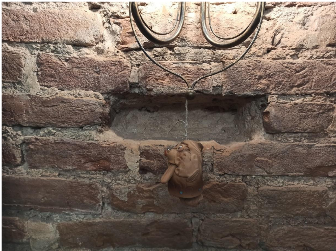
17. Фрагмент стены в интерьере одного из помещений второго этажа объекта.
