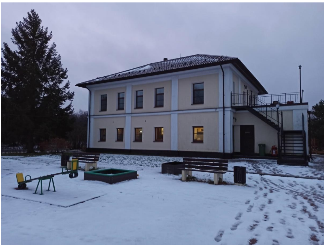
5. Вид обьекта с северо-востока.
