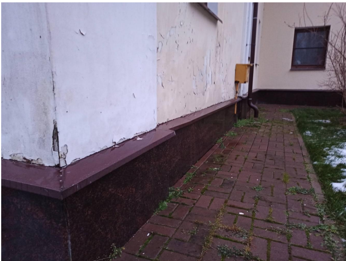
9. Фрагмент фасада объекта. Вид с северо-запада.
