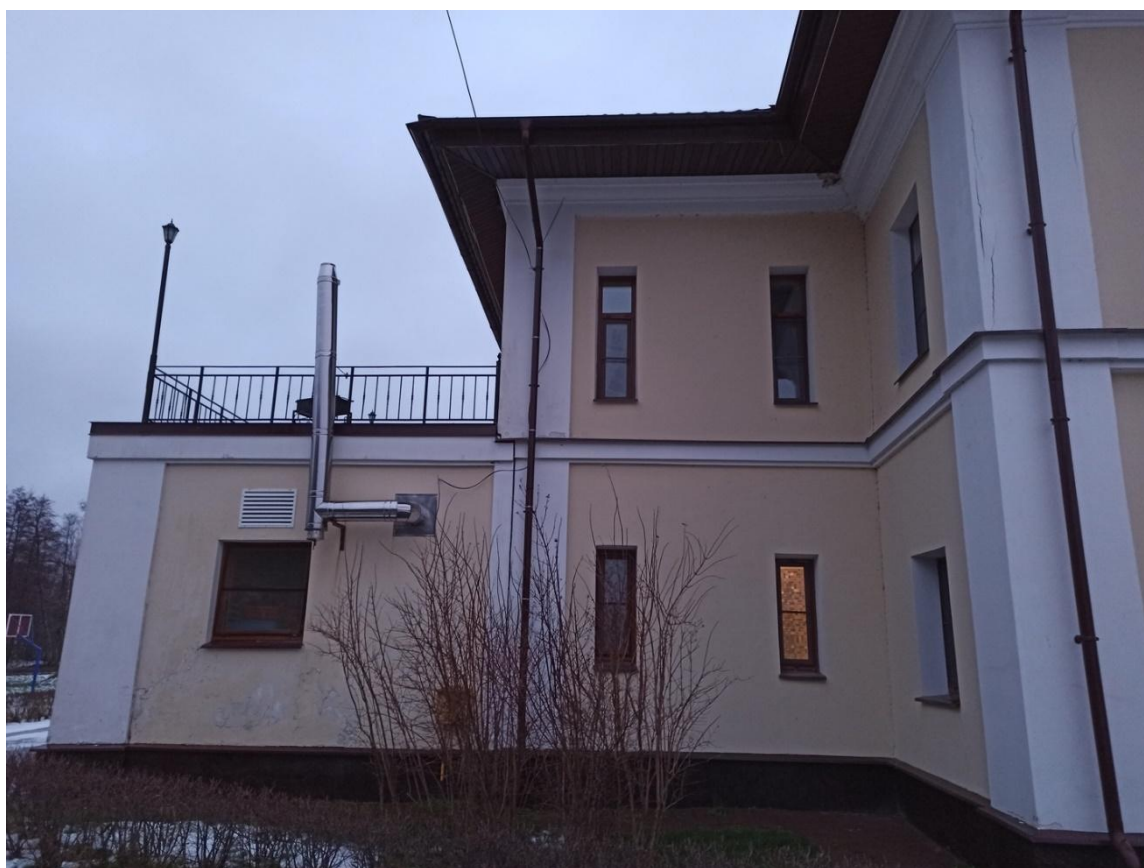
10. Фрагмент фасада объекта. Вид с юго-запада.
