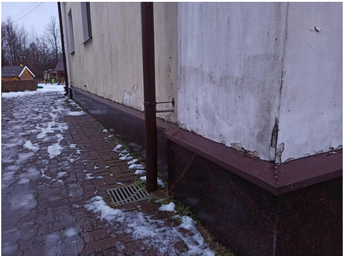
8. Фрагмент фасада обьекта. Вид с запада.
