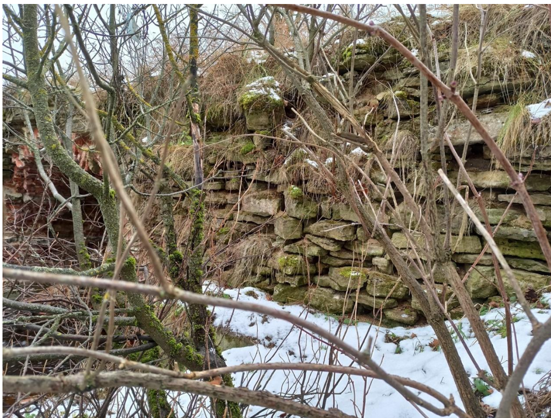
9. Фрагмент обьекта. Вид с севера.
