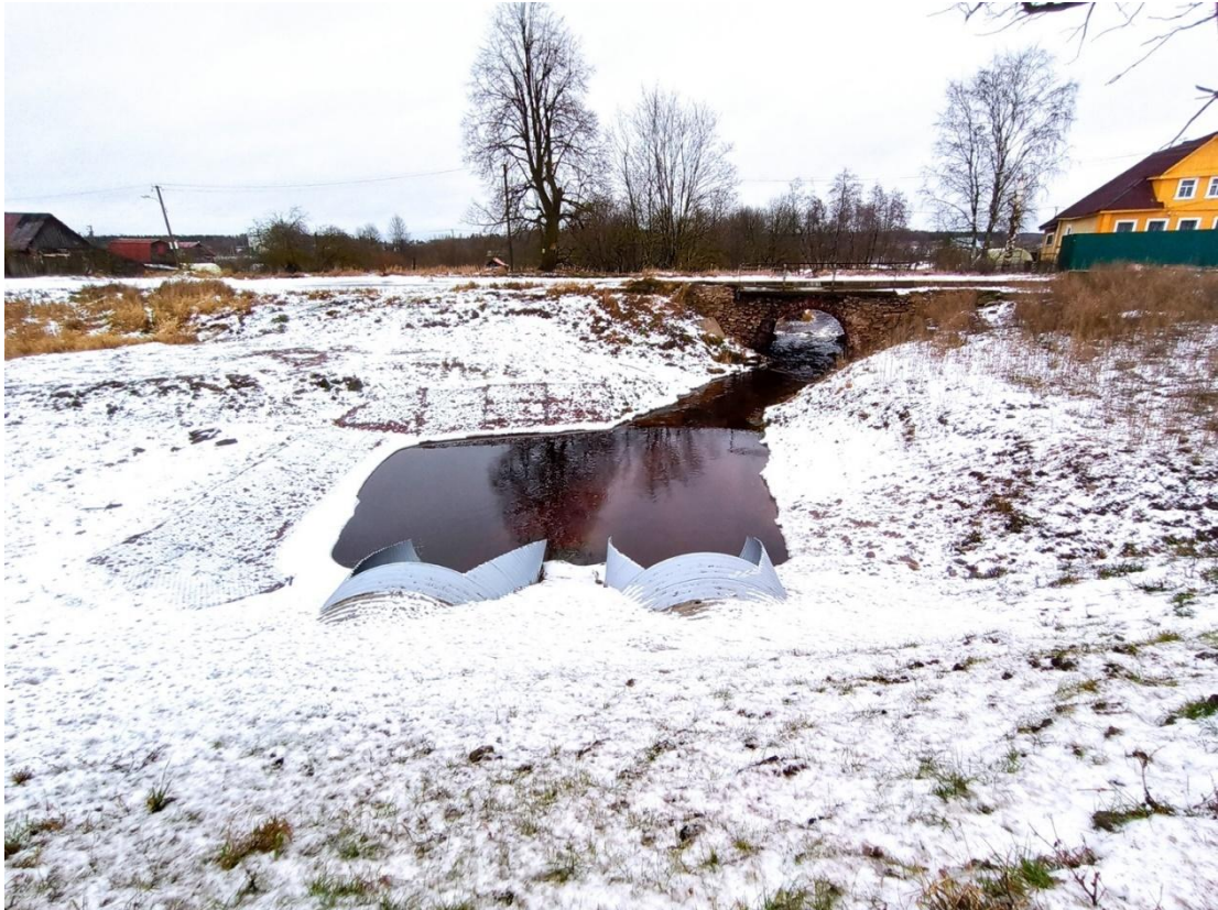
3. Общий вид на объект с юго-запада.
