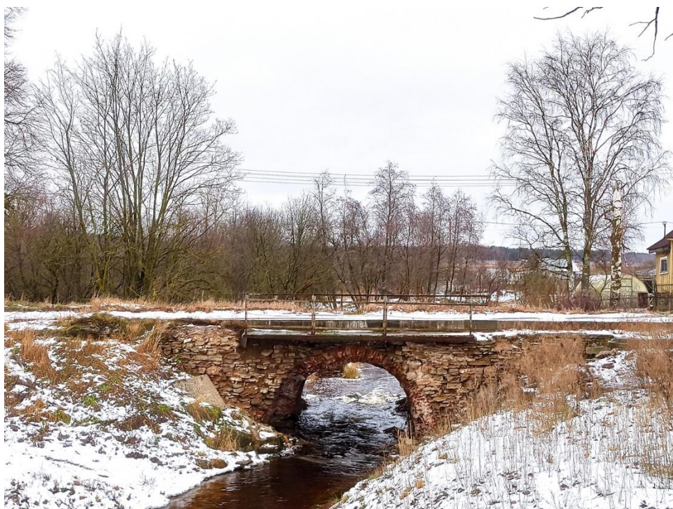
1. Общий вид на объект с юго-запада.
