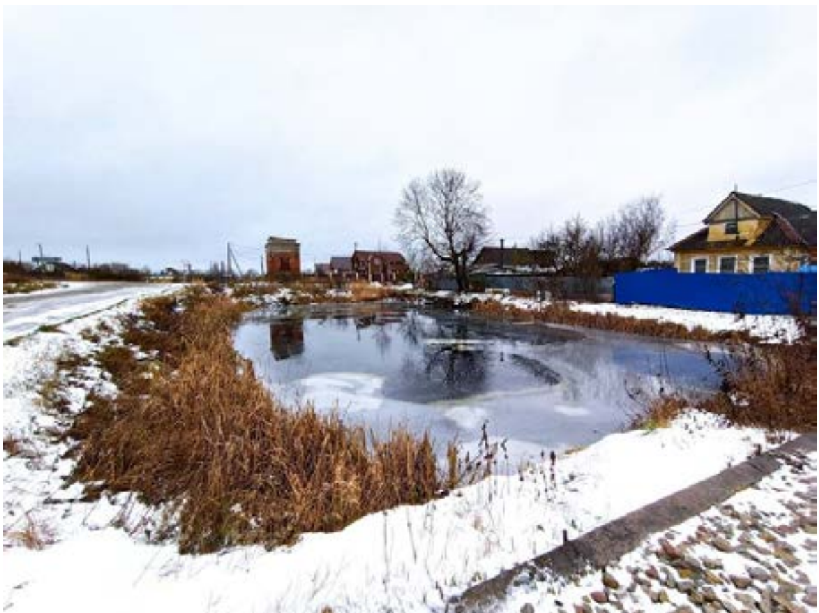
4. Общий вид объекта с юга
