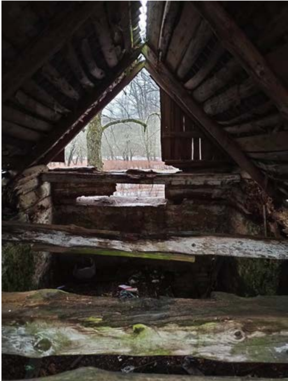
38. Фрагмент интерьера хозяйственной постройки (погреба-ледника) (в составе парка). Вид с востока
