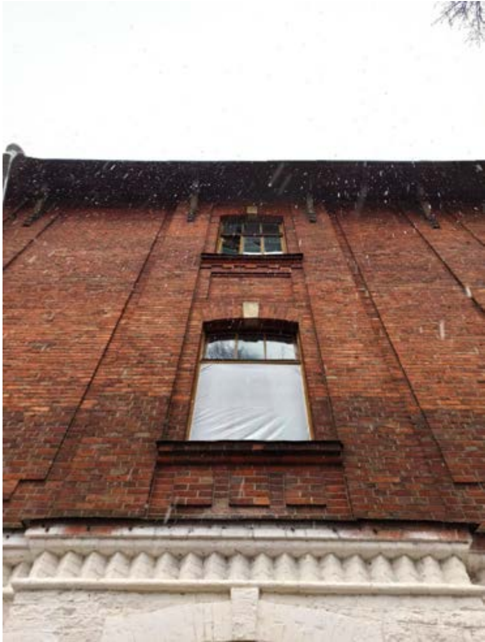
12. Фрагмент фасада здания сельскохозяйственного (земского) училища. Оформление оконных проемов. Вид с запада
