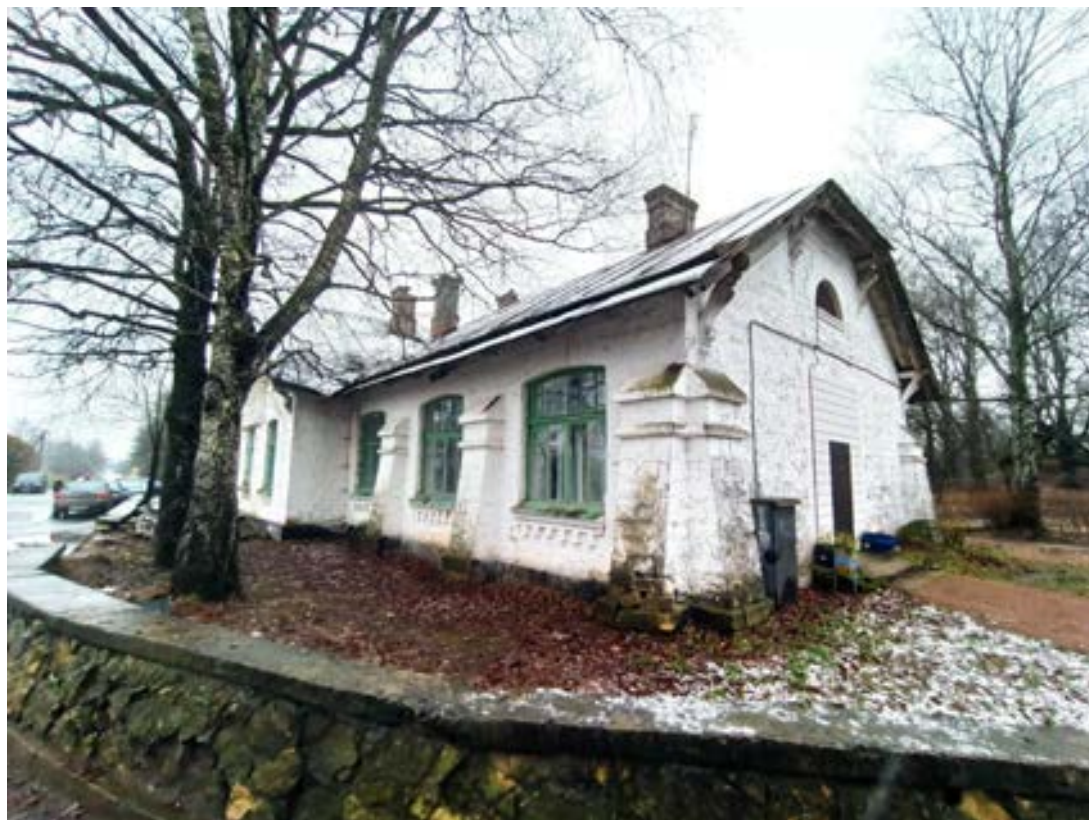
42. Вид здания каменной дачи (административное здание) с северо-востока
