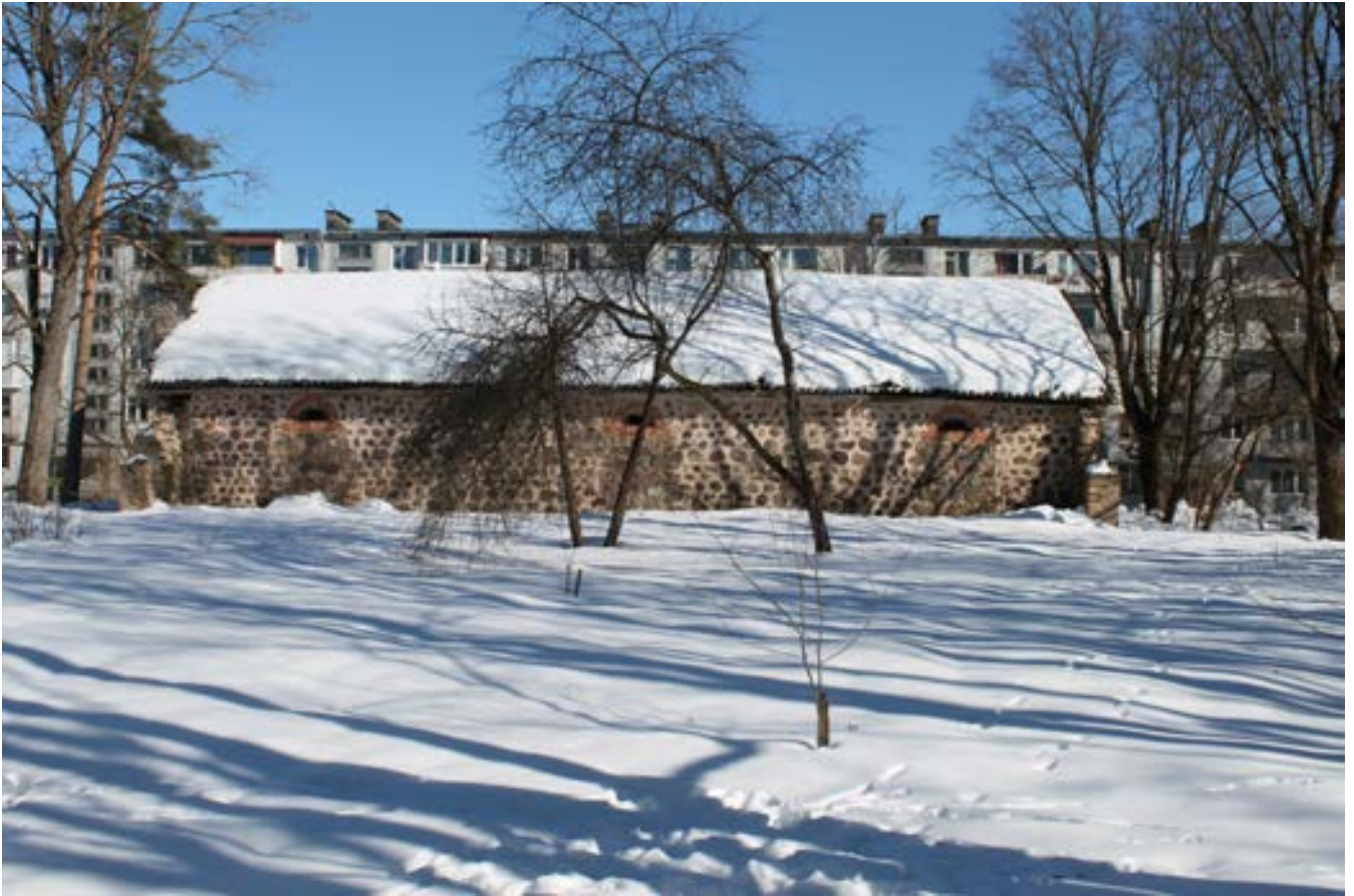
53. Служебная постройка (амбар). Вид с запада
