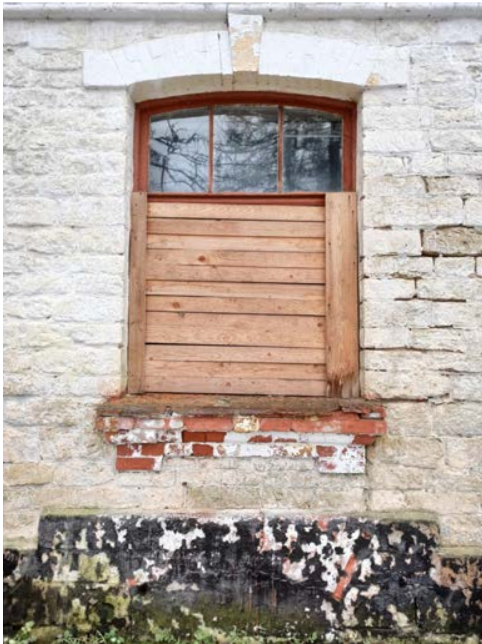
22. Фрагмент фасада здания сельскохозяйственного (земского) училища. Оформление оконного проема первого этажа. Вид с северо-востока
