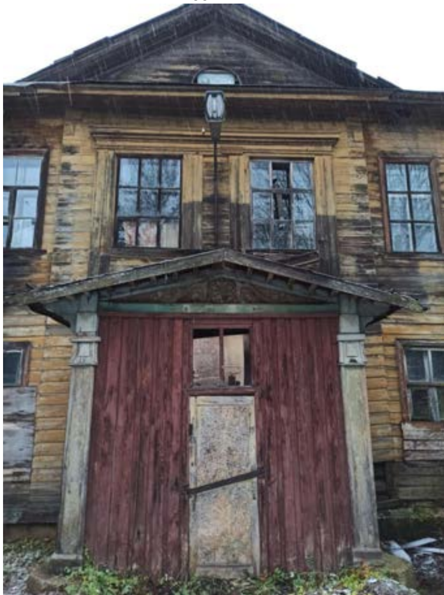
25. Фрагмент фасада жилого дома (деревянного). Вид с юго-востока
