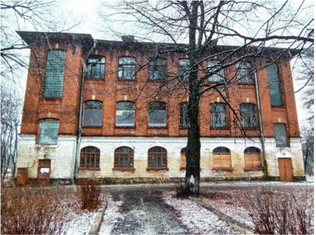
17. Фасад здания сельскохозяйственного (земского) училища. Вид с юго-востока
