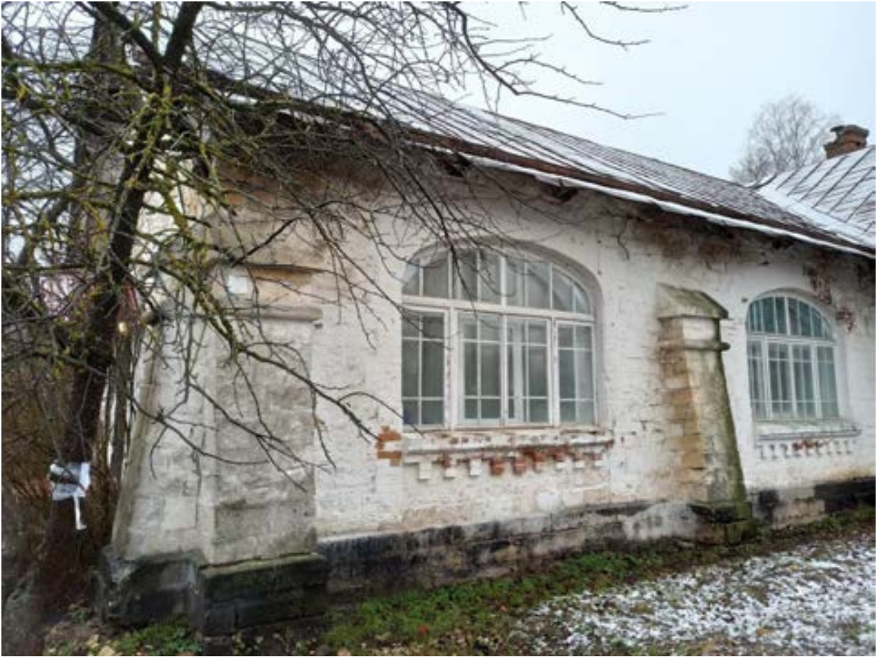
46. Фрагмент фасада здания каменной дачи (административное здание) . Оформление оконных проемов. Вид с востока
