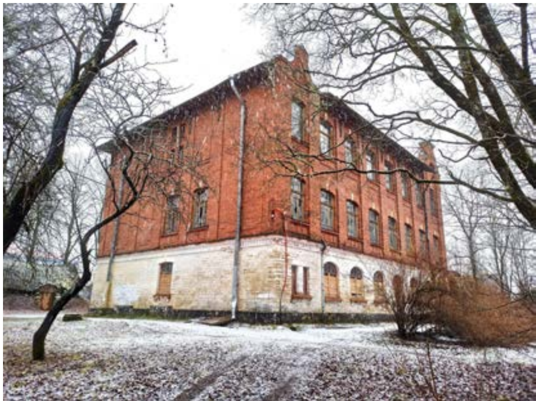
2. Вид здания сельскохозяйственного (земского) училища с северо-востока
