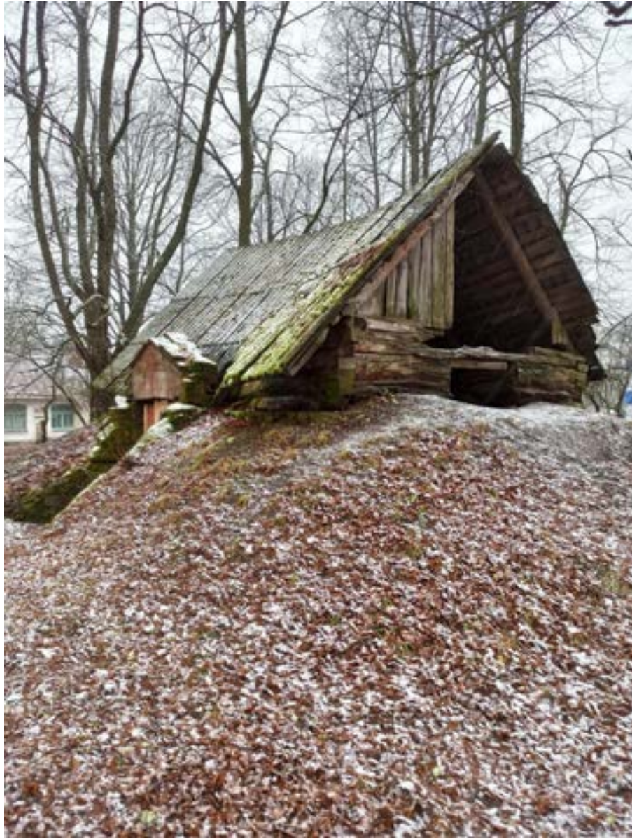
33. Вид хозяйственной постройки (погреб-ледника) (в составе парка) с северо-запада
