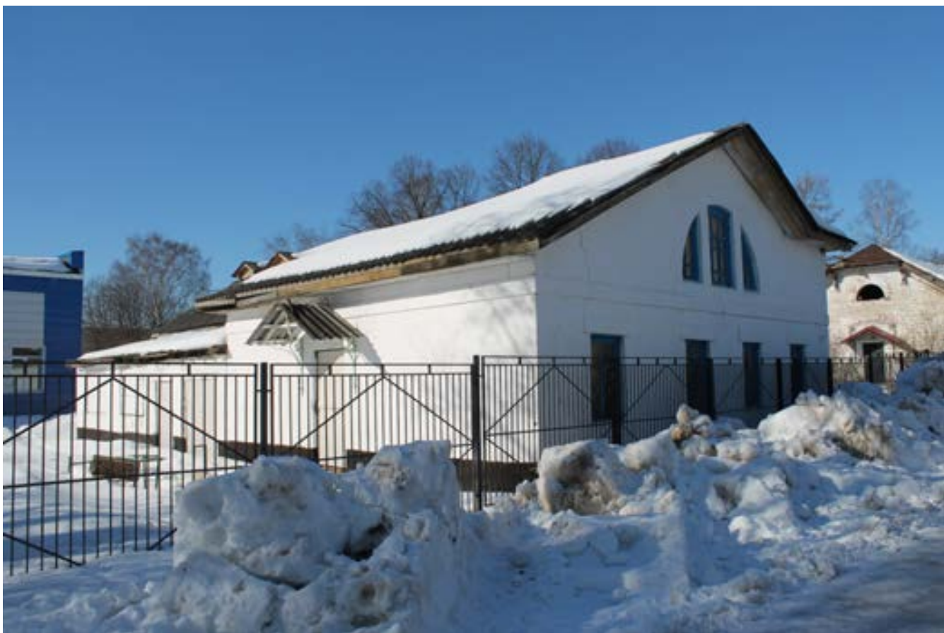
56. Каменный корпус у перекрестка дорог (баня и столовая). Вид с юго-востока
