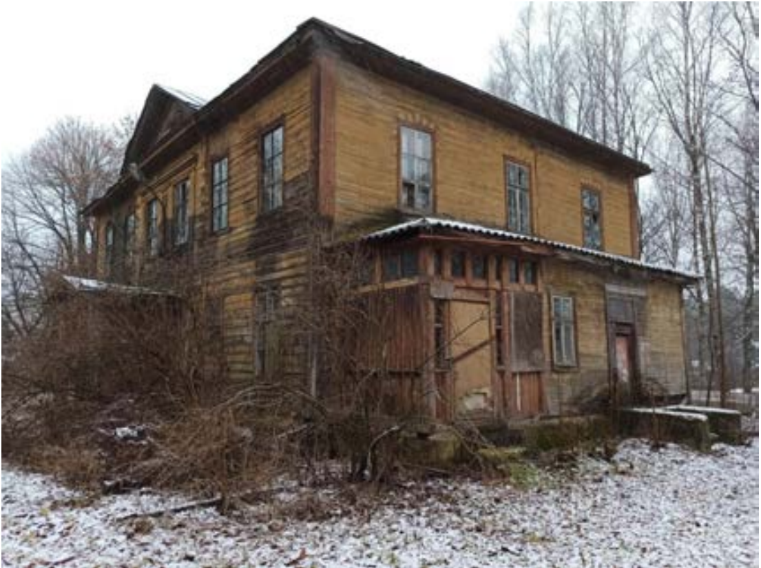
26. Вид жилого дома (деревянного) с востока
