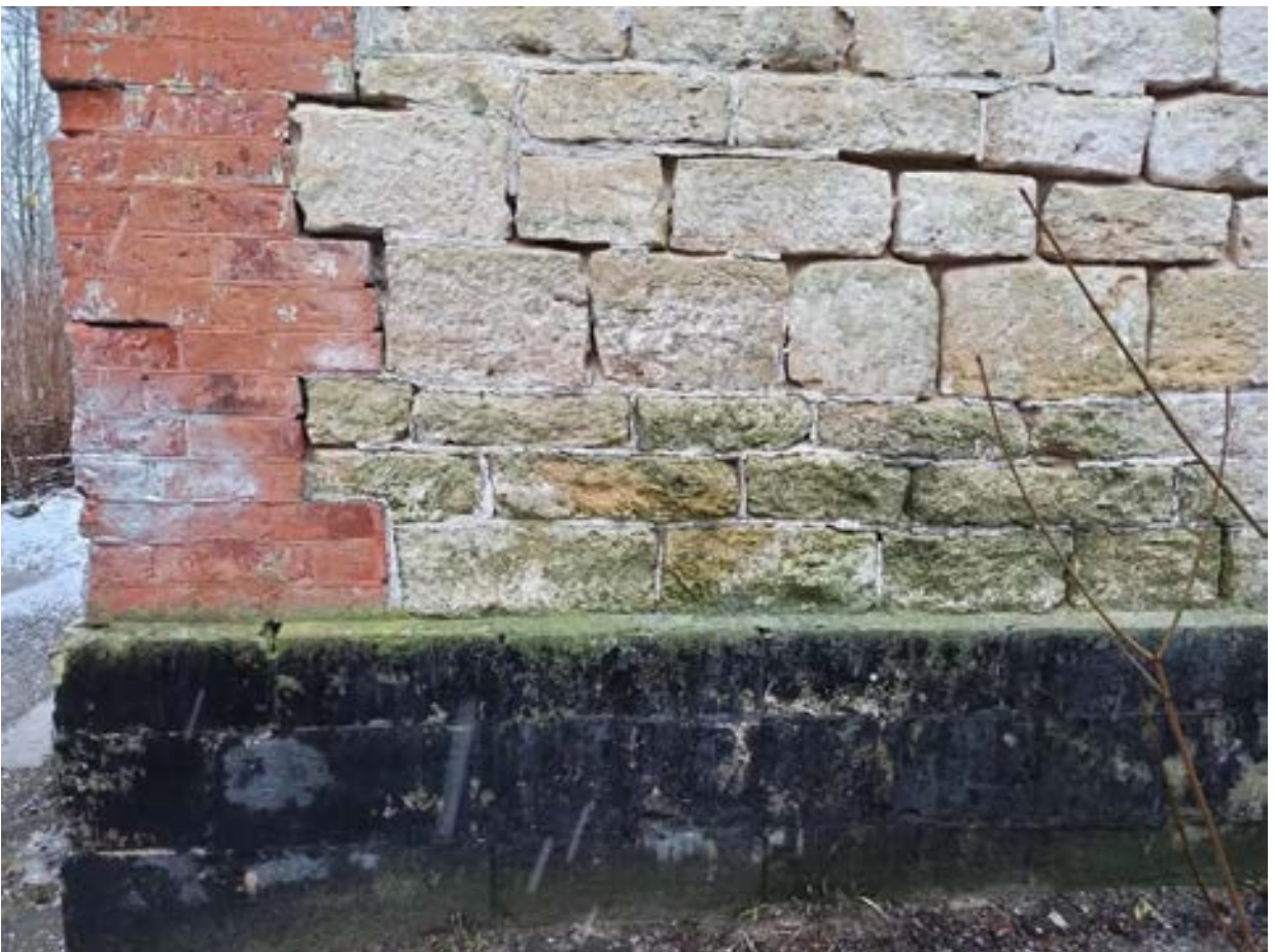
10. Фрагмент фасада здания сельскохозяйственного (земского) училища. Вид с запада
