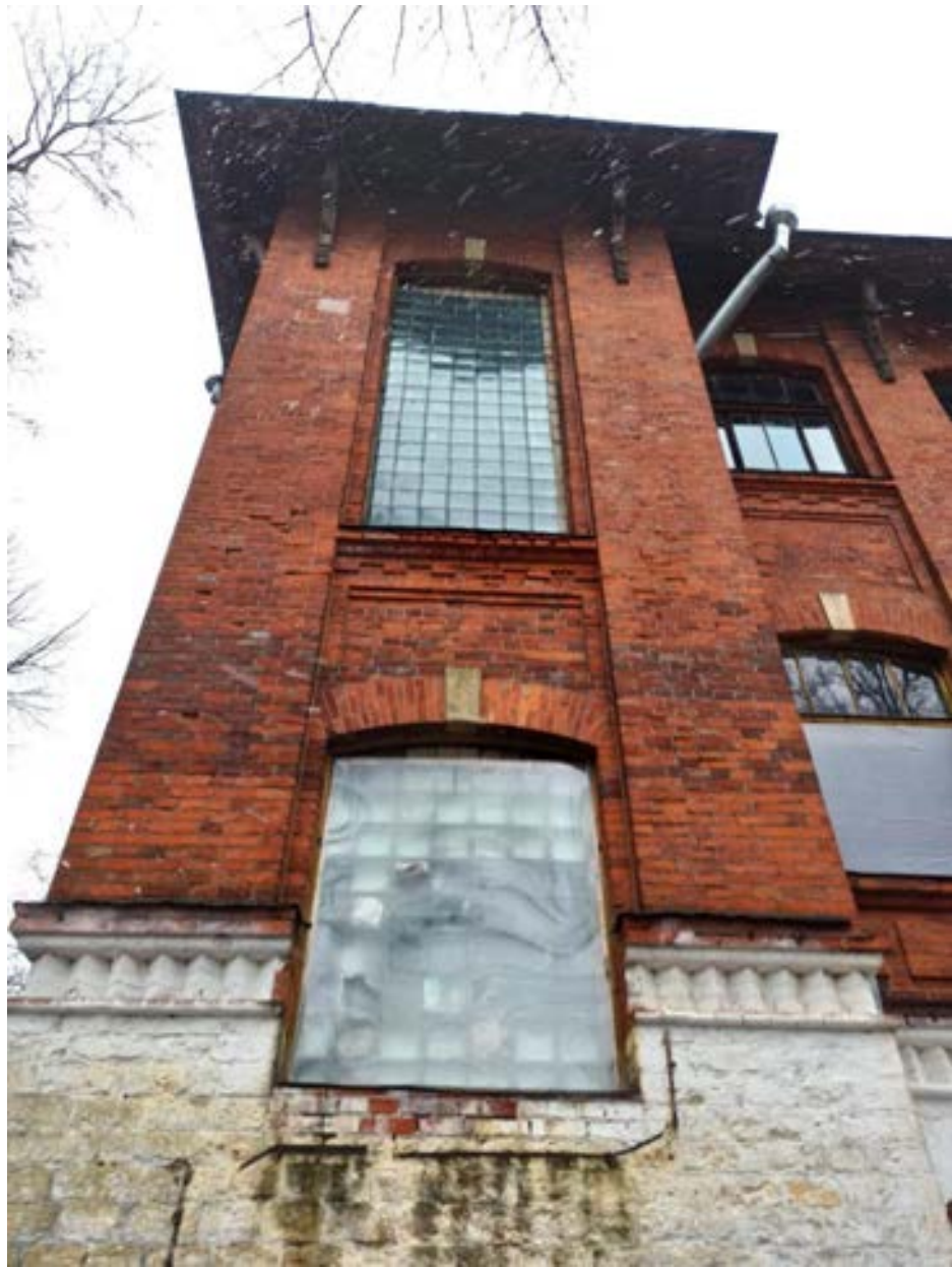
15. Фрагмент фасада здания сельскохозяйственного (земского) училища. Оформление оконных проемов. Вид с юго-востока
