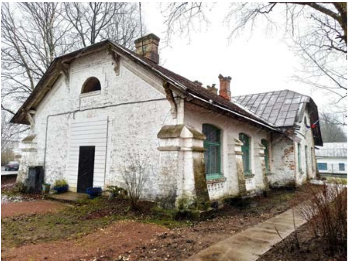
40. Вид здания каменной дачи (административное здание) с северо-запада
