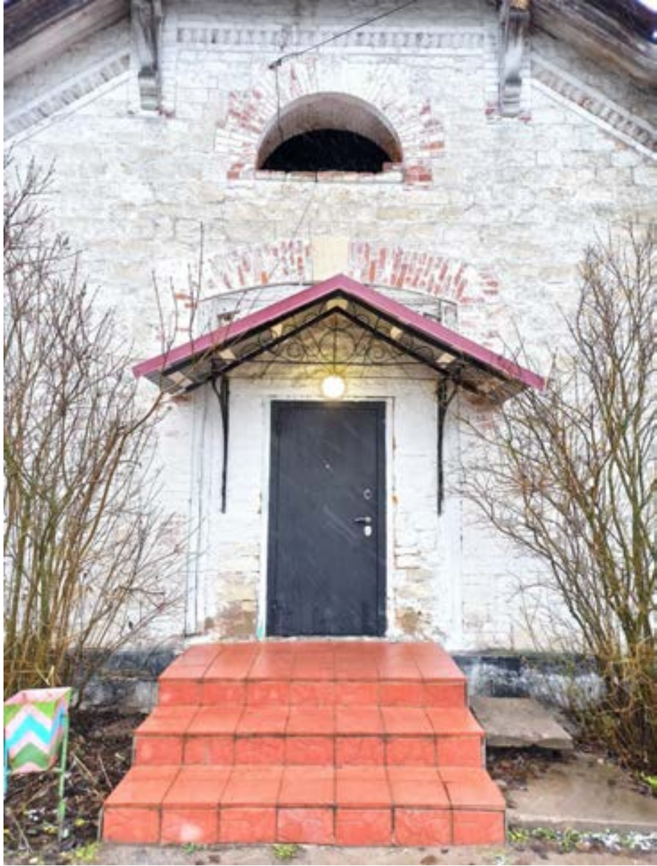
48. Фрагмент фасада здания каменной дачи (административное здание) . Дверь входа. Вид с юго-востока
