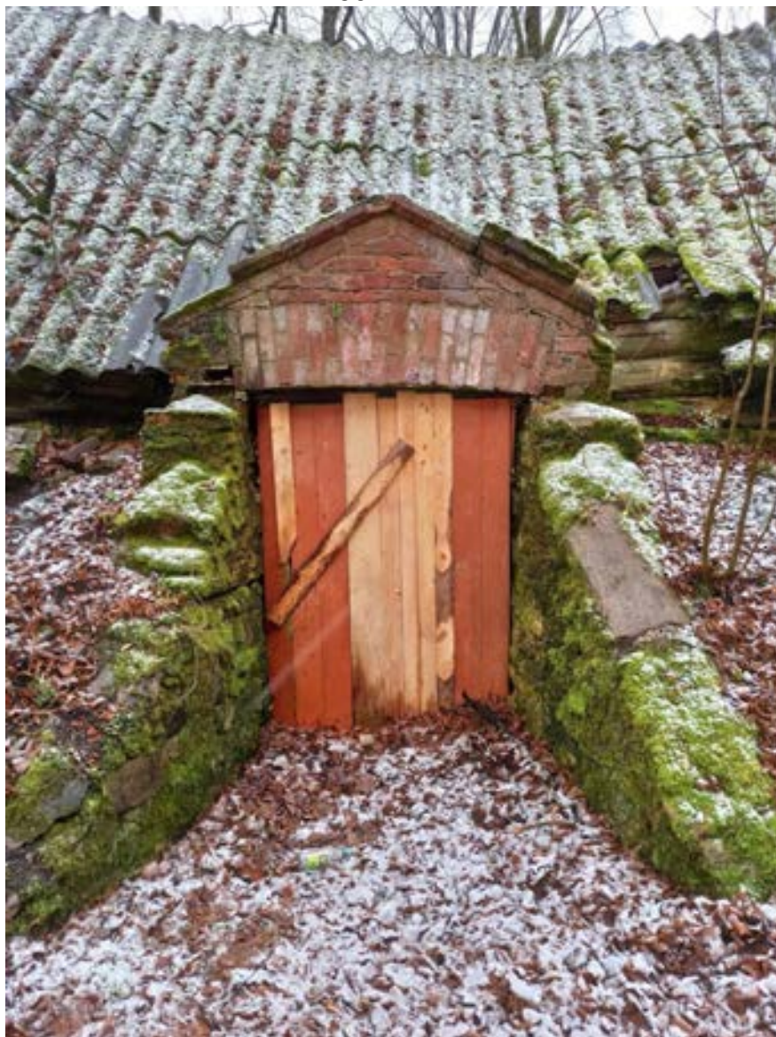
32. Дверь входа хозяйственной постройки (погреба-ледника) (в составе парка) с севера
