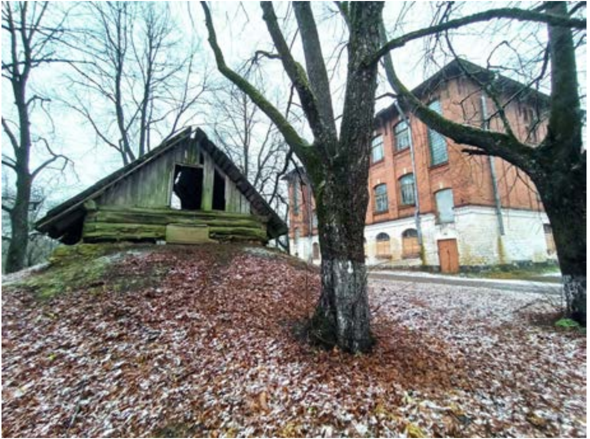
39. Общий вид хозяйственной постройки (погребаледника) (в составе парка) и здания сельскохозяйственного (земского) училища с востока
