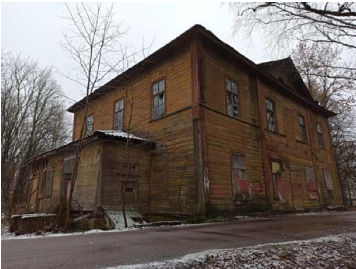
28. Вид здания жилого дома (деревянного) с севера
