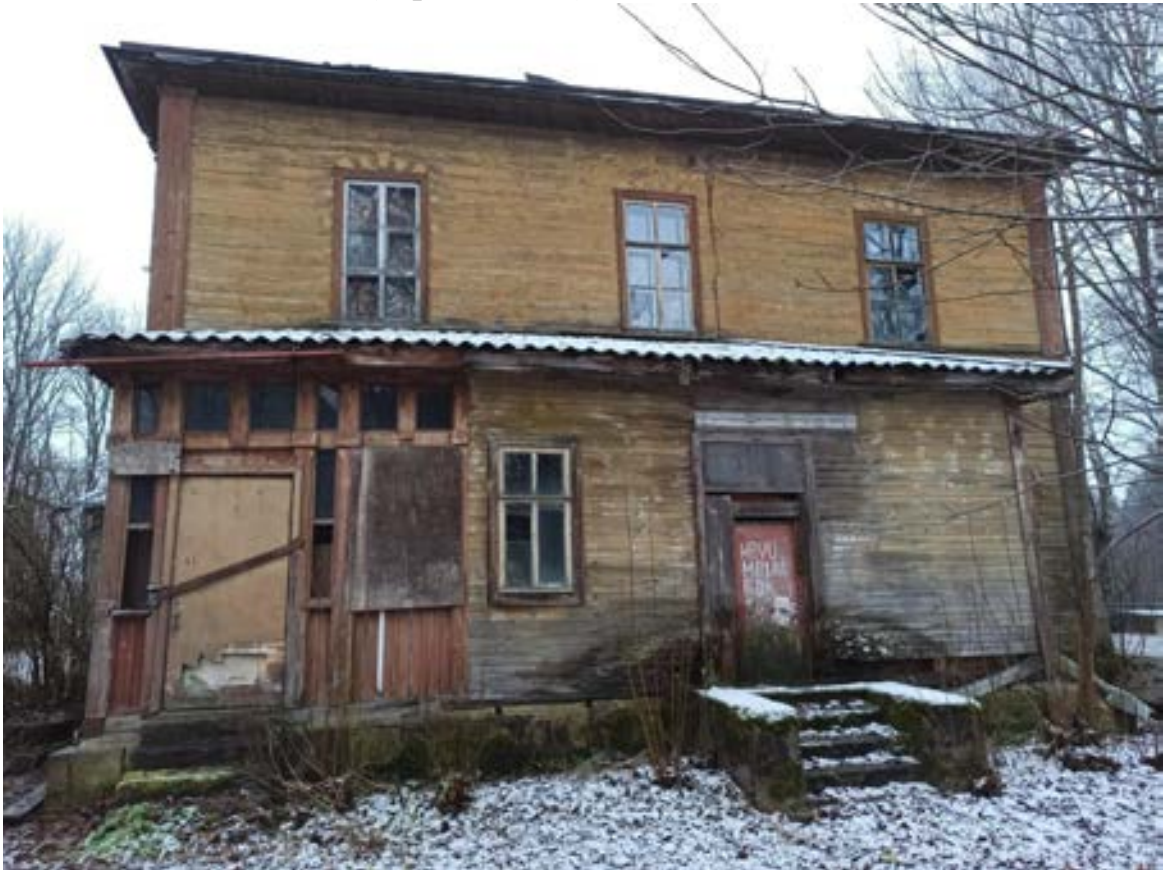
27. Фасад здания жилого дома (деревянного). Вид с северо-востока
