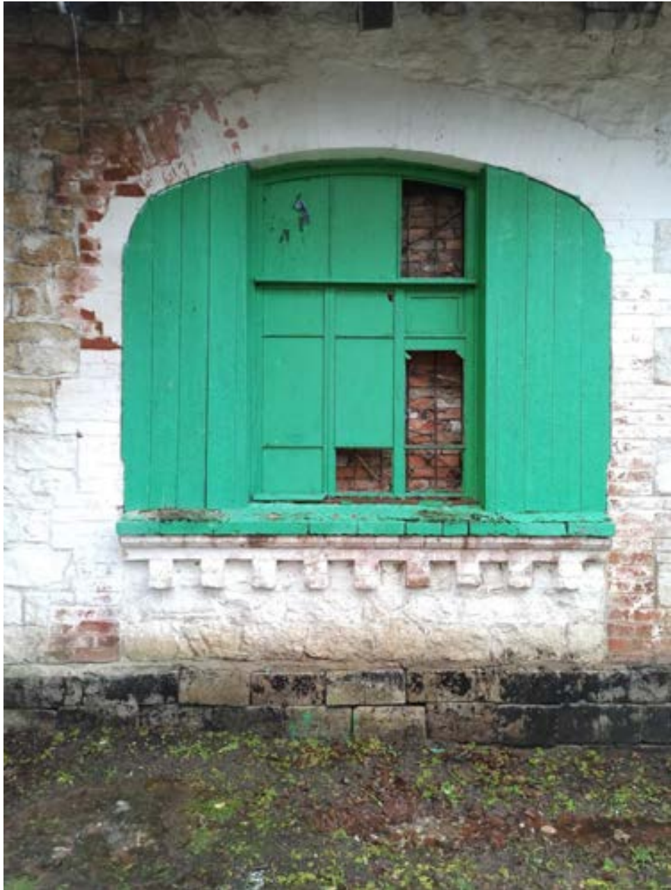
51. Фрагмент фасада здания каменной дачи (административное здание). Оформление оконного проема. Вид с запада
