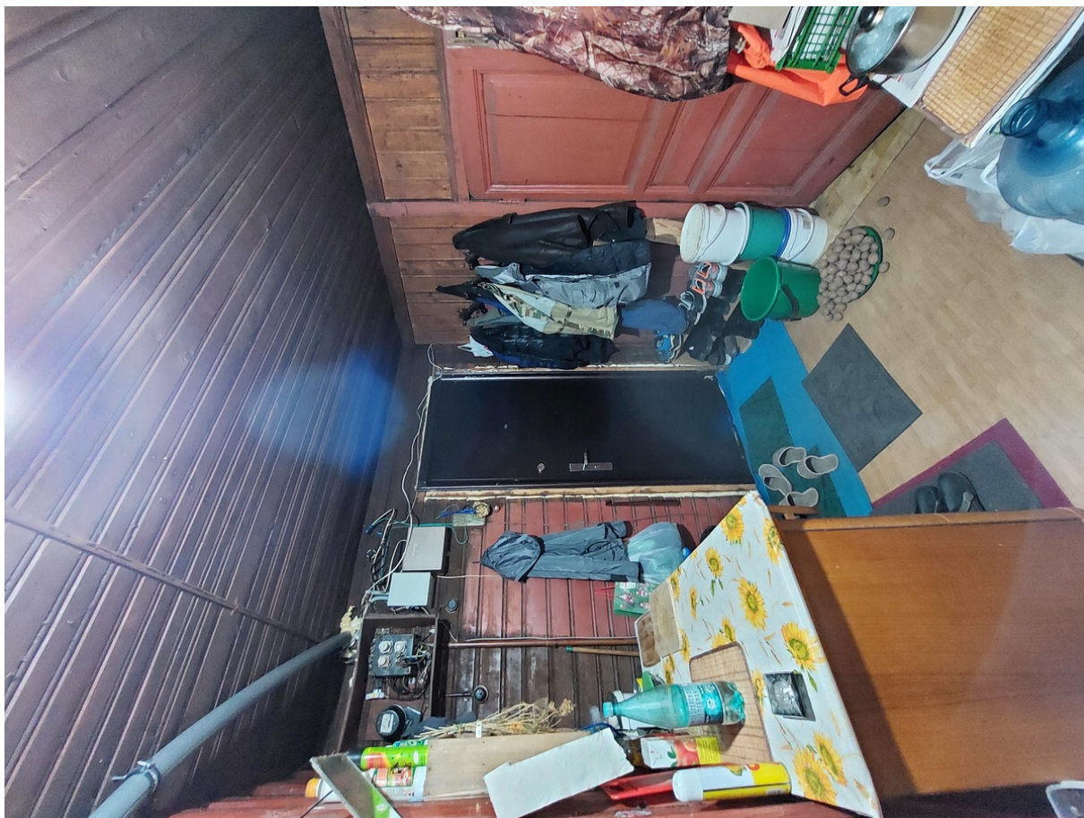
14 ОКН регионального значения “Жилой дом - бывший дом Шаровой, впоследствии Кирилловой, XVIII-XIX вв.” Ленинградская область, Волховский район, г. Новая Ладога, ул. Пионерская, д. 3. Западный подъезд. 2 этаж. Дата съемки: 30.06.2022 г.
