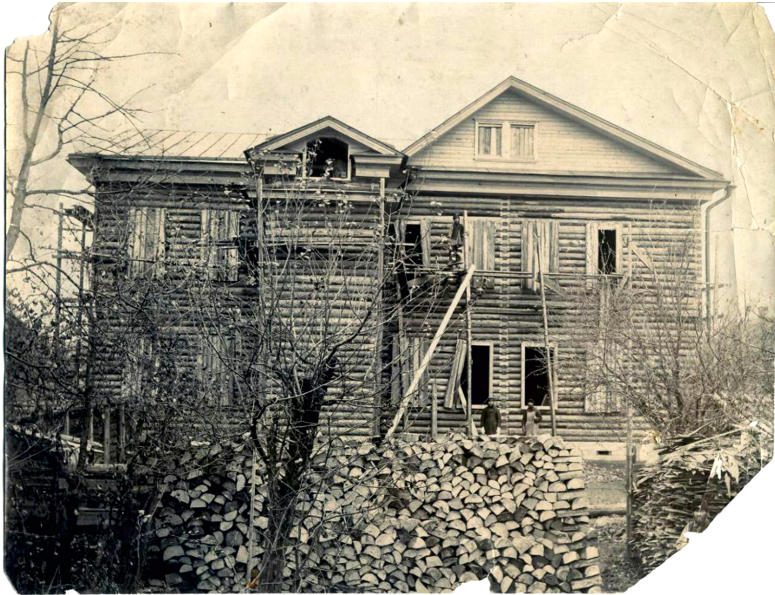
Ил. 8. Строительство дома М.Н. Йорса. Вид со стороны двора. Фотография 1897 г. Новолодожский историко-краеведческий музей. НЛМ КП-2557. Ф-803
