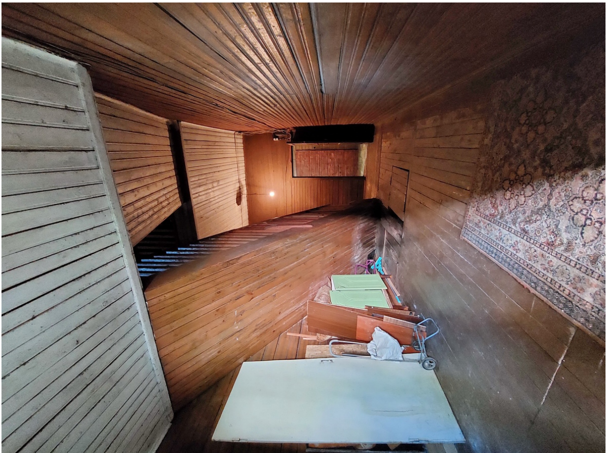
10 ОКН регионального значения “Жилой дом - бывший дом Йорса, 1898 г.” Ленинградская область, Волховский район, г. Новая Ладога, ул. Горького, д. 7/9. 1 этаж. Лестничная клетка. Дата съемки: 30.06.2022 г.
