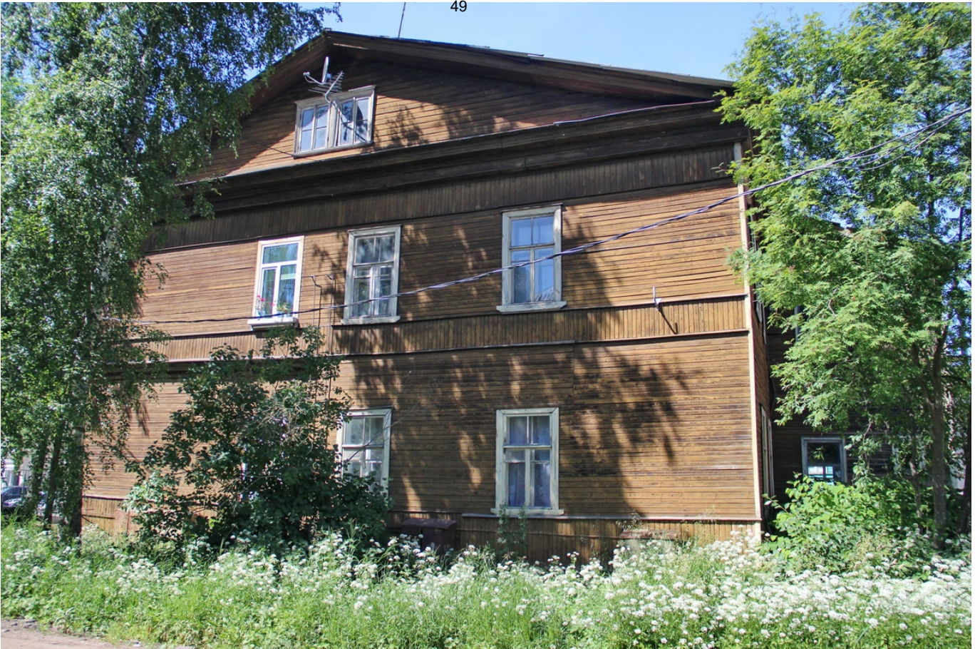
7 ОКН регионального значения “Жилой дом - бывший дом Йорса, 1898 г.” Ленинградская область, Волховский район, г. Новая Ладога, ул. Горького, д. 7/9. Юго-восточный фасад. Дата съемки: 30.06.2022 г.
