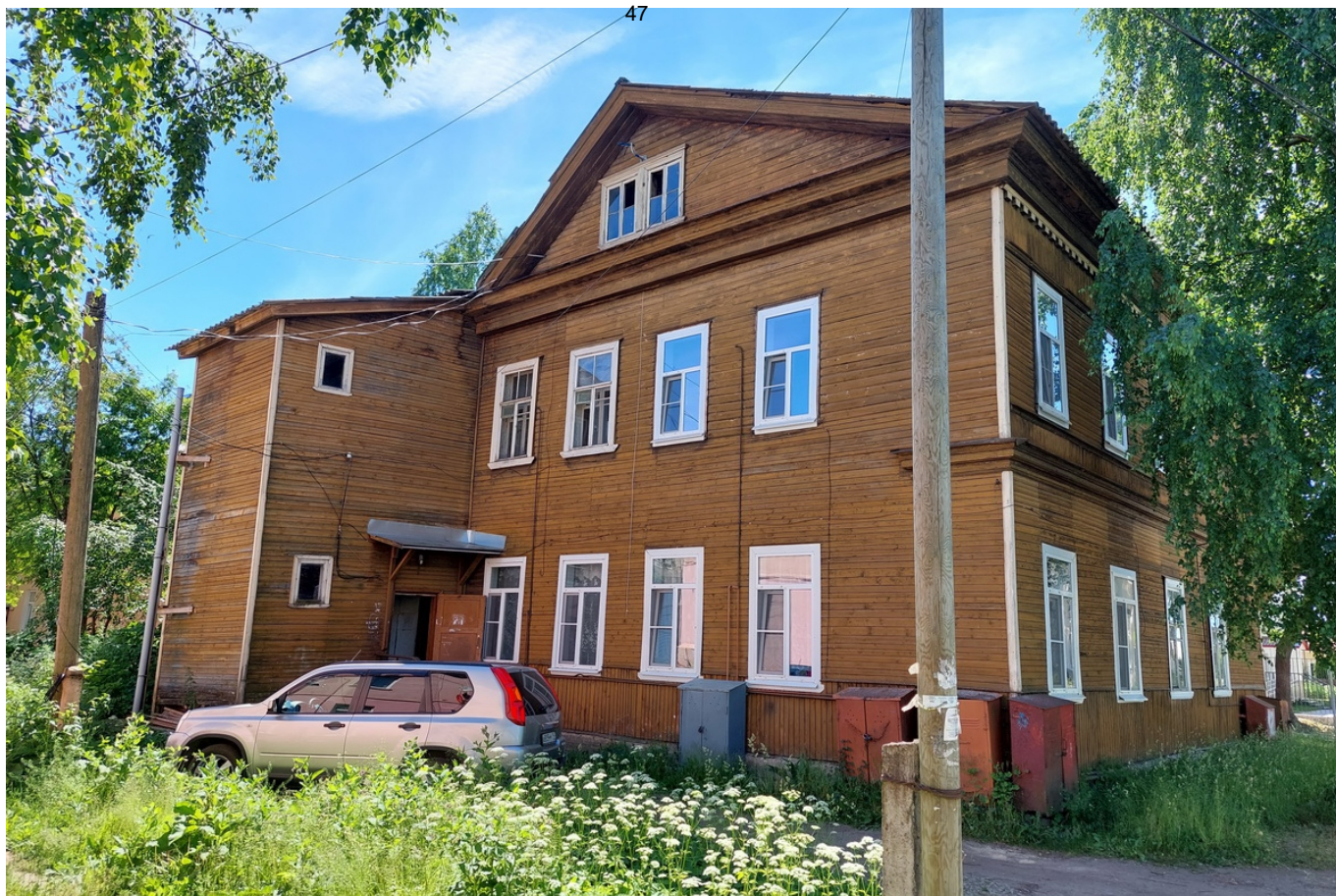
3 ОКН регионального значения “Жилой дом - бывший дом Йорса, 1898 г.” Ленинградская область, Волховский район, г. Новая Ладога, ул. Горького, д. 7/9. Северо-восточный фасад. Дата съемки: 30.06.2022 г.
