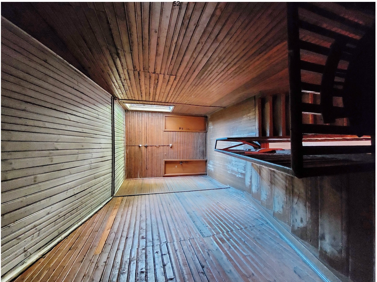
52 13 ОКН регионального значения “Жилой дом - бывший дом Йорса, 1898 г.” Ленинградская область, Волховский район, г. Новая Ладога, ул. Горького, д. 7/9. 2 этаж. Лестничная клетка. Дата съемки: 30.06.2022 г.
