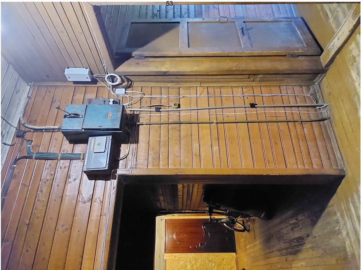
53 15 ОКН регионального значения “Жилой дом - бывший дом Йорса, 1898 г.” Ленинградская область, Волховский район, г. Новая Ладога, ул. Горького, д. 7/9. 2 этаж. Коридор. Дата съемки: 30.06.2022 г.
