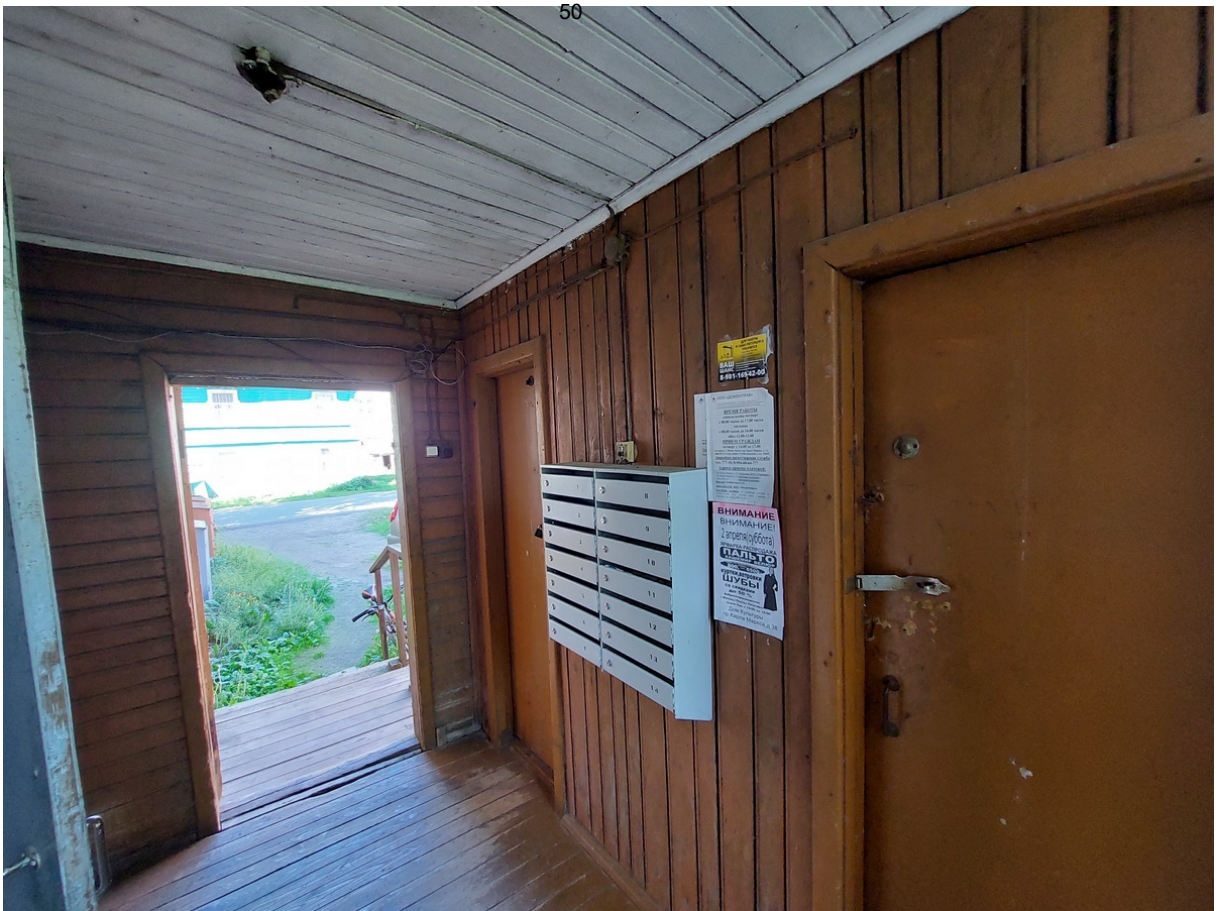
9 ОКН регионального значения “Жилой дом - бывший дом Йорса, 1898 г.” Ленинградская область, Волховский район, г. Новая Ладога, ул. Горького, д. 7/9. 1 этаж. Тамбур. Дата съемки: 30.06.2022 г.
