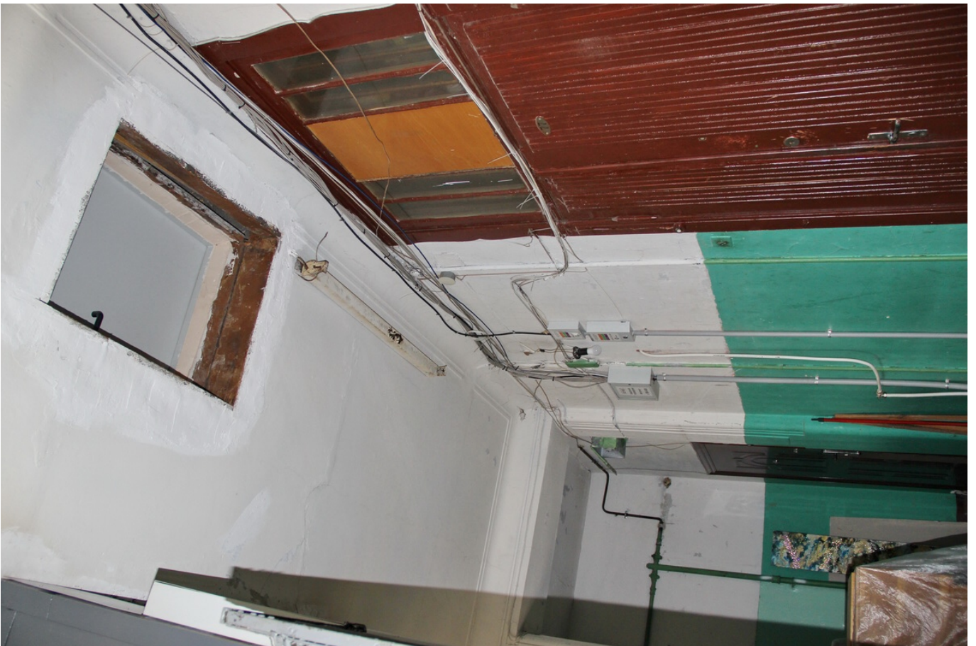
38 ОКН регионального значения "Жилой дом с магазинами Массинена" Ленинградская область, Выборгский муниципальный район, г. Выборг, Ленинградское ш., д. 15. Подъезд № 4. Лестничная клетка с лифтом. 6 этаж. Дата съемки: 01.09.2021 г.
