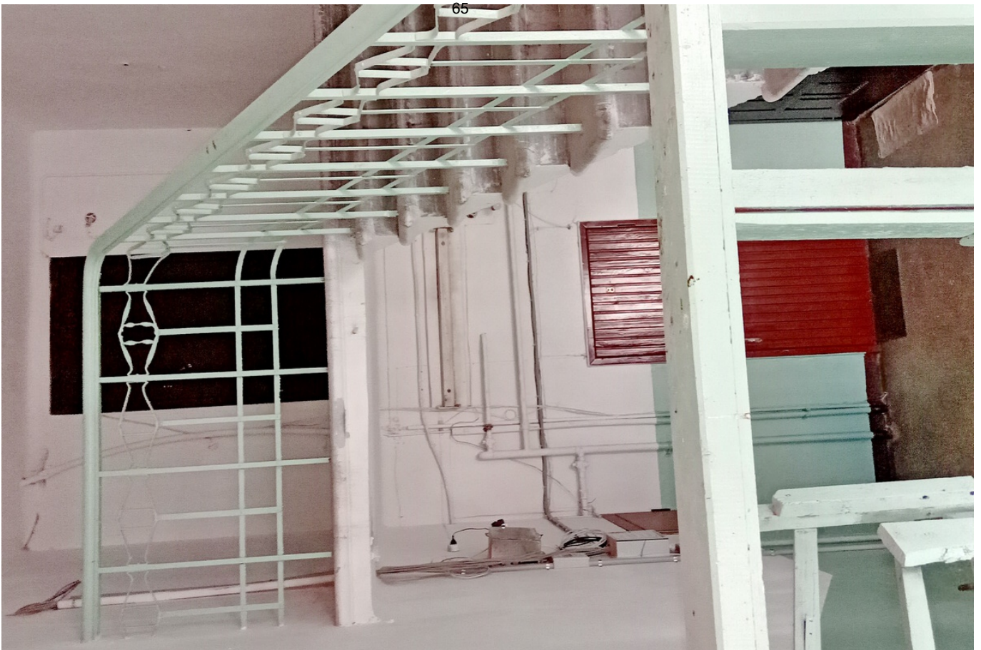
19 ОКН регионального значения “Жилой дом с магазинами Массинена” Ленинградская область, Выборгский муниципальный район, г. Выборг, Ленинградское ш., д. 15. Подъезд № 1. Лестничная клетка. Вид на площадку 5 этажа и площадку входа на чердак. Дата съемки: 01.09.2021 г.
