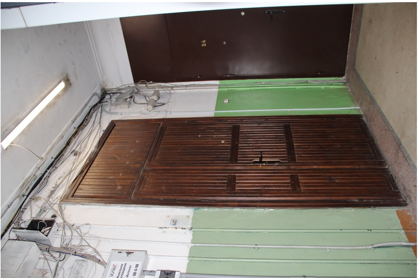
30 ОКН регионального значения “Жилой дом с магазинами Массинена” Ленинградская область, Выборгский муниципальный район, г. Выборг, Ленинградское ш., д. 15. Подъезд № 3. Лестничная клетка. 5 этаж. Дата съемки: 01.09.2021 г.
