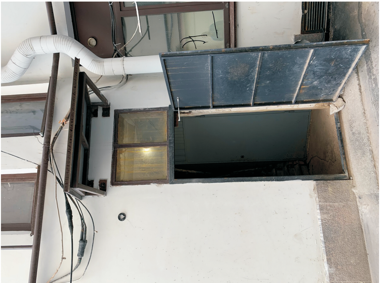
24 ОКН регионального значения “Жилой дом” Ленинградская область, Выборгский муниципальный район, г. Выборг, ул. Железнодорожная, д. 4. Вход в подъезд № 3. Дата съемки: 01.09.2021 г.
