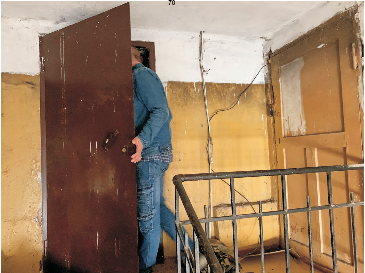
29 ОКН регионального значения “Жилой дом” Ленинградская область, Выборгский муниципальный район, г. Выборг, ул. Железнодорожная, д. 4. Подъезд № 3. Выход на чердак. Дата съемки: 01.09.2021 г.
