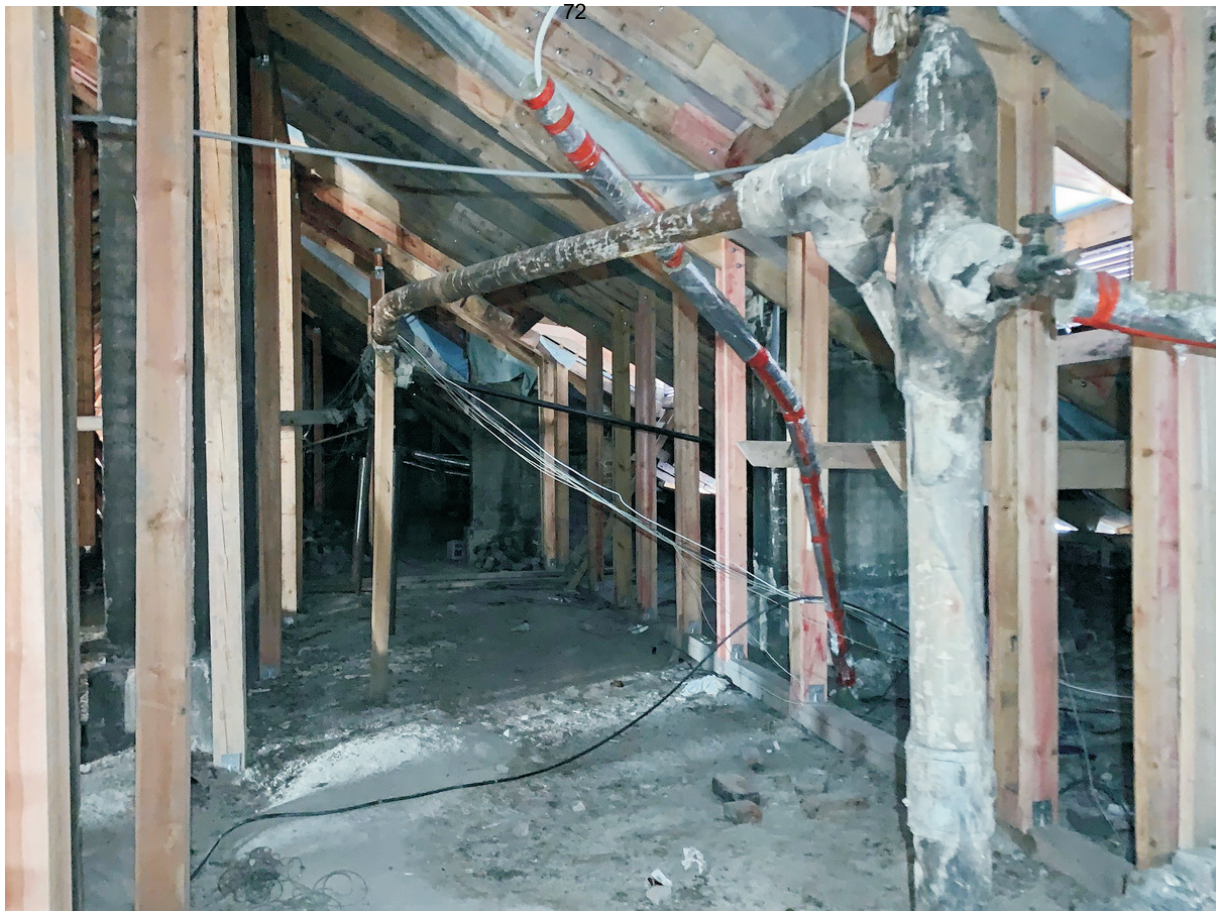
33 ОКН регионального значения “Жилой дом” Ленинградская область, Выборгский муниципальный район, г. Выборг, ул. Железнодорожная, д. 4. Чердак. Дата съемки: 01.09.2021 г.
