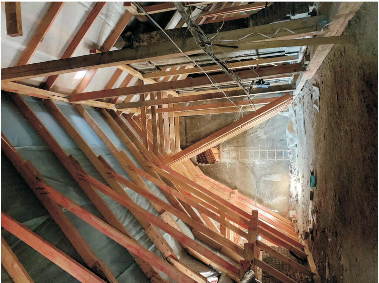
30 ОКН регионального значения “Жилой дом” Ленинградская область, Выборгский муниципальный район, г. Выборг, ул. Железнодорожная, д. 4. Чердак. Дата съемки: 01.09.2021 г.
