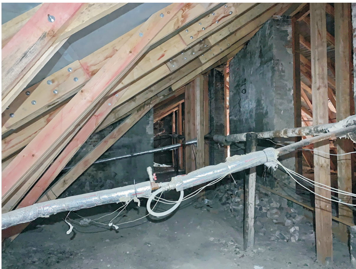
32 ОКН регионального значения “Жилой дом” Ленинградская область, Выборгский муниципальный район, г. Выборг, ул. Железнодорожная, д. 4. Чердак. Дата съемки: 01.09.2021 г.
