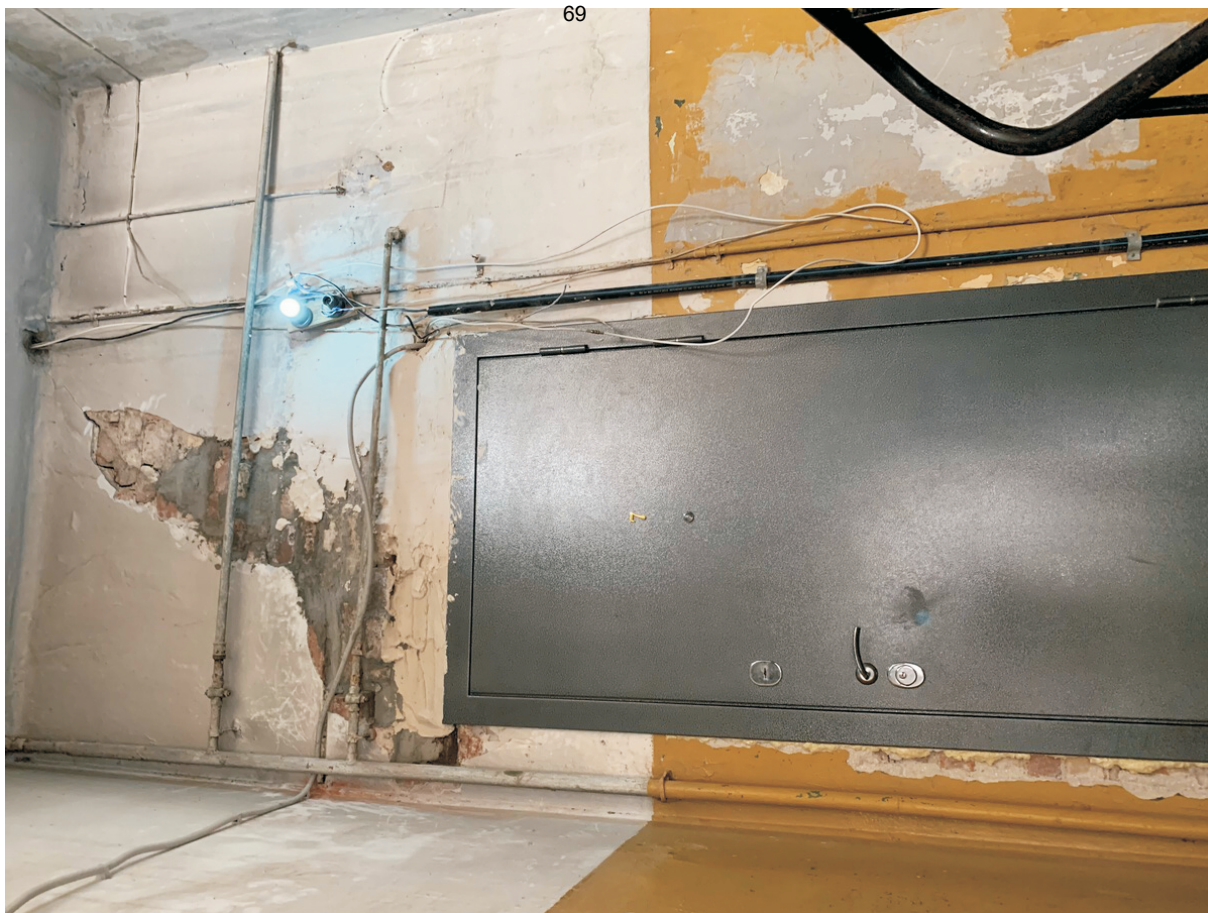
27 ОКН регионального значения “Жилой дом” Ленинградская область, Выборгский муниципальный район, г. Выборг, ул. Железнодорожная, д. 4. Подъезд № 3. Лестничная клетка. 3 этаж. Дата съемки: 01.09.2021 г.
