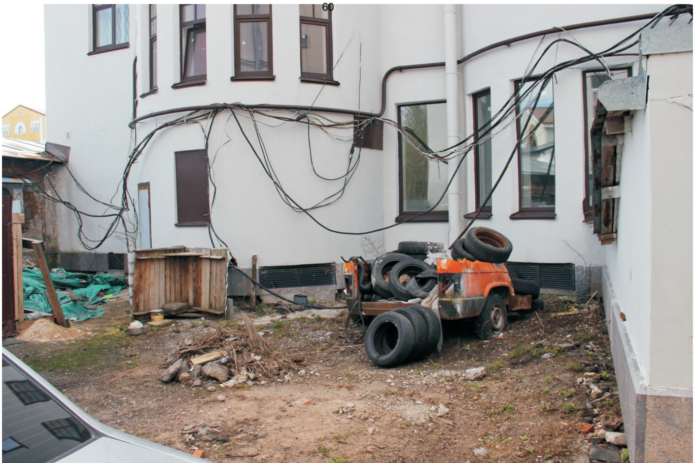
9 ОКН регионального значения “Жилой дом” Ленинградская область, Выборгский муниципальный район, г. Выборг, ул. Железнодорожная, д. 4. Северо-восточный фасад. Фрагмент. Дата съемки: 01.09.2021 г.
