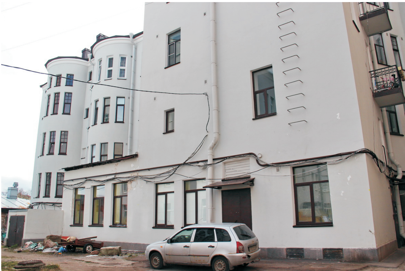
6 ОКН регионального значения “Жилой дом” Ленинградская область, Выборгский муниципальный район, г. Выборг, ул. Железнодорожная, д. 4. Северо-восточный фасад. Фрагмент. Дата съемки: 01.09.2021 г.
