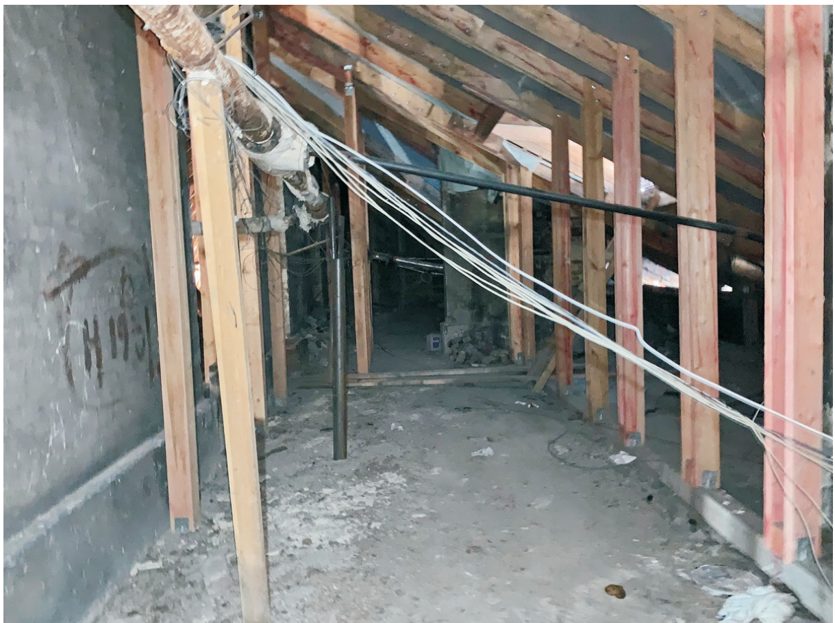
34 ОКН регионального значения “Жилой дом” Ленинградская область, Выборгский муниципальный район, г. Выборг, ул. Железнодорожная, д. 4. Чердак. Дата съемки: 01.09.2021 г.
