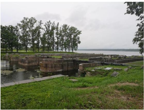
Фото 17. Территория производства работ. Участок капитального ремонта сетей водоснабжения вдоль улицы Староладожский Канал в границах территории объекта культурного наследия регионального значения «Комплекс сооружений Петровского канала». Демонтируемая существующая сеть водовода д=500 мм проходящая наземно по быкам через аванкамеру Петровского шлюза с опиранием на «быки» с использованием удерживающей металлической конструкции.
