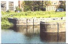
3 Архитектурнохудожественное решение: устои моста, быки (с лестницами спусков) облицованы блоками розового гранита, обработанными в технике бучардирования;
