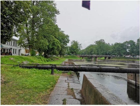
Фото 16. Территория производства работ. Участок капитального ремонта сетей водоснабжения вдоль улицы Староладожский Канал в границах территории объекта культурного наследия регионального значения «Комплекс сооружений Петровского канала». Демонтируемая существующая сеть водовода д=500 мм проходящая наземно по быкам через аванкамеру Петровского шлюза с опиранием на «быки» с использованием удерживающей металлической конструкции.
