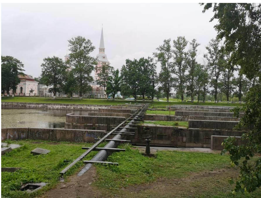
Фото 12. Территория производства работ. Демонтируемая существующая сеть водовода d=500 мм проходящая наземно по быкам через аванкамеру Петровского шлюза с опиранием на «быки» с использованием удерживающей металлической конструкции.
