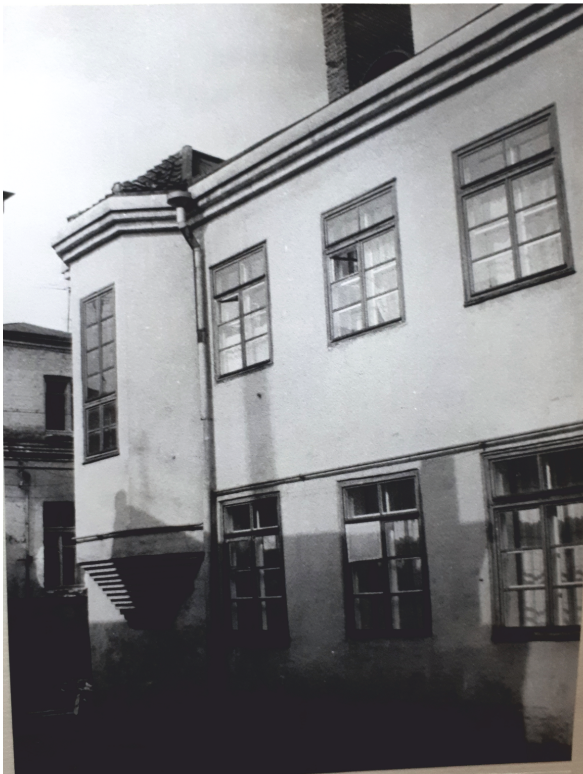
Илл. 9. Краснофлотская ул., д. 1. Дворовый фасад. Фото 1982 г. // «Проект зон охраны. г.Выборг. Предпроектные исследования. Р.1а, т.1. Анкеты обследования застройки. кн.2. ЛФИ СПР». 1982 г.// Ахив ККЛО, № 282-49
