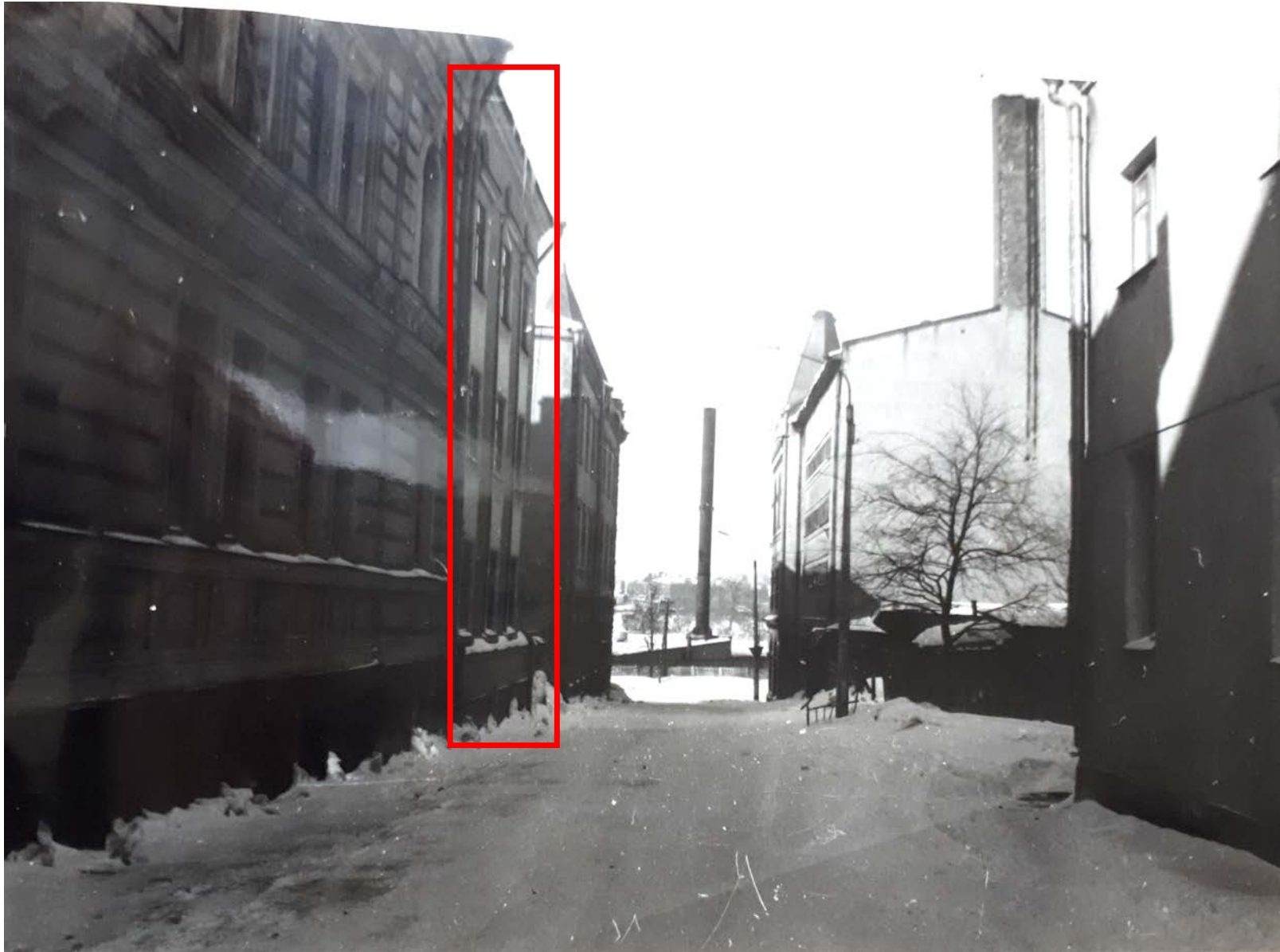
Илл. 16. Выборгская ул. Начало улицы с видом на перекресток с ул. Южный вал. 1980 г. «Проект зон охраны. г. Выборг. Предпроектные исследования. Р.Іа, т.ІІ. Изобразительный материал». ЛФИ СПР. 1982 г. Архив ККЛО, № 282-50
