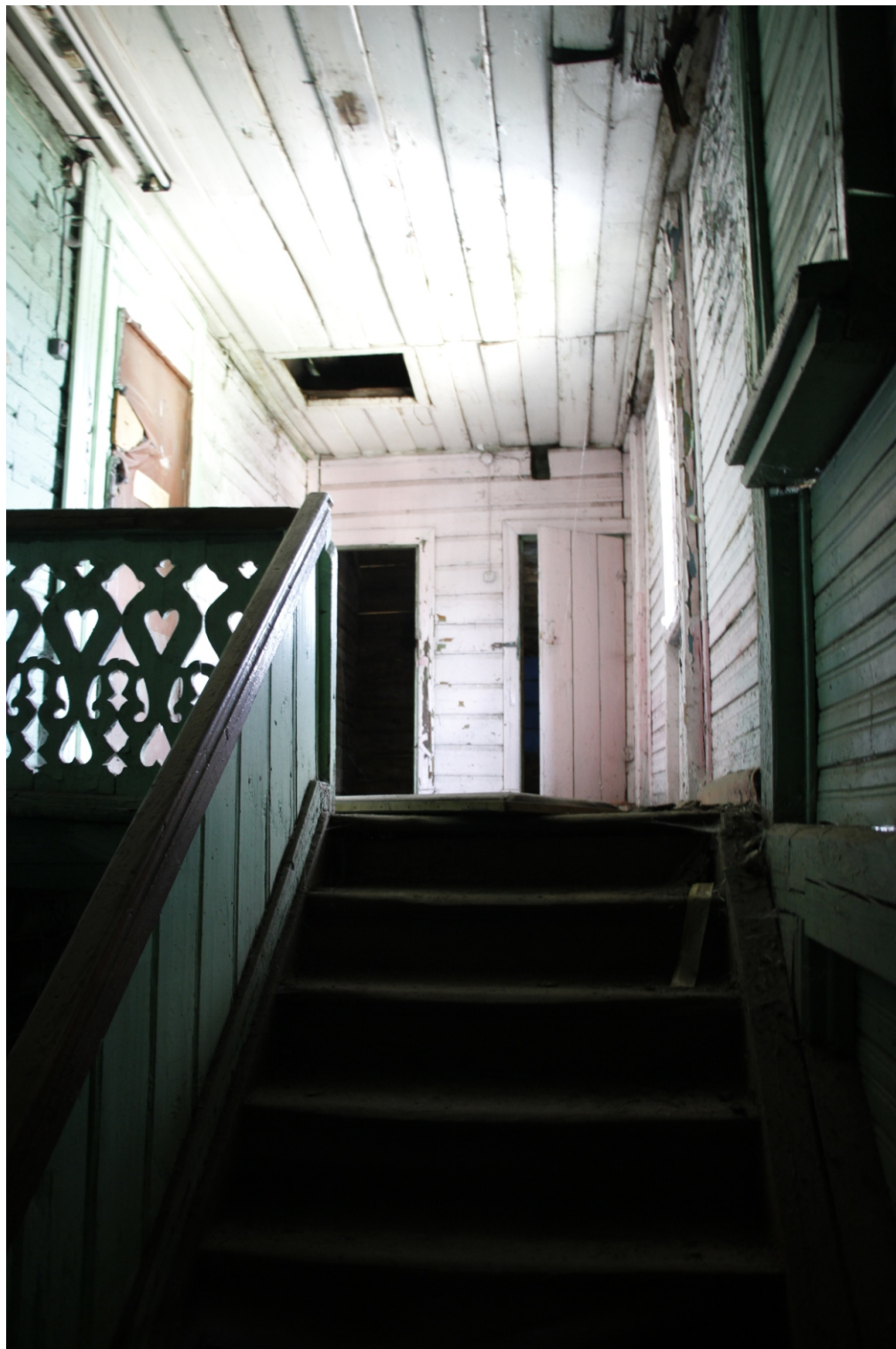
14. “Жилой дом”. Ленинградская область, г. Луга, пр. Кирова, д.34. Фрагмент лестничного марша в уровне 2-го этажа. Фото: 15.06.2022.
