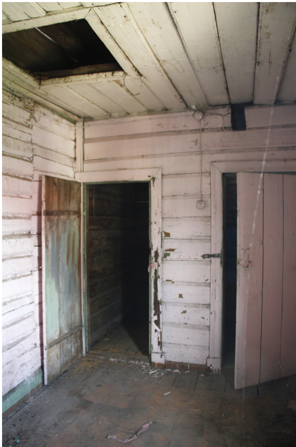
17. “Жилой дом”. Ленинградская область, г. Луга, пр. Кирова, д.34. Фрагмент интерьера помещения 1-го этажа. Фото: 15.06.2022.
