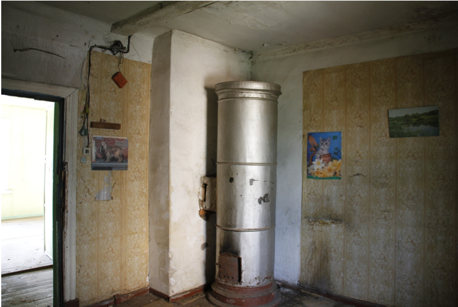
21. “Жилой дом”. Ленинградская область, г. Луга, пр. Кирова, д.34. Фрагмент интерьера помещения 2-го этажа. Фото: 15.06.2022.
