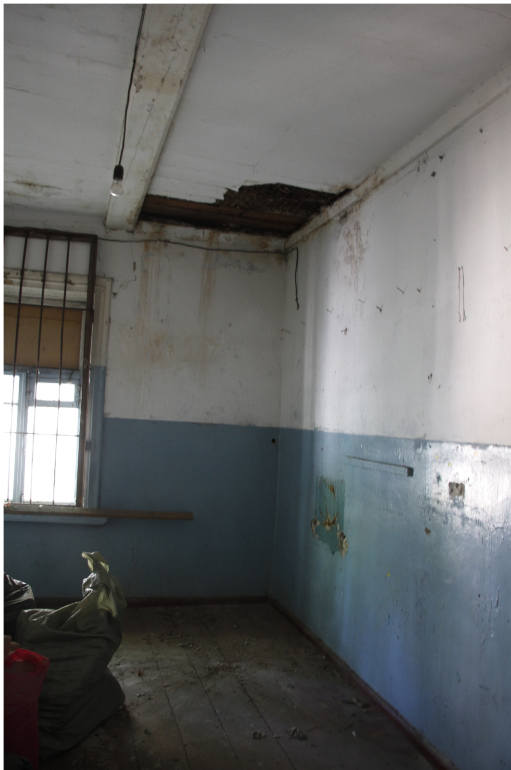
19. “Жилой дом”. Ленинградская область, г. Луга, пр. Кирова, д.34. Фрагмент интерьера помещения 1-го этажа. Фото: 15.06.2022.
