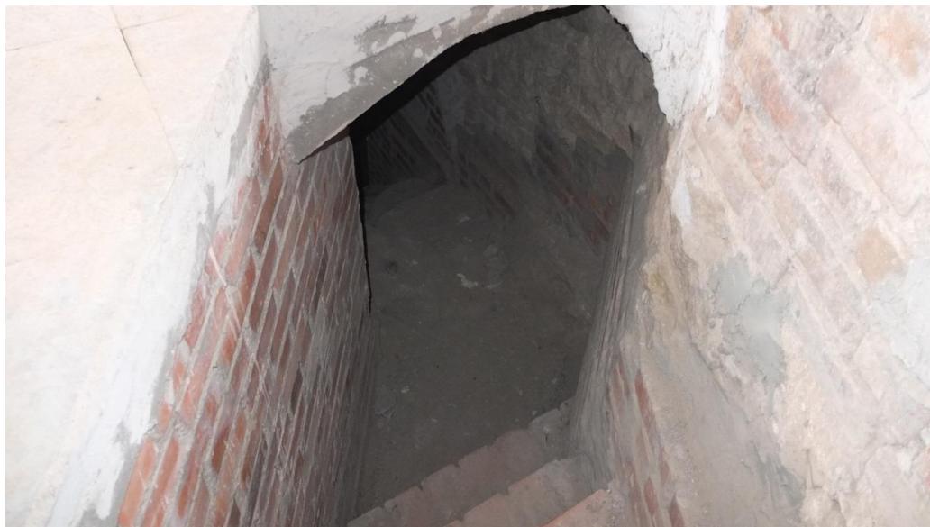
25. Объект культурного наследия федерального значения «Церковь Никольская», XVI в., по адресу: Ленинградская область, Волховский муниципальный район, Свирицкое сельское поселение, дер. Сторожно, дом № 7-а (Ленинградская область, Новолдожский район, село Сторожное). Второй ярус. Внутрстенная лестница.
