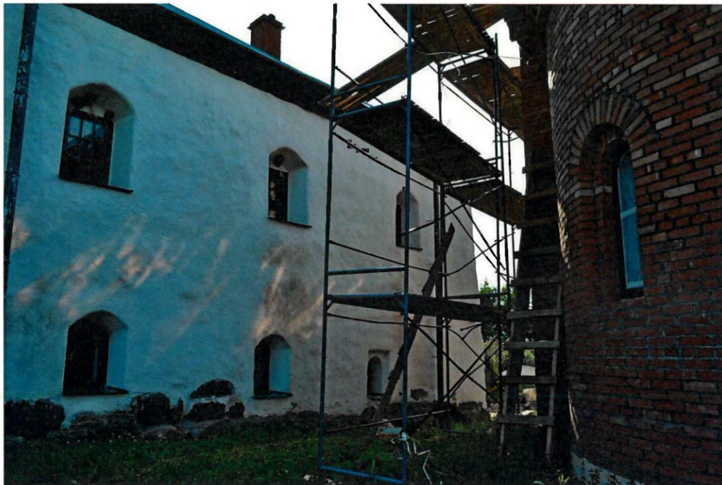
Фото 3. Северный фасад. Вид с северо-востока.
