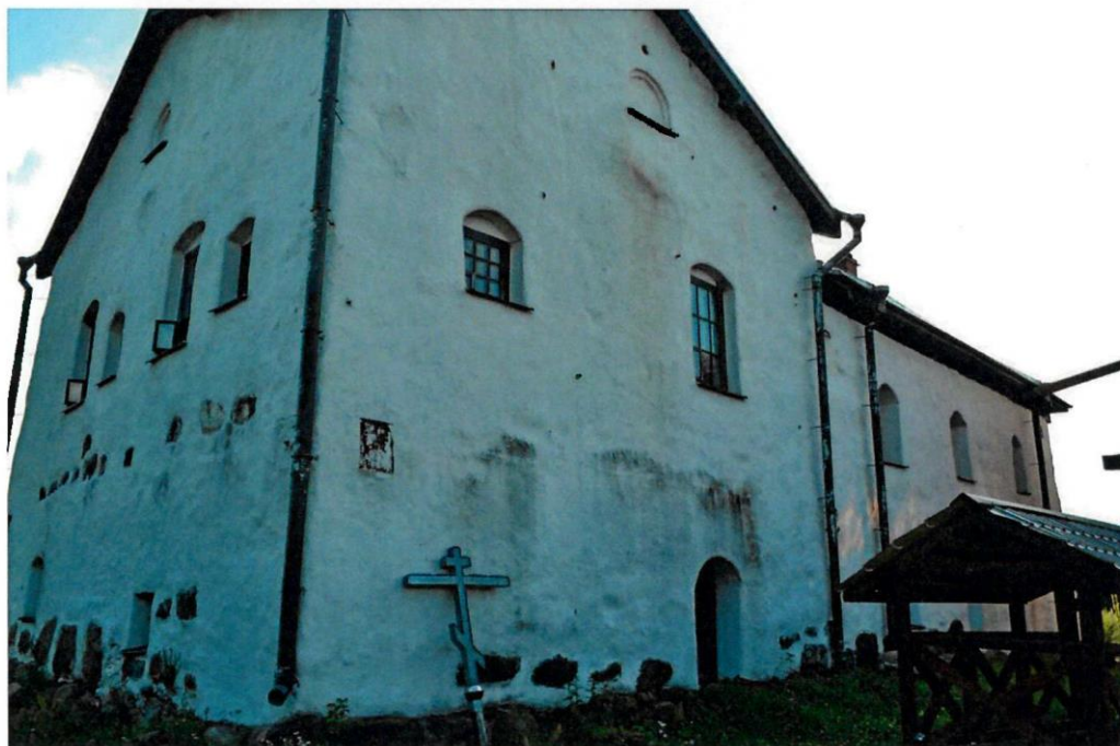
Фото 4. Северный фасад. Вид с северо-востока.
