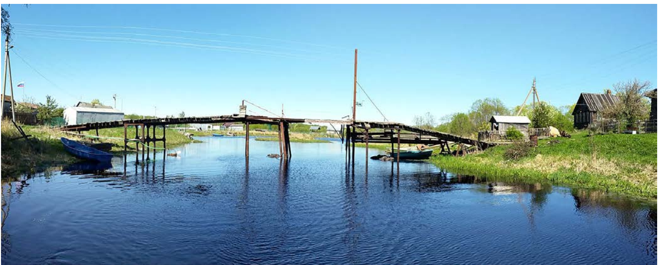
Илл. 70. Новолодожский канал. Разводной мост в с. Дубно. 2016 г.
