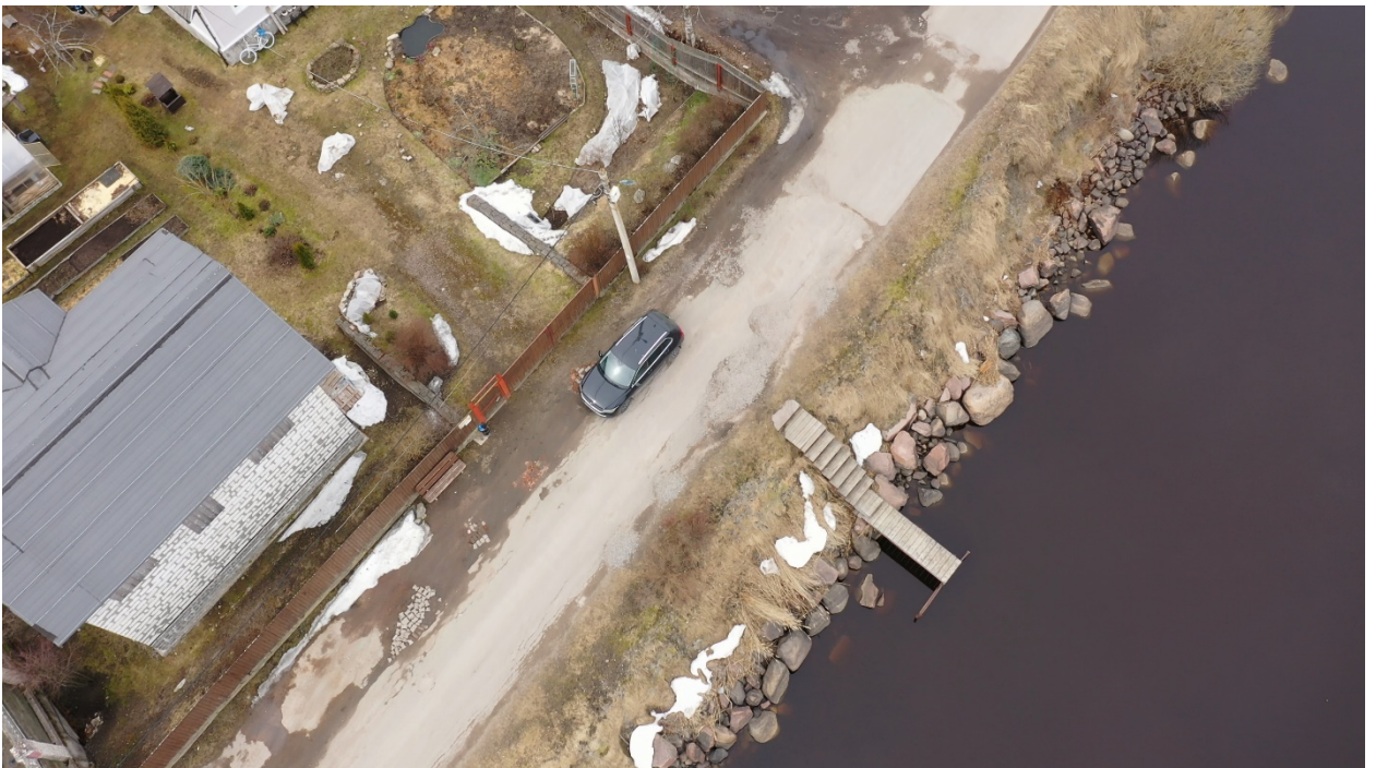
Фото 10. (аэрофотосъемка) Вид на берегоукрепление Новолажского канала, каменная наброска характерна для застроенных участков канала, вне застройки преобладает одерновка берегов.
