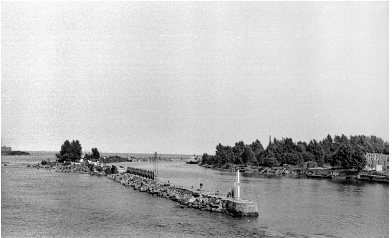
Илл. 39. Вход в Новоладожский канал. 1981 г.
