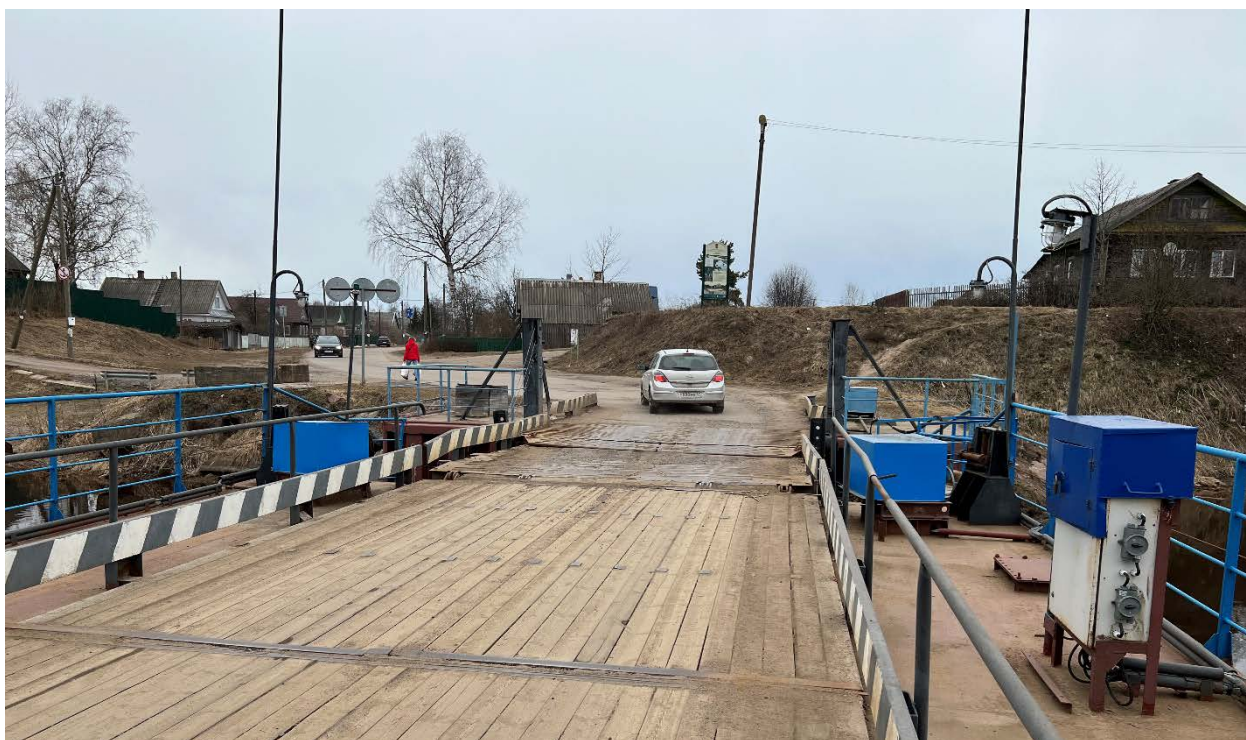
Фото 8. Вид с моста на берег и сопряжение пролетной части моста с проезжей дорогой.
