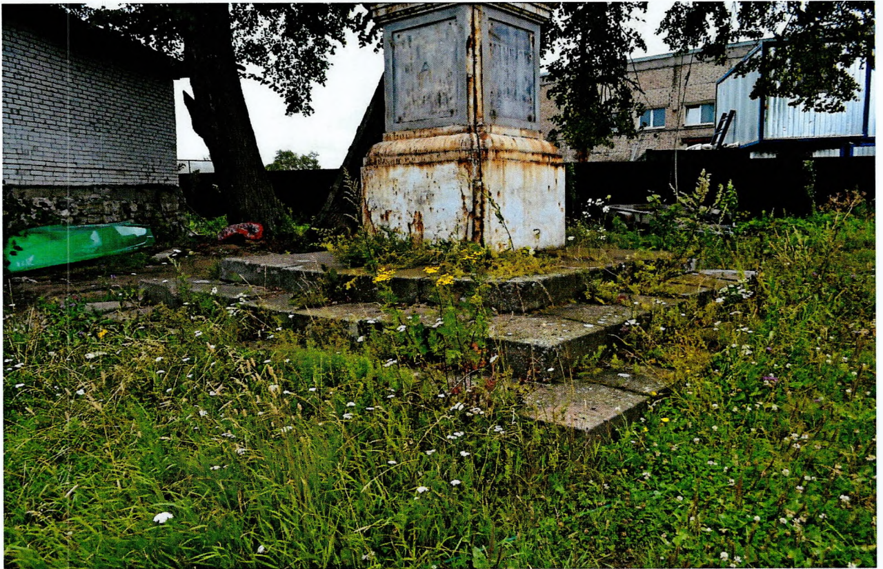
Фото 3. Обелиск, сооруженный в честь строительства Ладожского канала. Трехступенчатый стилобат. Вид с северо-востока.
