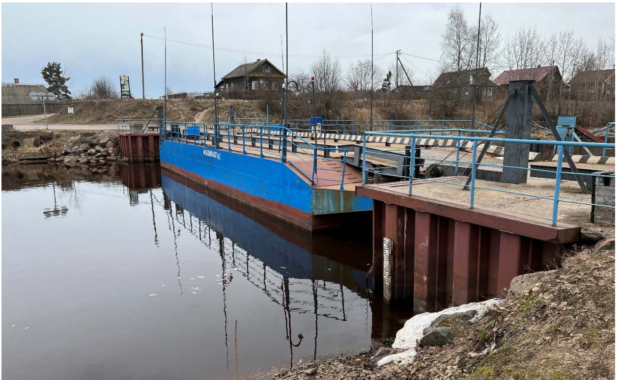
Фото 4. Вид на мост через Новоладожский канал с западной стороны в г. Новой Ладоге.
