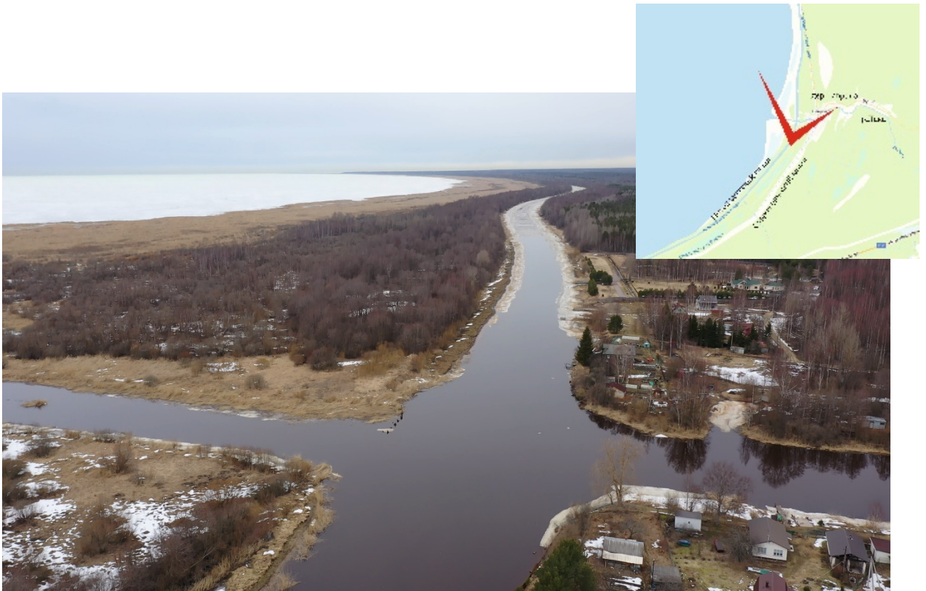
Фото 23. (аэрофотосъемка) Вид на Новолодожский канал, проходящий вдоль Ладожского озера в сторону г. Новой Ладоги, и место пересечения с р. Лавой.
