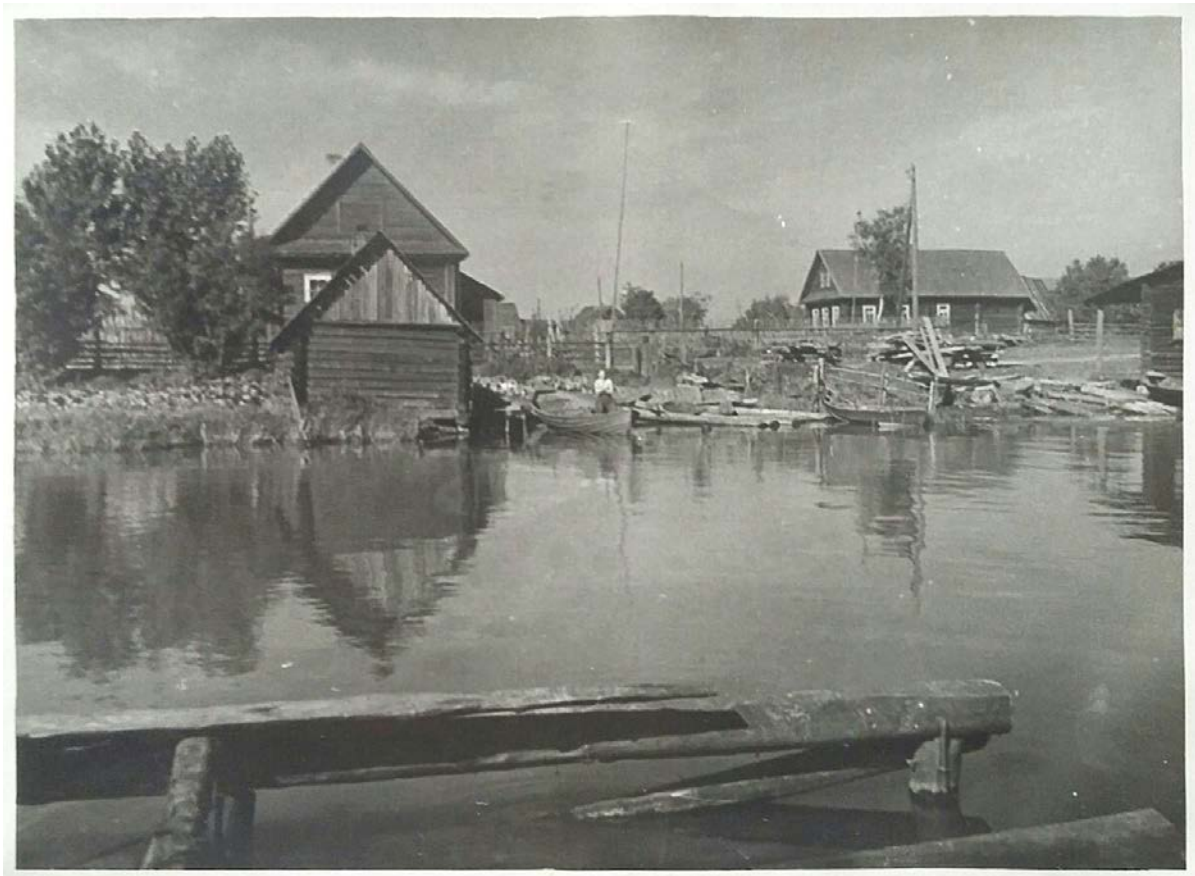
Илл. 62. Кобона, на берегу [Новоладожского] канала. 1960-е гг. Состояние берегов канала (с. Кобона)
