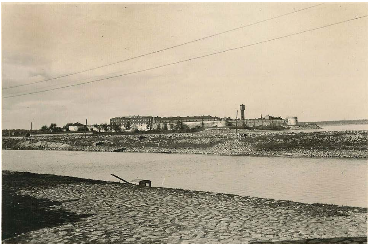
Илл. 36. Новолодожский канал в Шлиссельбурге. 1941 г. (отделка булыжным камнем дамбы – с утратами, и бечевника) Шлиссельбурге
