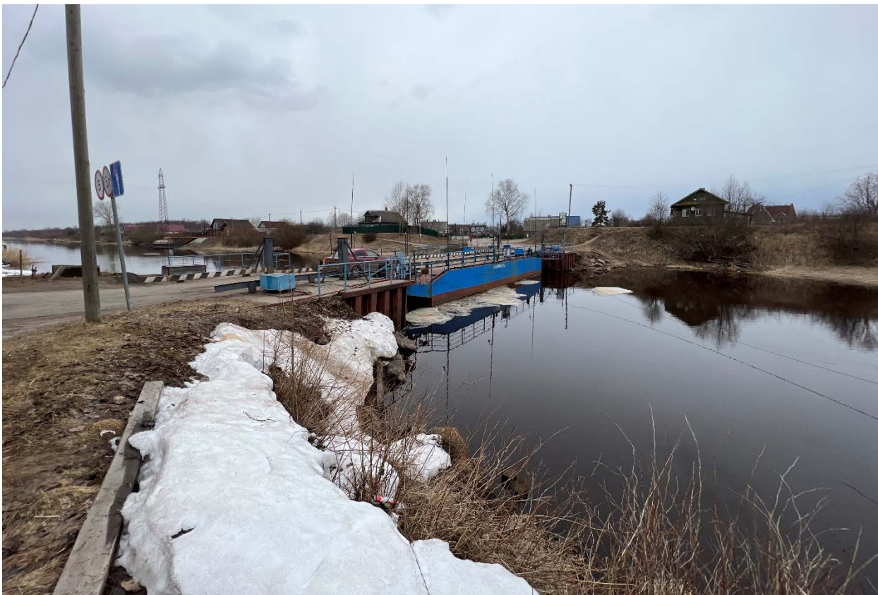
Фото 5. Вид на мост через Новолодожский канал с восточной стороны (со стороны р.Волхов)
