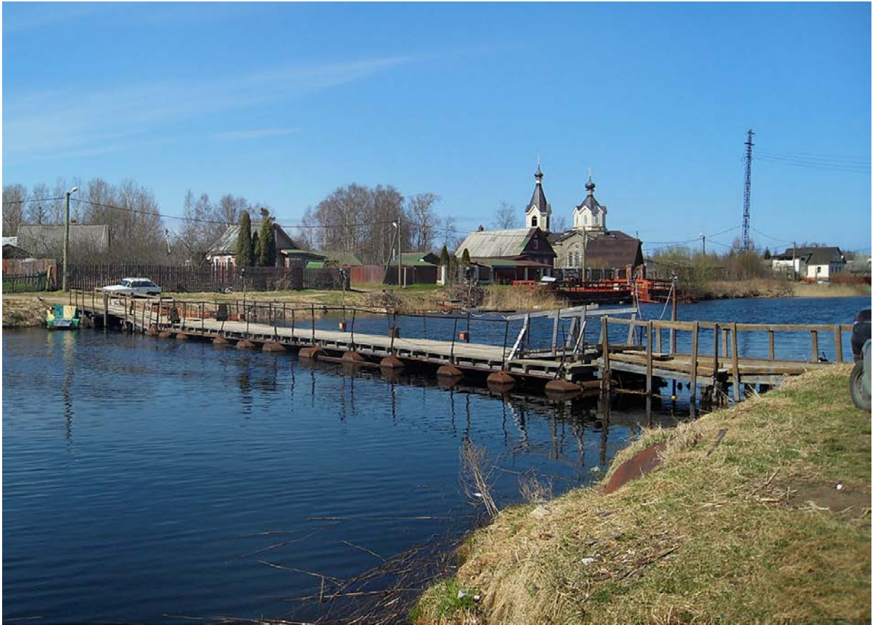
Илл. 67. Наплавной мост через Новоладожский канал в с. Черное. 2017 г.
