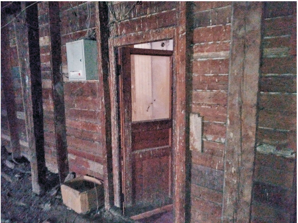
25 ОКН регионального значения “Жилой дом А.П. Воробьева” Ленинградская область, Выборгский муниципальный район, г. Выборг, ул. Майорова, д. 4. Вход на чердак. Дата съемки: 02.05.2022 г.
