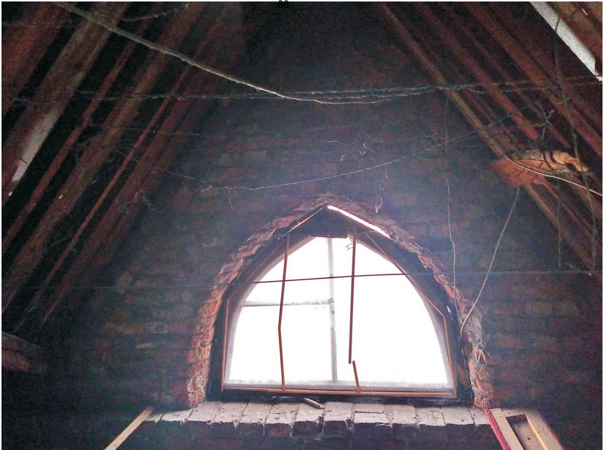
27 ОКН регионального значения “Жилой дом А.П. Воробьева” Ленинградская область, Выборгский муниципальный район, г. Выборг, ул. Майорова, д. 4. Чердак. Дата съемки: 02.05.2022 г.
