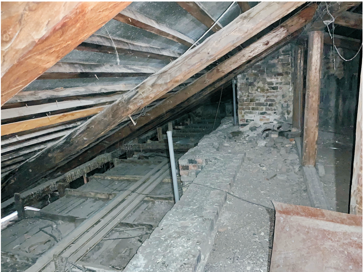
26 ОКН регионального значения “Жилой дом А.П. Воробьева” Ленинградская область, Выборгский муниципальный район, г. Выборг, ул. Майорова, д. 4. Чердак. Дата съемки: 02.05.2022 г.
