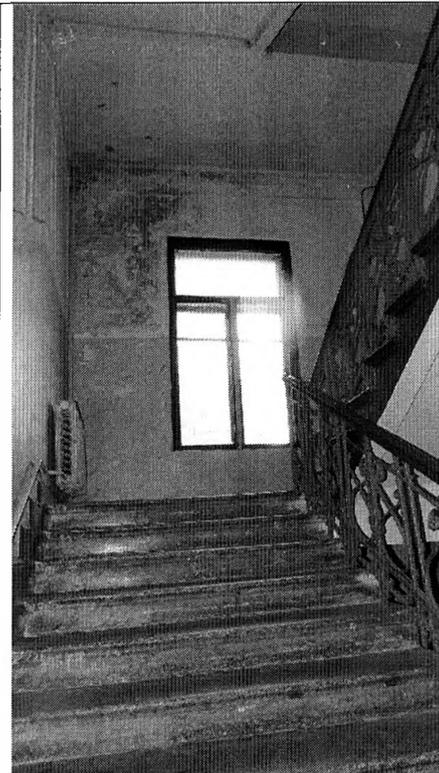
ограждения лестничных маршей – исторические вид материала (металл), техника исполнения (ковка), рисунок (в виде вертикальных прутьев, орнамент в виде завитков), поручни (материал – дерево; профиль);
