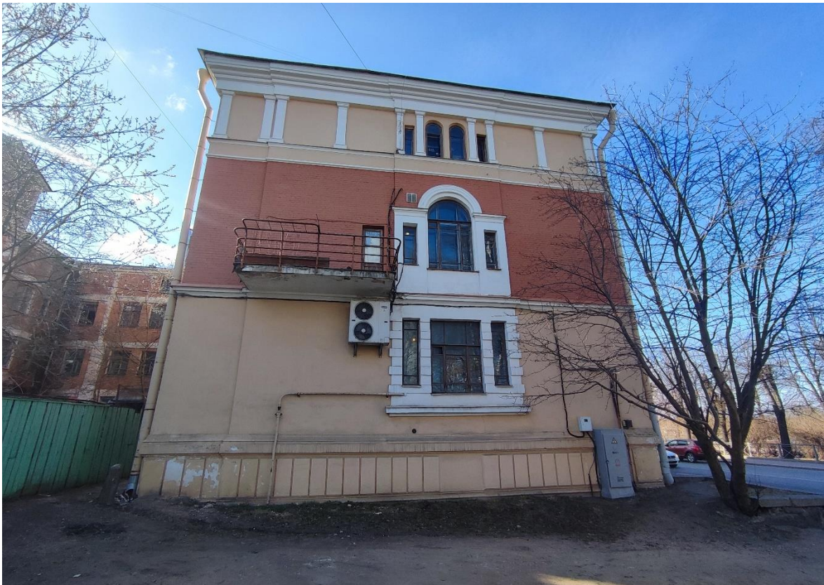
Фото 3. Общият вид здания с юго-востока. Дата съемки: 11.04.2022 г. Автор: Прокофьев М.Ф.
