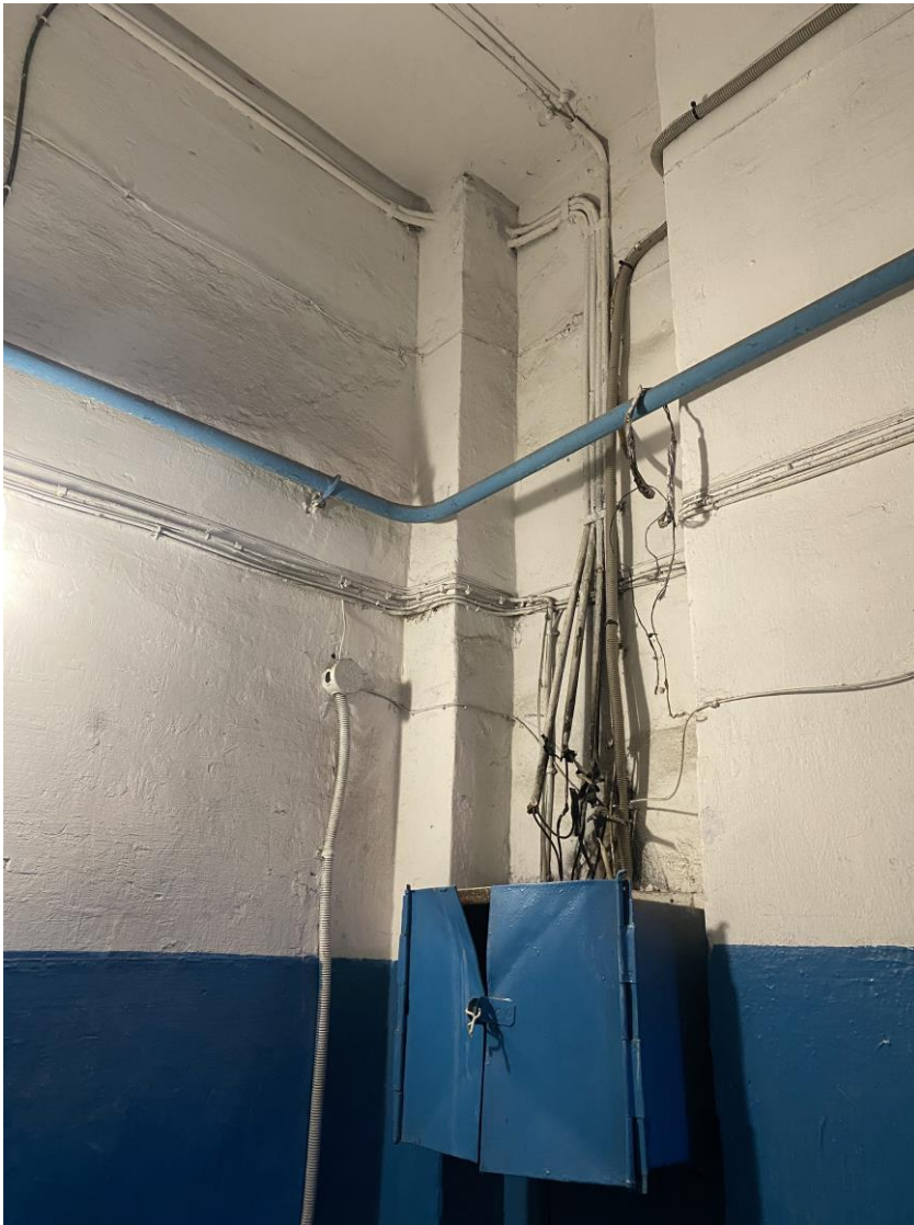
Фото 10. 4-ый этаж лестничной клетки (вход со стороны двора в уличный объем). Расположение прокладки электропроводов по стенам. Фото 11.04.2022 г. Автор: Куваева Ю.П.
