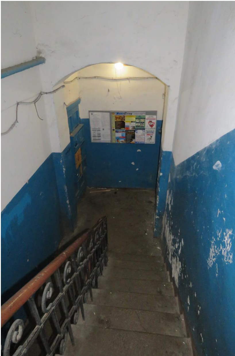
Фото 11. 1-ый этаж лестничной клетки (вход в дворовый корпус). Расположение электропроводки по стенам. Фото 11.04.2022 г. Автор: Куваева Ю.П.
