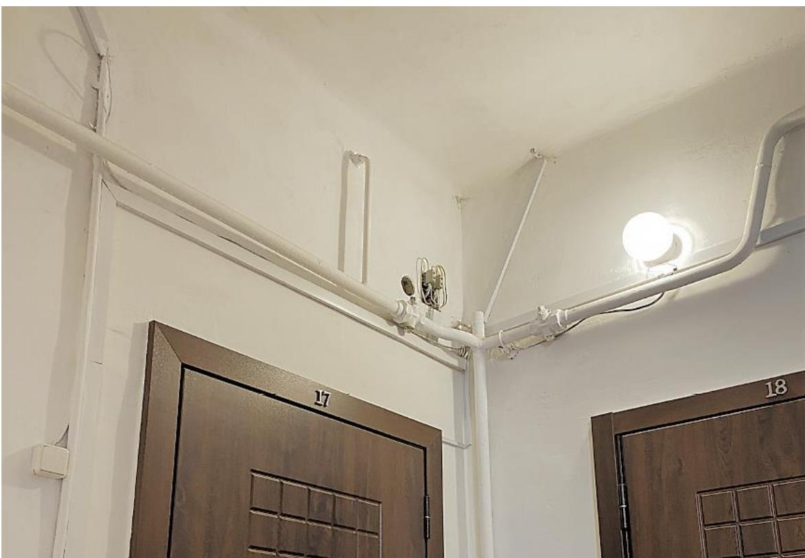
Фото 10. 3-ий этаж лестничной клетки ЛК-3. Расположение электропроводки по стенам с нарушением способа прокладки. Отсутствует аварийное освещение. Дата съемки: 11.04.2022 г. Автор: Прокофьев М.Ф.
