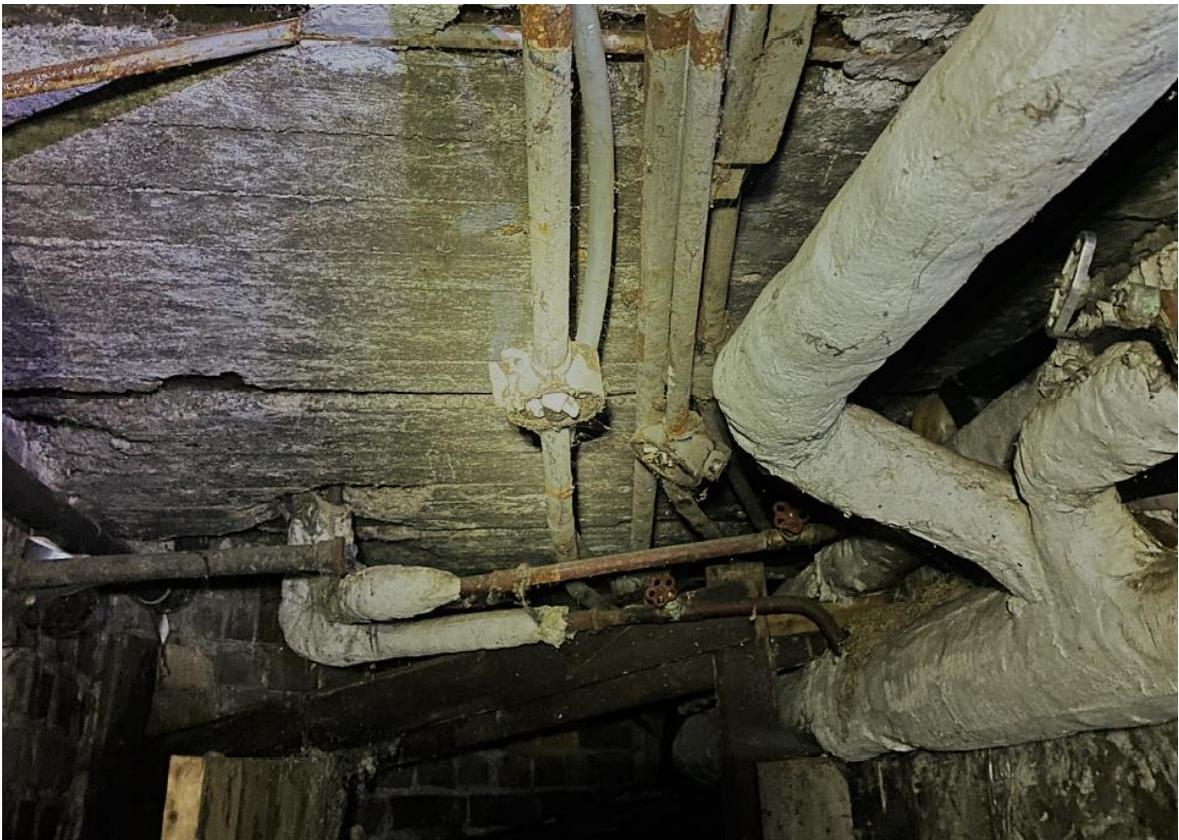
Фото 4. Подвал. Металлические трубы поражены коррозией.
