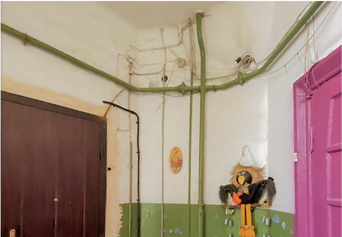
Фото 7. 2-ой этаж лестничной клетки ЛК-1. Расположение электропроводки по стенам с нарушением способа прокладки. Отсутствуют плафон светильника и аварийное освещение. Дата съемки: 11.04.2022 г. Автор: Прокофьев М.Ф.
