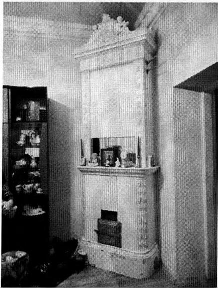
печь (кв. 14) – угловая, на цоколе, однарусная, облицованная гладким белым изразцом в том числе с рельефным растительным орнаментом (ребра, фриз, карниз). Топочное отверстие закрыто одностворчатой дверцей с орнаментом с ручкой-кнопкой. Наверху печи решено в виде аттика сложного рисунка.
