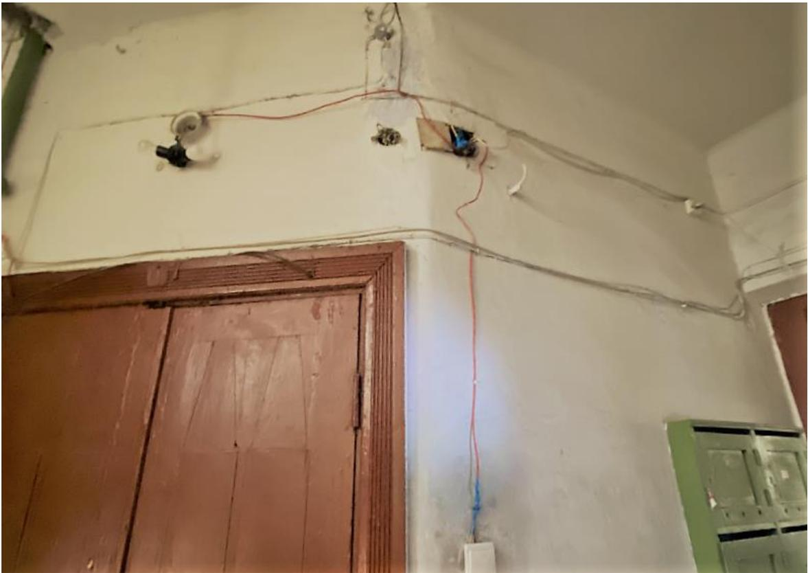
Фото 5. 1-ый этаж лестничной клетки ЛК-2. Расположение электропроводки по стенам с нарушением способа прокладки. Отсутствует аварийное освещение.
