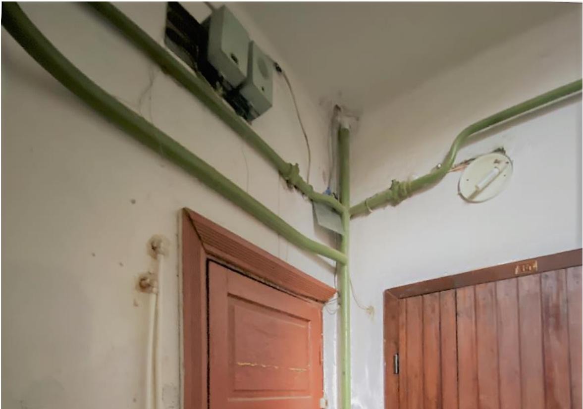
Фото 6. 1-ый этаж лестничной клетки ЛК-3. Расположение электропроводки по стенам с нарушением способа прокладки. Отсутствует аварийное освещение.
