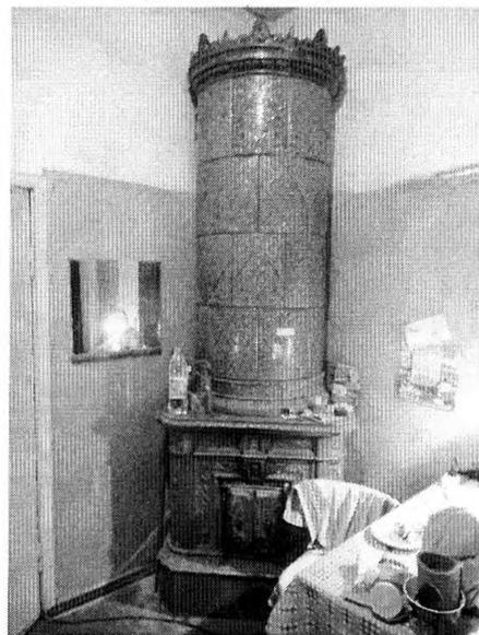
печь (кв. 14) – угловая, на цоколе, двухъярусная, облицованная белым изразцом в том числе с рельефным растительным и геометрическим орнаментом (частично с «позолотой»). Ребра, полка, цоколь, фриз облицованы изразцами с рельефом. Топочное отверстие закрыто одностворчатой дверцей с орнаментом с ручкой-кнопкой. Нижний и верхний ярусы разделены полкой с небольшим выносом. Наверху печи решено в виде картуша с овальным медальоном и сидящих по сторонам путти.
