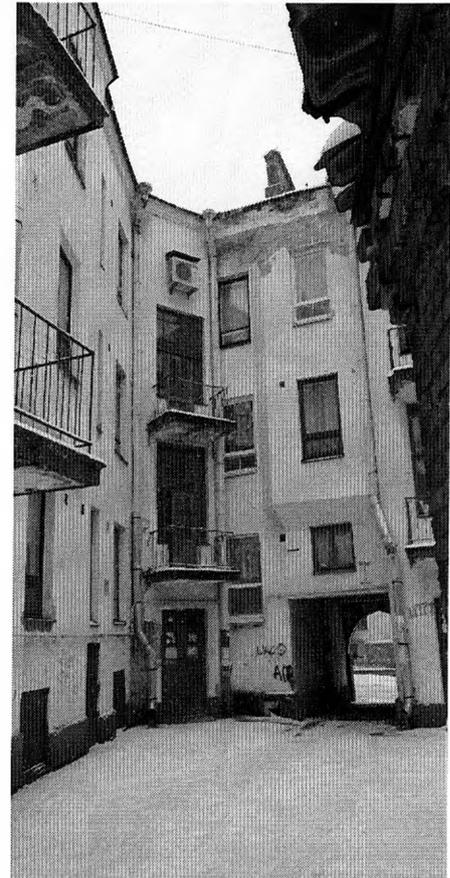
входные (балконные) проемы – исторические местоположение, габариты, конфигурация, конструкция (одностворчатые с фрамугой), цвет, материал заполнения (дерево, стекло), рисунок заполнения;
