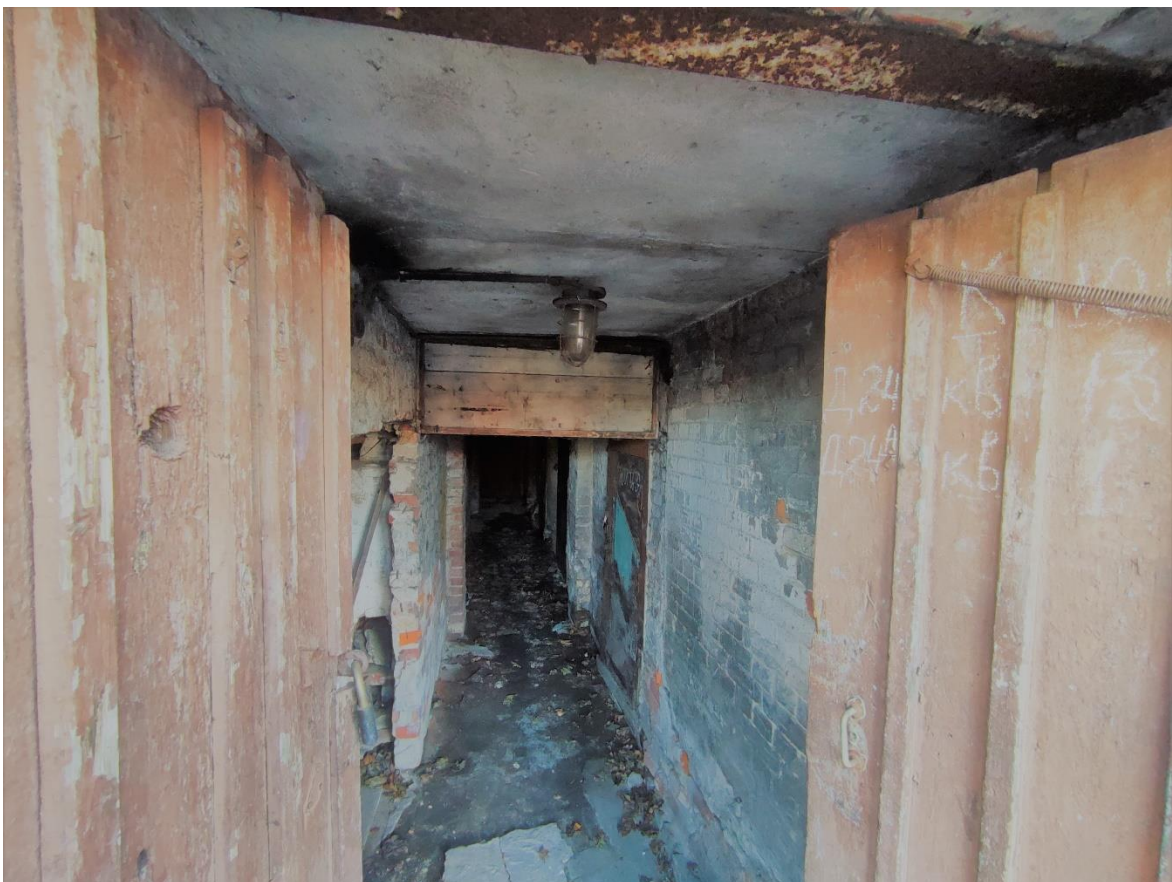
Фото 8. Вход в подвальные помещения. Дата съемки: 11.04.2022 г. Автор: Прокофьев М.Ф.
