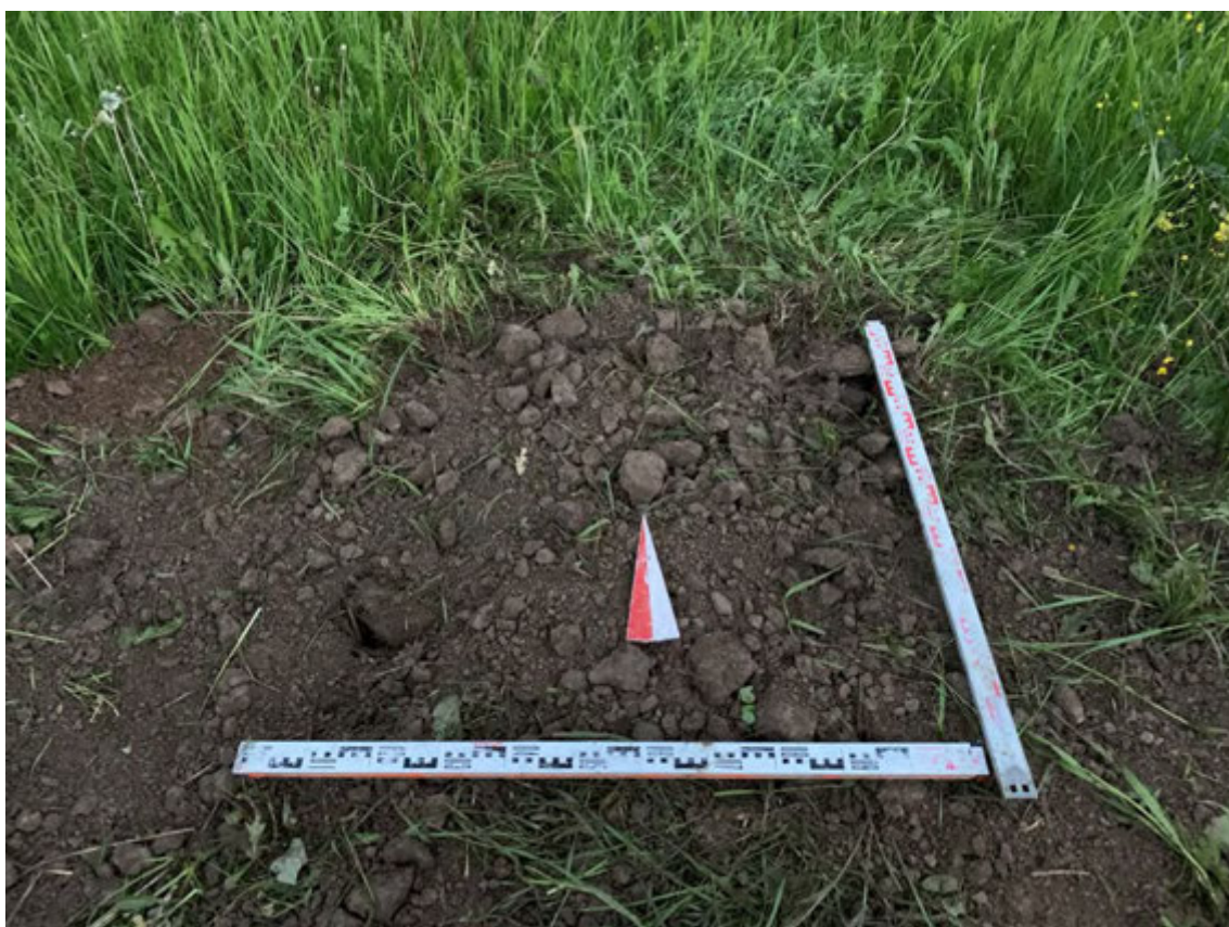
Рис. 658. Ленинградская область, Ломоносовский район, Лаголовское сельское поселение. Дневная поверхность Шурфа 99. После рекультивации. Вид с Ю.
