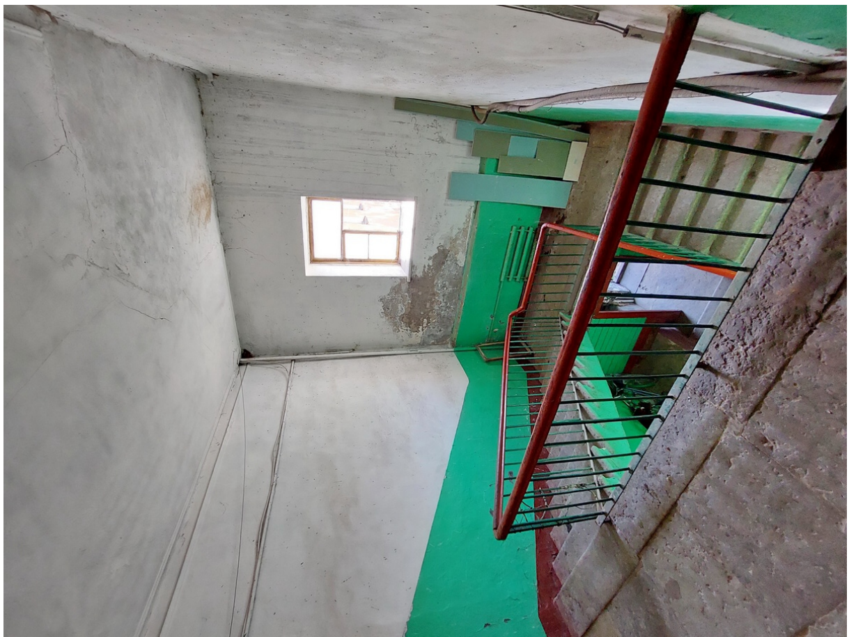
15 ОКН федерального значения “Казарма, где в 1764-1768 гг. квартировали солдаты Суздальского пехотного полка, командиром которого был Суворов Александр Васильевич” Ленинградская область, Волховский район, г. Новая Ладога, Пролетарский канал, д. 12. Лестница Б. 2 этаж. Дата съемки: 30.06.2022 г.
