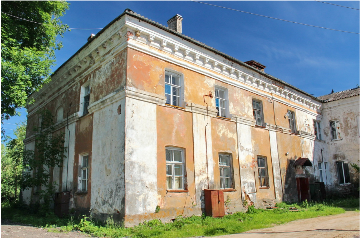
10 ОКН федерального значения “Казарма, где в 1764-1768 гг. квартировали солдаты Суздальского пехотного полка, командиром которого был Суворов Александр Васильевич” Ленинградская область, Волховский район, г. Новая Ладога, Пролетарский канал, д. 12. Северный и западный фасады. Дата съемки: 30.06.2022 г.
