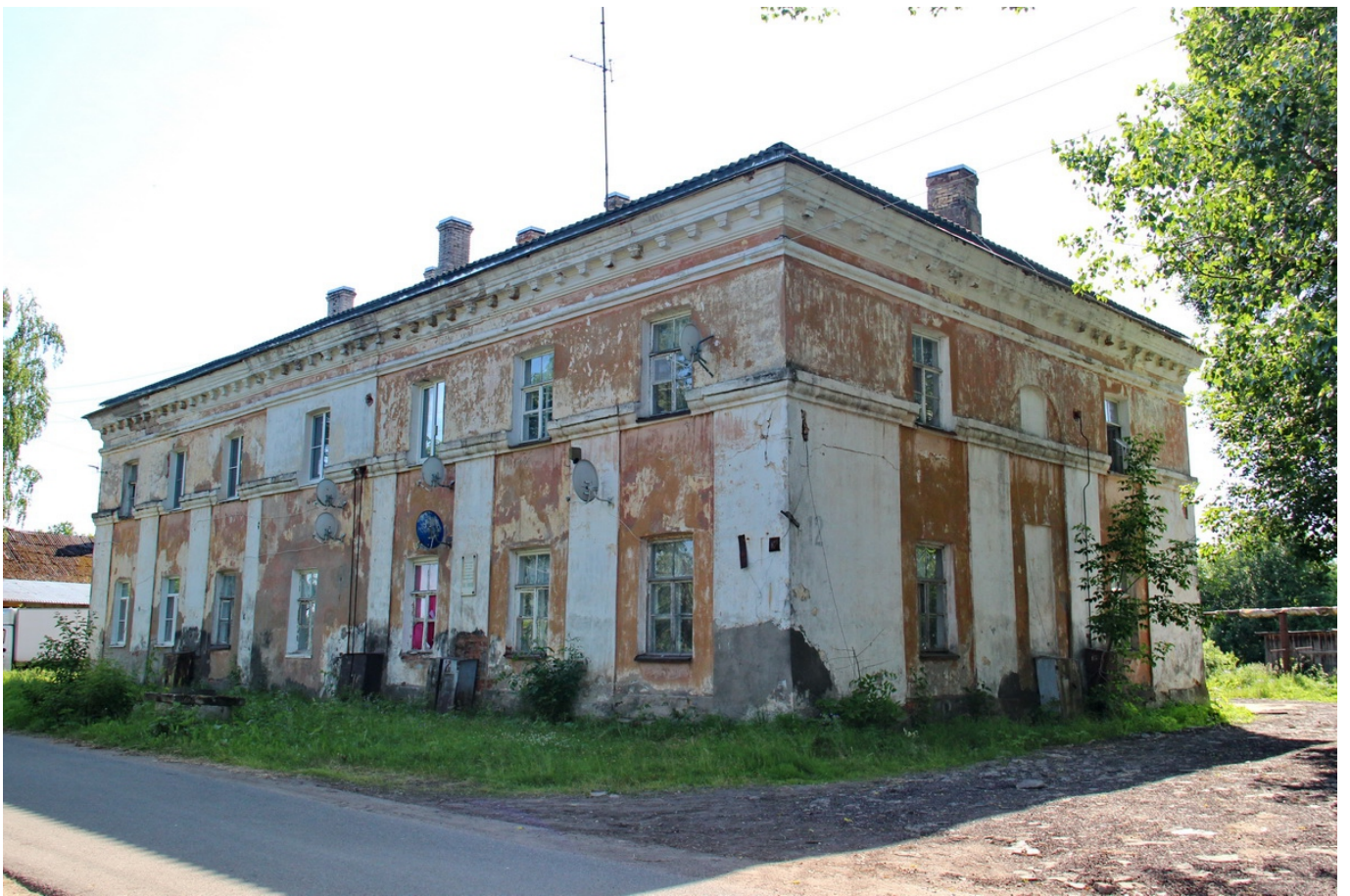
1 ОКН федерального значения “Казарма, где в 1764-1768 гг. квартировали солдаты Суздальского пехотного полка, командиром которого был Суворов Александр Васильевич” Ленинградская область, Волховский район, г. Новая Ладога, Пролетарский канал, д. 12. Вид с ул. Пролетарский Канал на восточный и северный фасады. Дата съемки: 30.06.2022 г.
