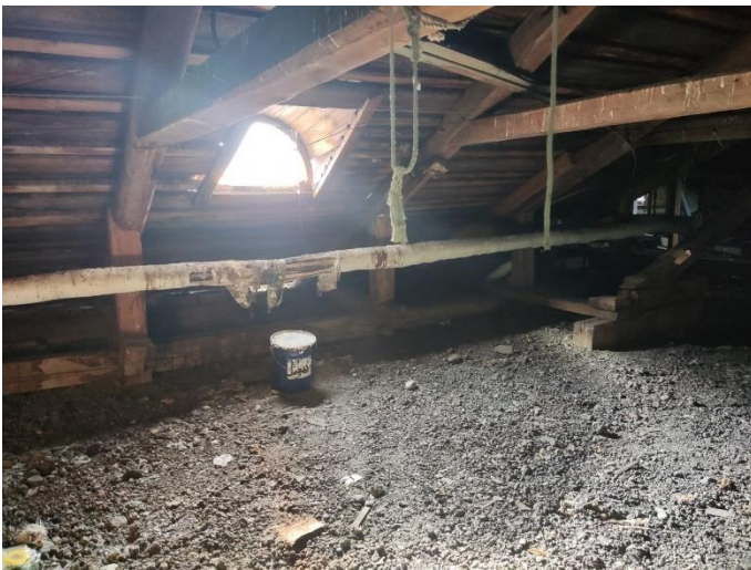
28. «Дом Лунда», Ленинградская область, Выборгский район, г. Выборг, ул. Прогонная, д.6. Чердак. Фрагмент. Фото 20.08.2022г.
