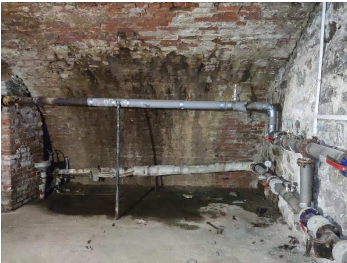
18. «Дом Лунда», Ленинградская область, Выборгский район, г. Выборг, ул. Прогонная, д.6. Подвал. Общий вид. Фото 20.08.2022г.
