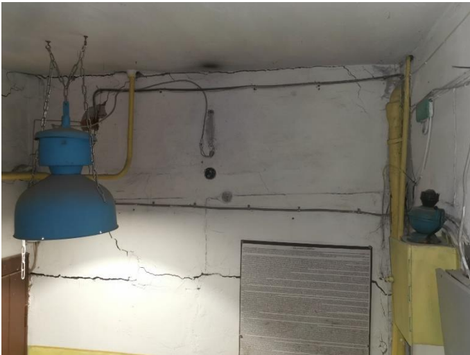
10. «Дом Лунда», Ленинградская область, Выборгский район, г. Выборг, ул. Прогонная, д.6. Подъезд №1. Фрагмент. Фото 20.08.2022г.
