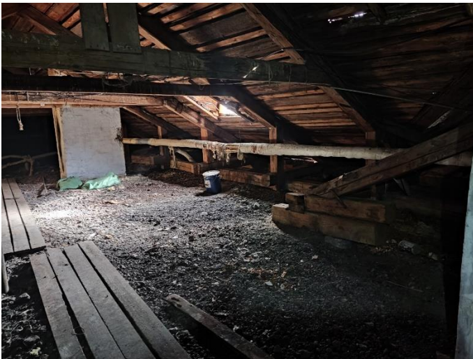
30. «Дом Лунда», Ленинградская область, Выборгский район, г. Выборг, ул. Прогонная, д.6. Чердак. Фрагмент. Фото 20.08.2022г.
