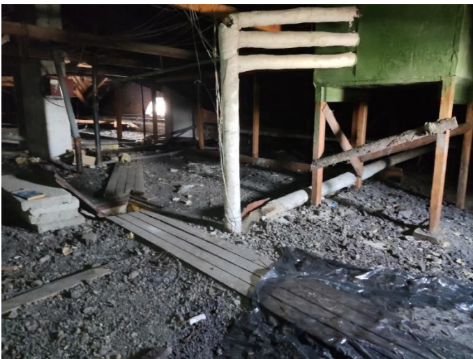
33. «Дом Лунда», Ленинградская область, Выборгский район, г. Выборг, ул. Прогонная, д.6. Чердак. Фрагмент. Фото 20.08.2022г.
