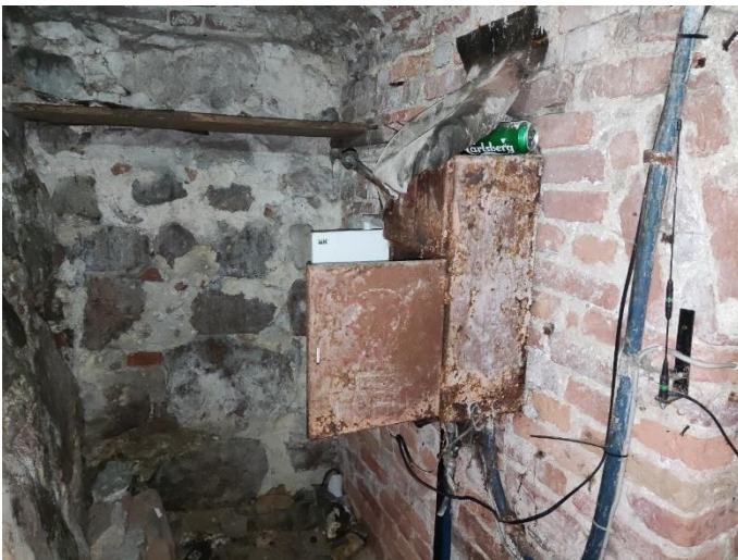
19. «Дом Лунда», Ленинградская область, Выборгский район, г. Выборг, ул. Прогонная, д.6. Подвал. Фрагмент. Фото 20.08.2022г.
