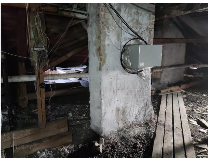
26. «Дом Лунда», Ленинградская область, Выборгский район, г. Выборг, ул. Прогонная, д.6. Чердак. Фрагмент. Фото 20.08.2022г.
