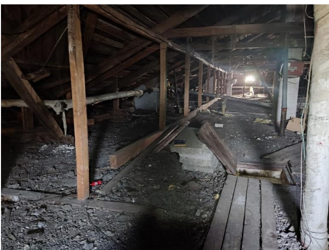
23. «Дом Лунда», Ленинградская область, Выборгский район, г. Выборг, ул. Прогонная, д.6. Чердак. Общий вид. Фото 20.08.2022г.
