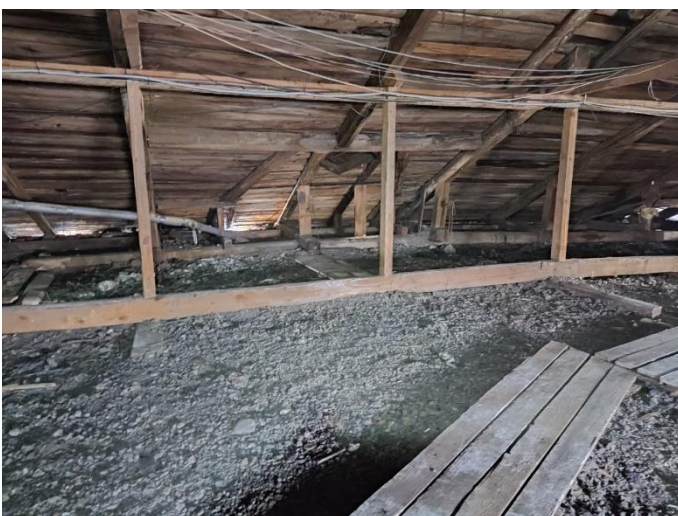
35. «Дом Лунда», Ленинградская область, Выборгский район, г. Выборг, ул. Прогонная, д.6. Чердак. Фрагмент. Фото 20.08.2022г.
