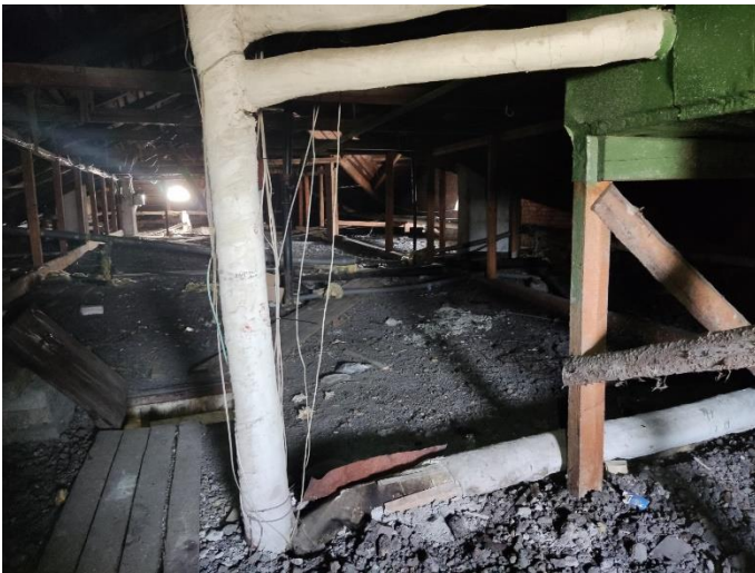
24. «Дом Лунда», Ленинградская область, Выборгский район, г. Выборг, ул. Прогонная, д.6. Чердак. Фрагмент. Фото 20.08.2022г.
