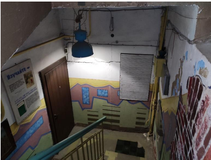
4. «Дом Лунда», Ленинградская область, Выборгский район, г. Выборг, ул. Прогонная, д.6. Подъезд №1. Фрагмент. Фото 20.08.2022г.
