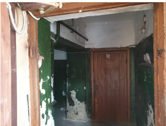
11. «Дом Лунда», Ленинградская область, Выборгский район, г. Выборг, ул. Прогонная, д.6. Подъезд №2. Общий вид. Фото 20.08.2022г.
