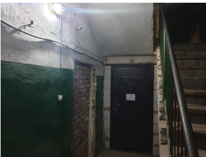
14. «Дом Лунда», Ленинградская область, Выборгский район, г. Выборг, ул. Прогонная, д.6. Подъезд №2. Фрагмент. Фото 20.08.2022г.
