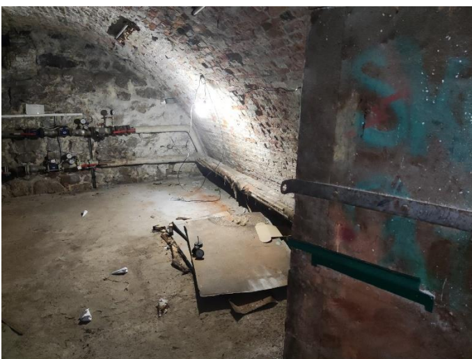
20. «Дом Лунда», Ленинградская область, Выборгский район, г. Выборг, ул. Прогонная, д.6. Подвал. Фрагмент. Фото 20.08.2022г.
