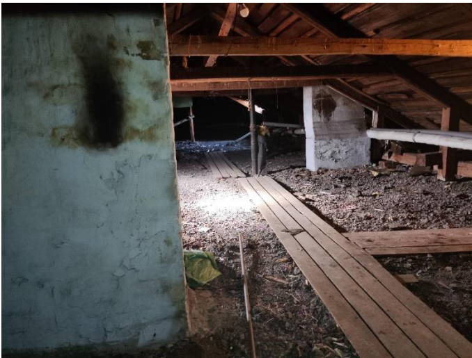
27. «Дом Лунда», Ленинградская область, Выборгский район, г. Выборг, ул. Прогонная, д.6. Чердак. Фрагмент. Фото 20.08.2022г.
