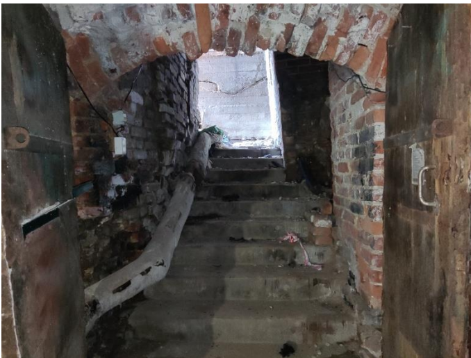
22. «Дом Лунда», Ленинградская область, Выборгский район, г. Выборг, ул. Прогонная, д.6. Подвал. Фрагмент. Фото 20.08.2022г.
