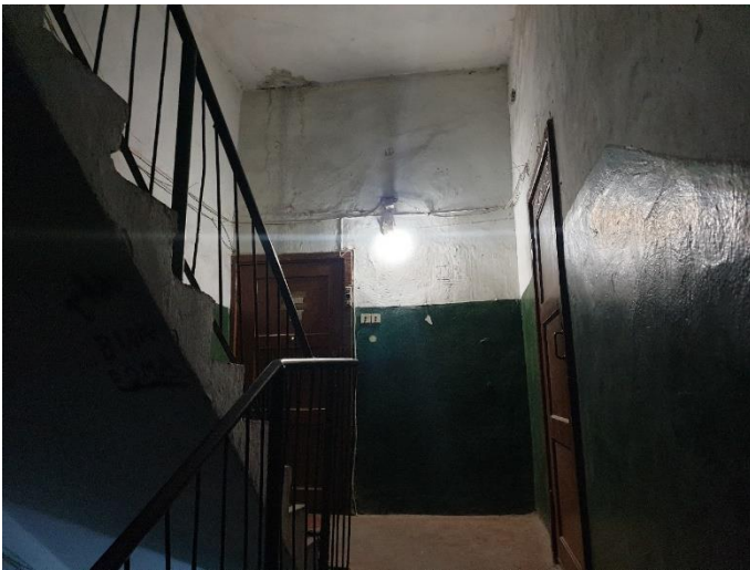
15. «Дом Лунда», Ленинградская область, Выборгский район, г. Выборг, ул. Прогонная, д.6. Подъезд №2. Фрагмент. Фото 20.08.2022г.
