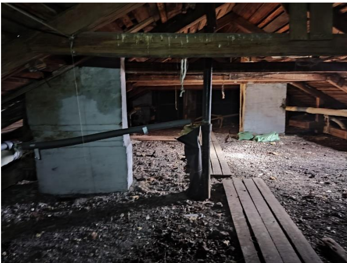
31. «Дом Лунда», Ленинградская область, Выборгский район, г. Выборг, ул. Прогонная, д.6. Чердак. Фрагмент. Фото 20.08.2022г.
