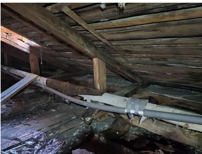
32. «Дом Лунда», Ленинградская область, Выборгский район, г. Выборг, ул. Прогонная, д.6. Чердак. Фрагмент. Фото 20.08.2022г.
