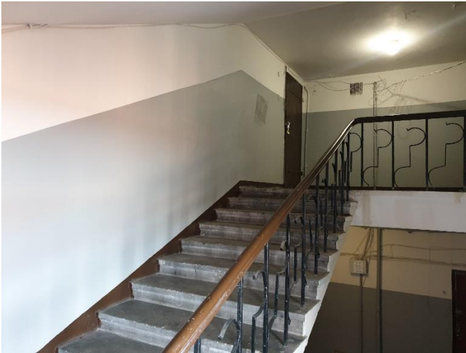
19. «Жилой дом акционерного общества «Калеваринне»», Ленинградская область, Выборгский район, г. Выборг, ул. Первомайская, д.2. Подъезд. Фрагмент. Фото 20.08.2022г.
