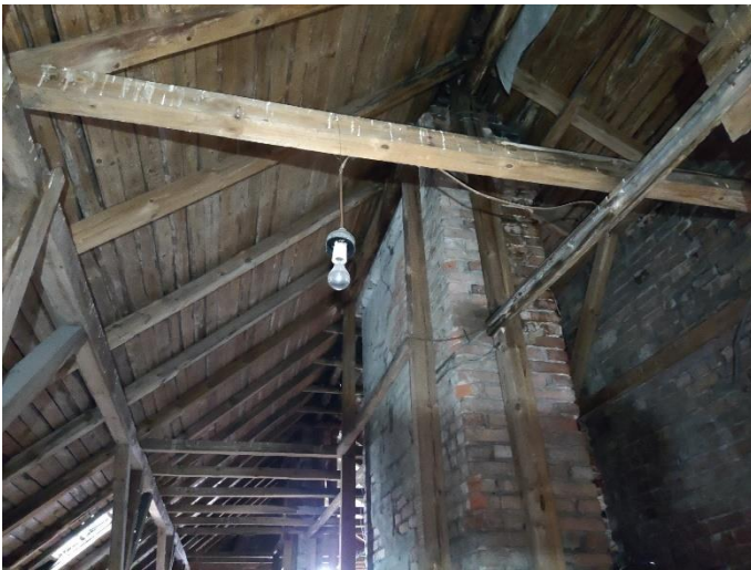
40. «Жилой дом акционерного общества «Калеваринне»», Ленинградская область, Выборгский район, г. Выборг, ул. Первомайская, д.2. Чердак. Фрагмент. Фото 20.08.2022г.
