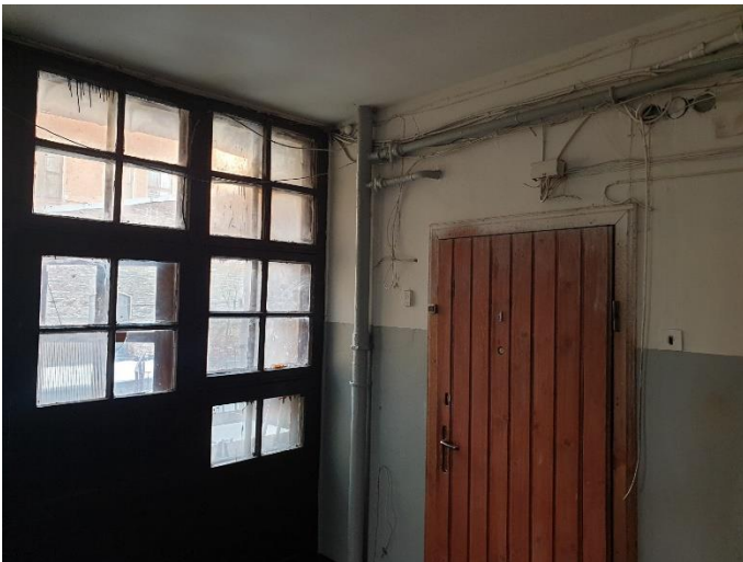
10. «Жилой дом акционерного общества «Калеваринне»», Ленинградская область, Выборгский район, г. Выборг, ул. Первомайская, д.2. Подъезд. Фрагмент. Фото 20.08.2022г.
