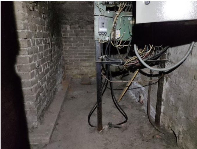
28. «Жилой дом акционерного общества «Калеваринне»», Ленинградская область, Выборгский район, г. Выборг, ул. Первомайская, д.2. Подвал. Фрагмент. Фото 20.08.2022г.
