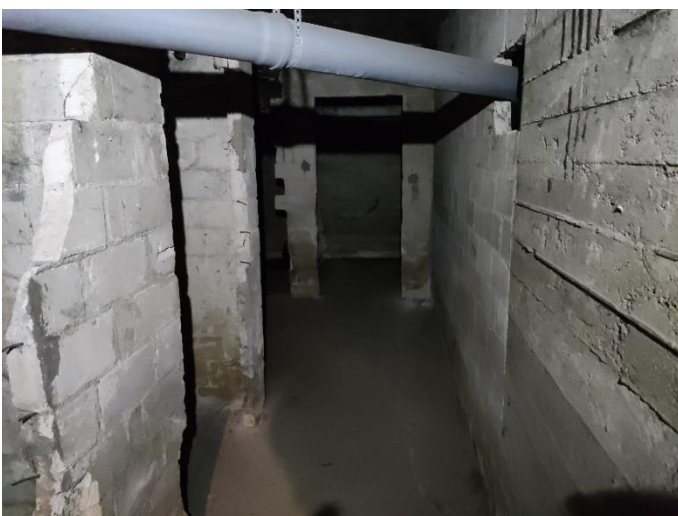
23. «Жилой дом акционерного общества «Калеваринне»», Ленинградская область, Выборгский район, г. Выборг, ул. Первомайская, д.2. Подвал. Фрагмент. Фото 20.08.2022г.
