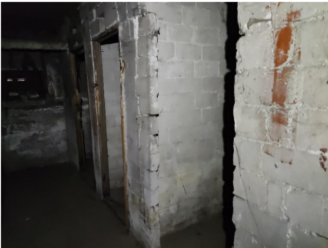
25. «Жилой дом акционерного общества «Калеваринне»», Ленинградская область, Выборгский район, г. Выборг, ул. Первомайская, д.2. Подвал. Фрагмент. Фото 20.08.2022г.
