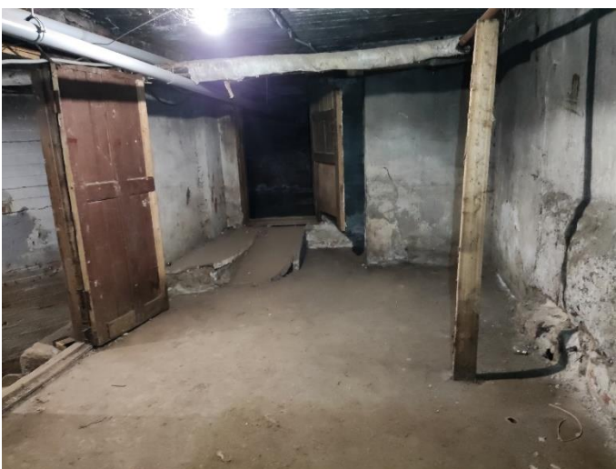
32. «Жилой дом акционерного общества «Калеваринне»», Ленинградская область, Выборгский район, г. Выборг, ул. Первомайская, д.2. Подвал. Фрагмент. Фото 20.08.2022г.
