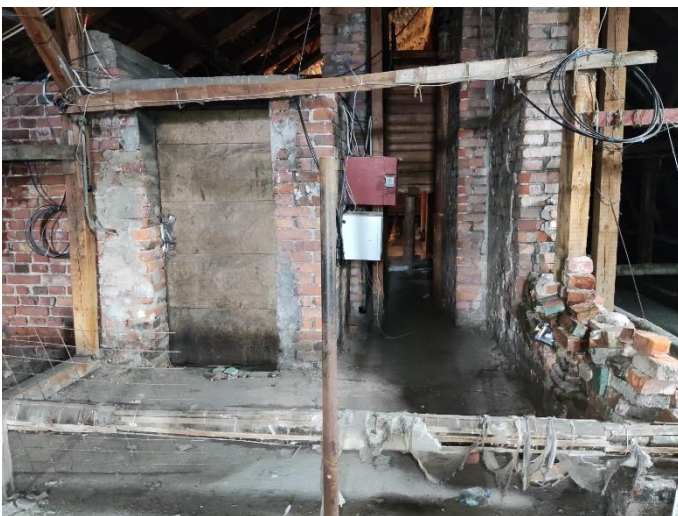
44. «Жилой дом акционерного общества «Калеваринне»», Ленинградская область, Выборгский район, г. Выборг, ул. Первомайская, д.2. Чердак. Фрагмент. Фото 20.08.2022г.
