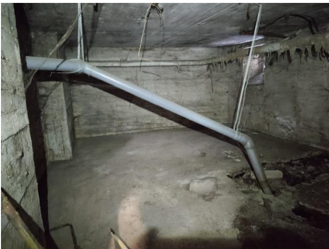
21. «Жилой дом акционерного общества «Калеваринне»», Ленинградская область, Выборгский район, г. Выборг, ул. Первомайская, д.2. Подвал. Фрагмент. Фото 20.08.2022г.
