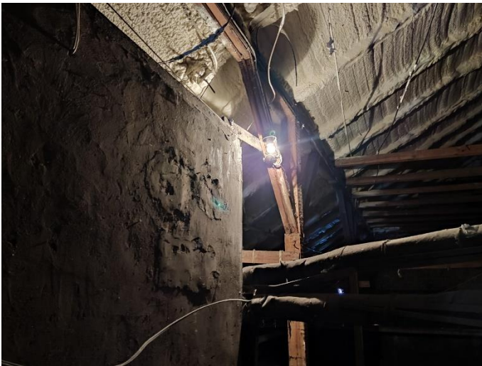
34. «Жилой дом акционерного общества «Калеваринне»», Ленинградская область, Выборгский район, г. Выборг, ул. Первомайская, д.2. Чердак. Фрагмент. Фото 20.08.2022г.
