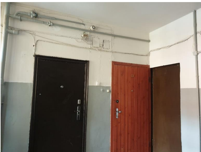
14. «Жилой дом акционерного общества «Калеваринне»», Ленинградская область, Выборгский район, г. Выборг, ул. Первомайская, д.2. Подъезд. Фрагмент. Фото 20.08.2022г.
