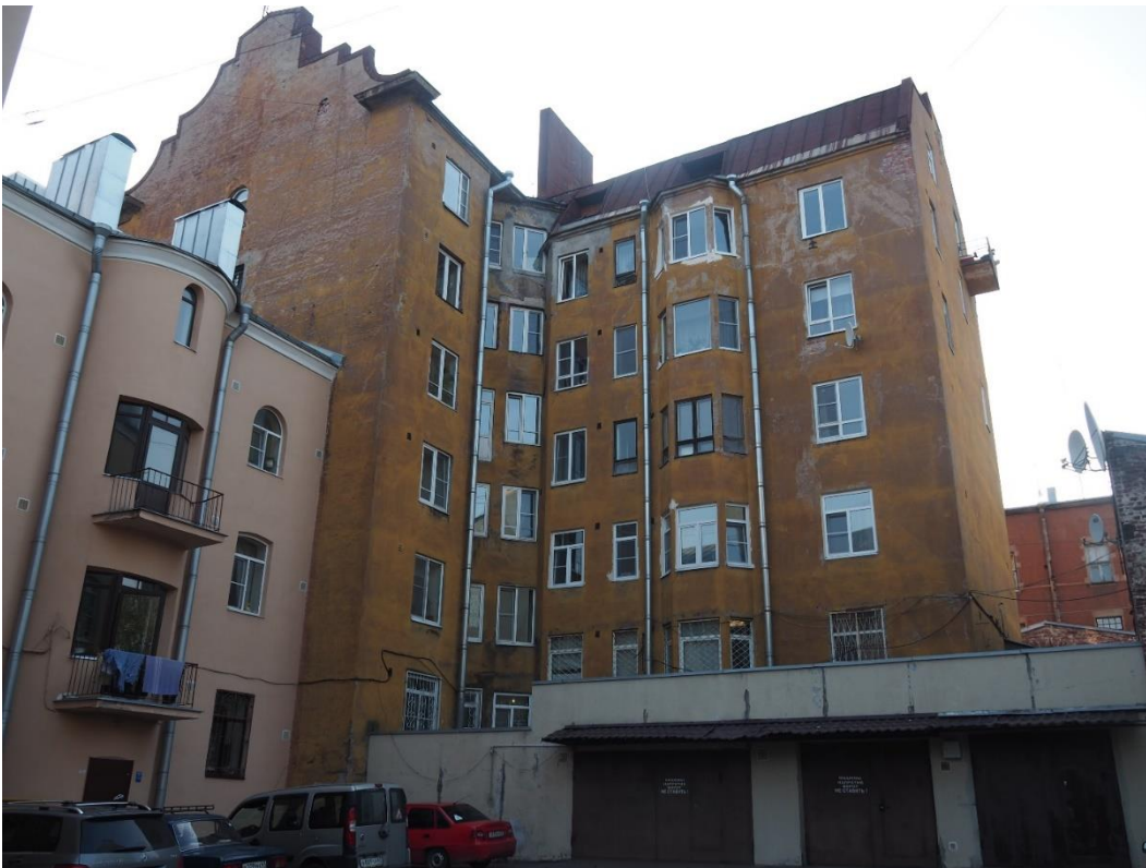
2. «Жилой дом акционерного общества «Калеваринне»», Ленинградская область, Выборгский район, г. Выборг, ул. Первомайская, д.2. Дворовый фасад. Общий вид с севера. Фото 20.08.2022г.
