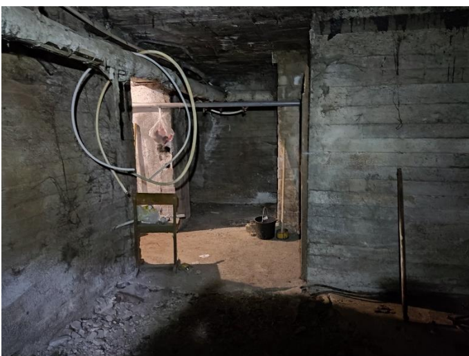
22. «Жилой дом акционерного общества «Калеваринне»», Ленинградская область, Выборгский район, г. Выборг, ул. Первомайская, д.2. Подвал. Фрагмент. Фото 20.08.2022г.
