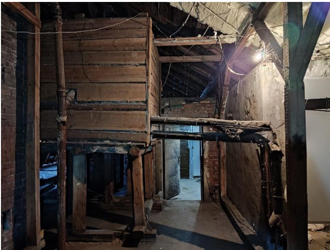
46. «Жилой дом акционерного общества «Калеваринне»», Ленинградская область, Выборгский район, г. Выборг, ул. Первомайская, д.2. Чердак. Фрагмент. Фото 20.08.2022г.
