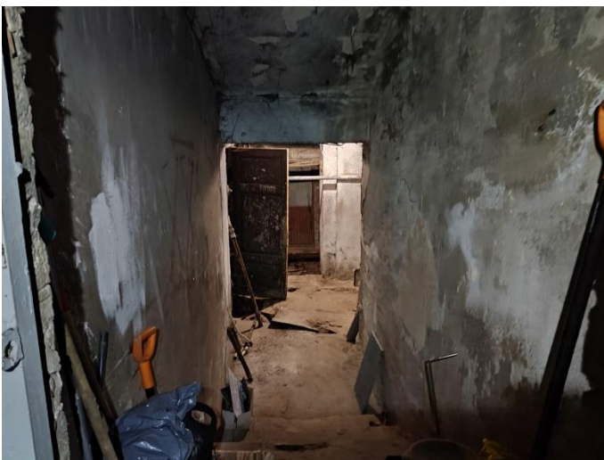
20. «Жилой дом акционерного общества «Калеваринне»», Ленинградская область, Выборгский район, г. Выборг, ул. Первомайская, д.2. Подвал. Общий вид. Фото 20.08.2022г.
