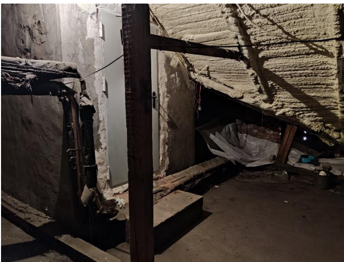
35. «Жилой дом акционерного общества «Калеваринне»», Ленинградская область, Выборгский район, г. Выборг, ул. Первомайская, д.2. Чердак. Фрагмент. Фото 20.08.2022г.
