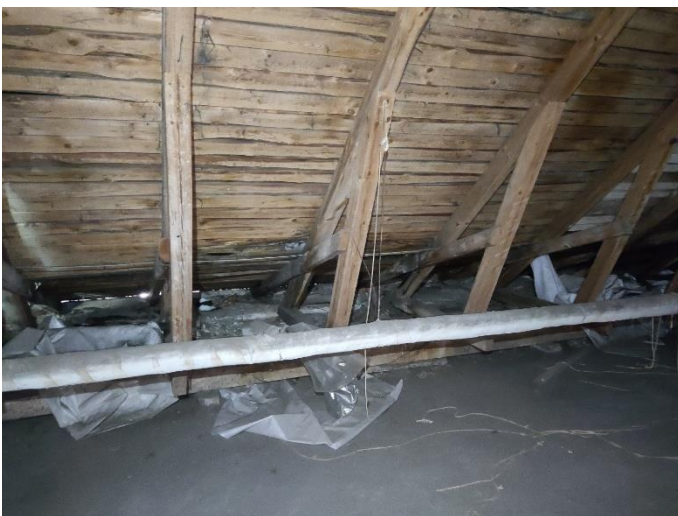
38. «Жилой дом акционерного общества «Калеваринне»», Ленинградская область, Выборгский район, г. Выборг, ул. Первомайская, д.2. Чердак. Фрагмент. Фото 20.08.2022г.
