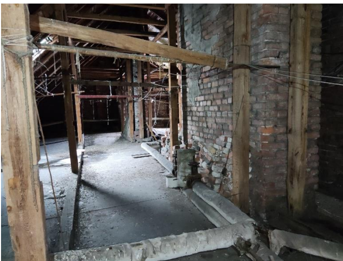
41. «Жилой дом акционерного общества «Калеваринне»», Ленинградская область, Выборгский район, г. Выборг, ул. Первомайская, д.2. Чердак. Фрагмент. Фото 20.08.2022г.
