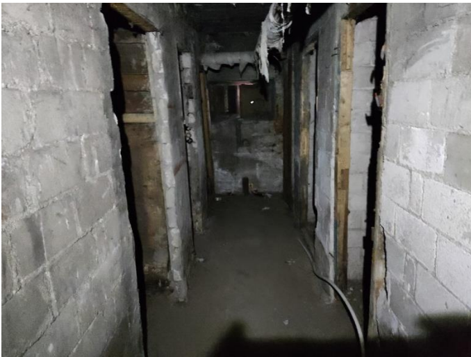
27. «Жилой дом акционерного общества «Калеваринне»», Ленинградская область, Выборгский район, г. Выборг, ул. Первомайская, д.2. Подвал. Фрагмент. Фото 20.08.2022г.
