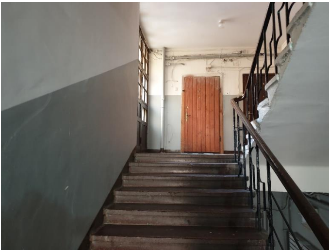
9. «Жилой дом акционерного общества «Калеваринне»», Ленинградская область, Выборгский район, г. Выборг, ул. Первомайская, д.2. Подъезд. Фрагмент. Фото 20.08.2022г.
