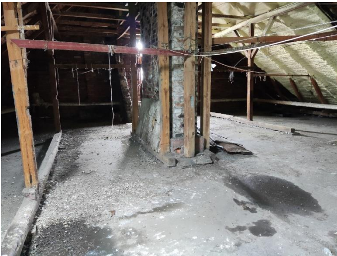
43. «Жилой дом акционерного общества «Калеваринне»», Ленинградская область, Выборгский район, г. Выборг, ул. Первомайская, д.2. Чердак. Фрагмент. Фото 20.08.2022г.
