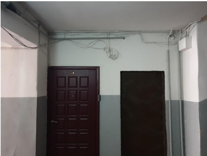
7. «Жилой дом акционерного общества «Калеваринне»», Ленинградская область, Выборгский район, г. Выборг, ул. Первомайская, д.2. Подъезд. Фрагмент. Фото 20.08.2022г.
