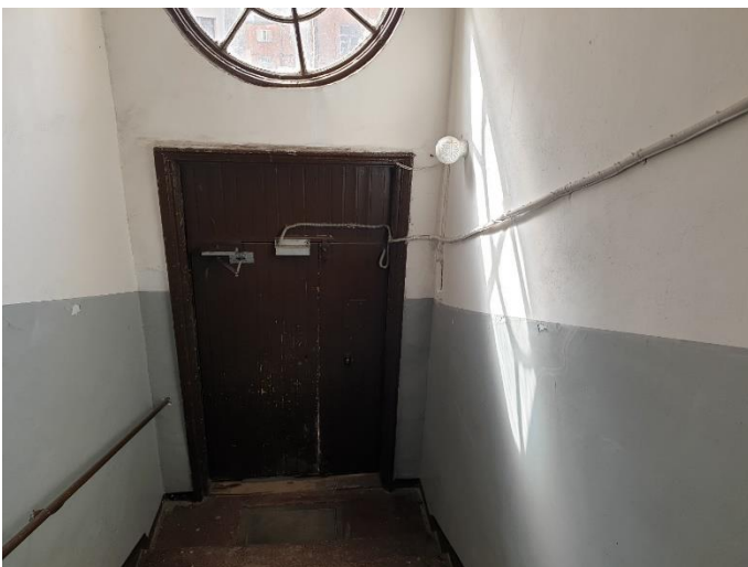
5. «Жилой дом акционерного общества «Калеваринне»», Ленинградская область, Выборгский район, г. Выборг, ул. Первомайская, д.2. Подъезд. Фрагмент. Фото 20.08.2022г.
