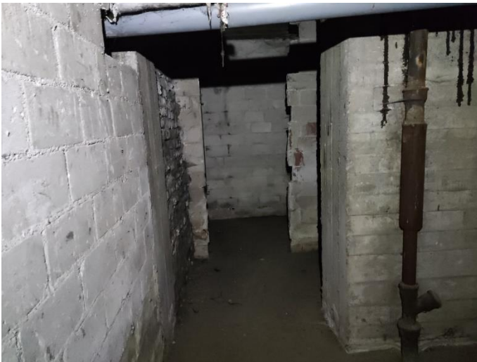
24. «Жилой дом акционерного общества «Калеваринне»», Ленинградская область, Выборгский район, г. Выборг, ул. Первомайская, д.2. Подвал. Фрагмент. Фото 20.08.2022г.
