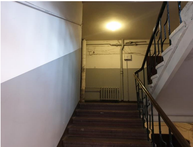
15. «Жилой дом акционерного общества «Калеваринне»», Ленинградская область, Выборгский район, г. Выборг, ул. Первомайская, д.2. Подъезд. Фрагмент. Фото 20.08.2022г.
