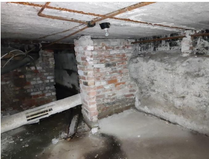
41. «Жилой дом», Ленинградская область, Выборгский район, г. Выборг, пр. Суворова, д.3. Подвал. Фрагмент. Фото 20.08.2022г.
