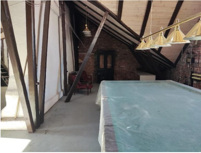
47. «Жилой дом», Ленинградская область, Выборгский район, г. Выборг, пр. Суворова, д.3. Чердак. Фрагмент. Фото 20.08.2022г.
