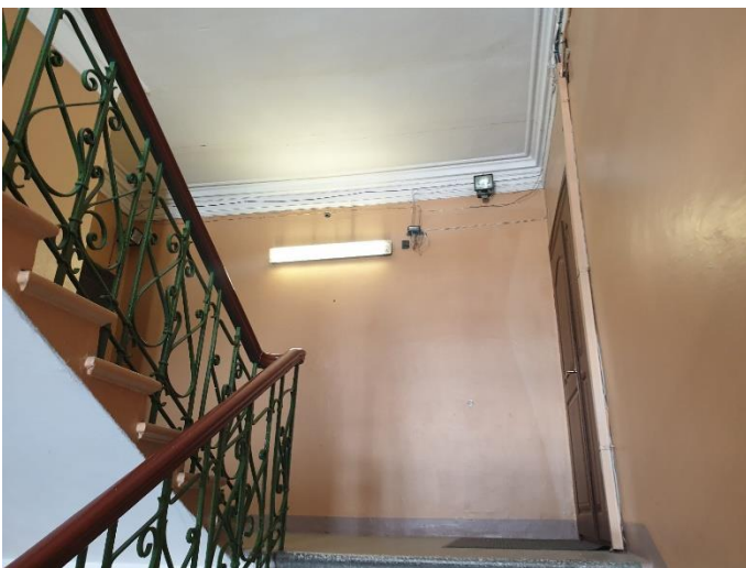
8. «Жилой дом», Ленинградская область, Выборгский район, г. Выборг, пр. Суворова, д.3. Подъезд №1. Фрагмент. Фото 20.08.2022г.
