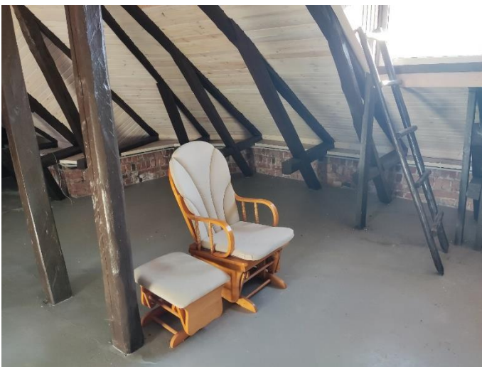
49. «Жилой дом», Ленинградская область, Выборгский район, г. Выборг, пр. Суворова, д.3. Чердак. Фрагмент. Фото 20.08.2022г.
