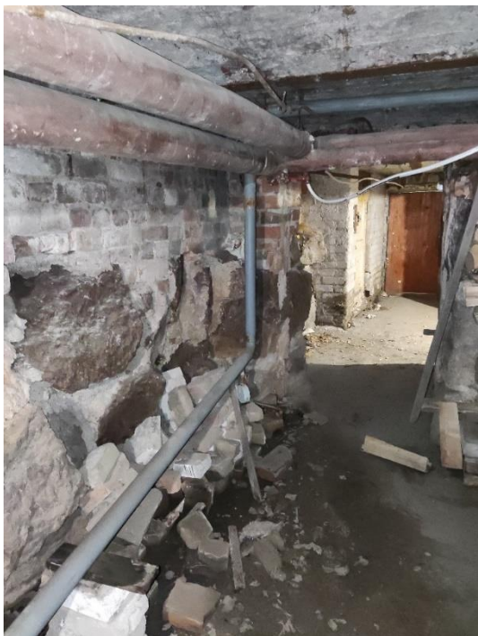
31. «Жилой дом», Ленинградская область, Выборгский район, г. Выборг, пр. Суворова, д.3. Подвал. Фрагмент. Фото 20.08.2022г.
