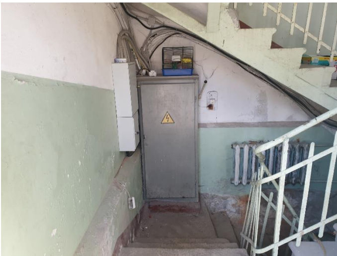
10. «Жилой дом», Ленинградская область, Выборгский район, г. Выборг, пр. Суворова, д.3. Подъезд №2. Общий вид. Фото 20.08.2022г.
