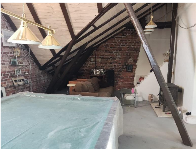
46. «Жилой дом», Ленинградская область, Выборгский район, г. Выборг, пр. Суворова, д.3. Чердак. Общий вид. Фото 20.08.2022г.
