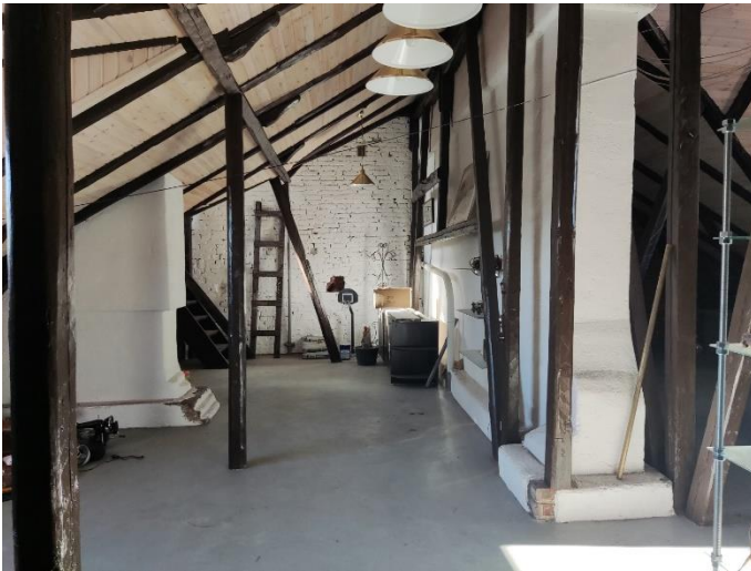
48. «Жилой дом», Ленинградская область, Выборгский район, г. Выборг, пр. Суворова, д.3. Чердак. Фрагмент. Фото 20.08.2022г.
