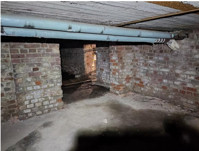
44. «Жилой дом», Ленинградская область, Выборгский район, г. Выборг, пр. Суворова, д.3. Подвал. Фрагмент. Фото 20.08.2022г.
