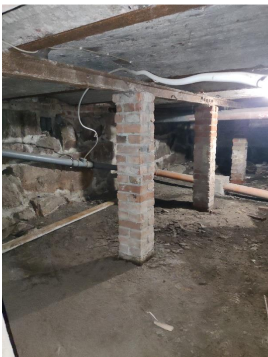
32. «Жилой дом», Ленинградская область, Выборгский район, г. Выборг, пр. Суворова, д.3. Подвал. Фрагмент. Фото 20.08.2022г.
