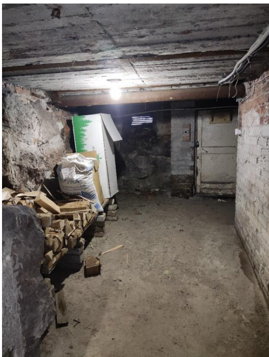
34. «Жилой дом», Ленинградская область, Выборгский район, г. Выборг, пр. Суворова, д.3. Подвал. Фрагмент. Фото 20.08.2022г.
