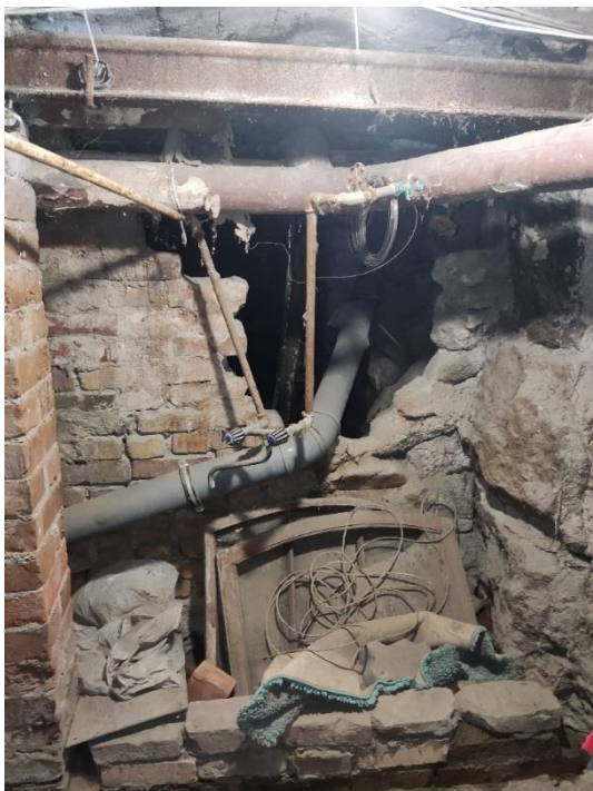
35. «Жилой дом», Ленинградская область, Выборгский район, г. Выборг, пр. Суворова, д.3. Подвал. Фрагмент. Фото 20.08.2022г.
