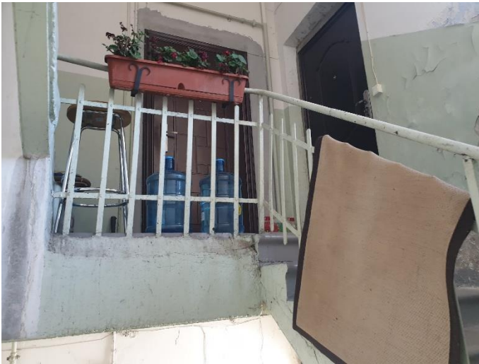
13. «Жилой дом», Ленинградская область, Выборгский район, г. Выборг, пр. Суворова, д.3. Подъезд №2. Фрагмент. Фото 20.08.2022г.
