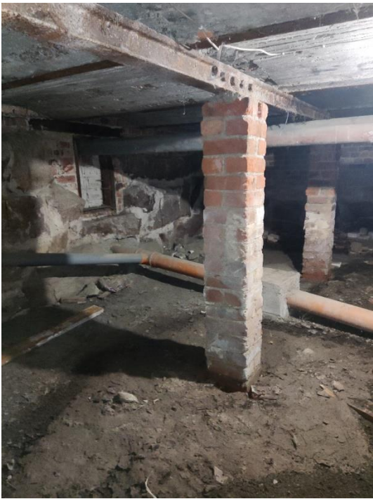
29. «Жилой дом», Ленинградская область, Выборгский район, г. Выборг, пр. Суворова, д.3. Подвал. Общий вид. Фото 20.08.2022г.
