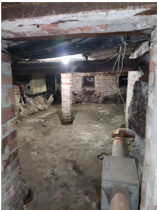
36. «Жилой дом», Ленинградская область, Выборгский район, г. Выборг, пр. Суворова, д.3. Подвал. Фрагмент. Фото 20.08.2022г.
