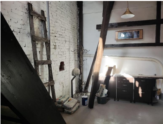
52. «Жилой дом», Ленинградская область, Выборгский район, г. Выборг, пр. Суворова, д.3. Чердак. Фрагмент. Фото 20.08.2022г.
