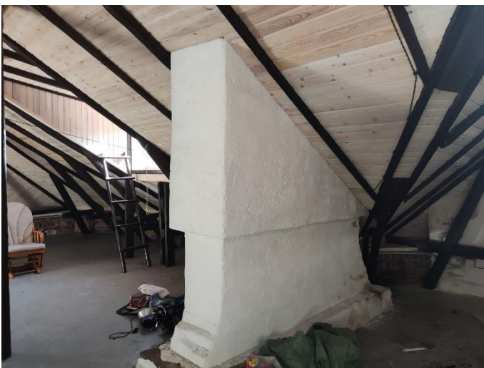
54. «Жилой дом», Ленинградская область, Выборгский район, г. Выборг, пр. Суворова, д.3. Чердак. Фрагмент. Фото 20.08.2022г.
