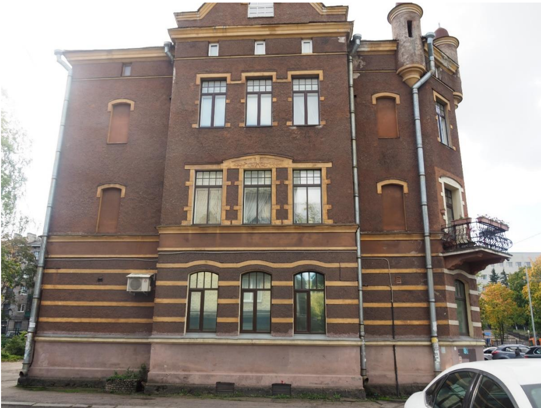
2. «Жилой дом», Ленинградская область, Выборгский район, г. Выборг, пр. Суворова, д.3. Северо-восточный фасад. Общий вид. Фото 20.08.2022г.
