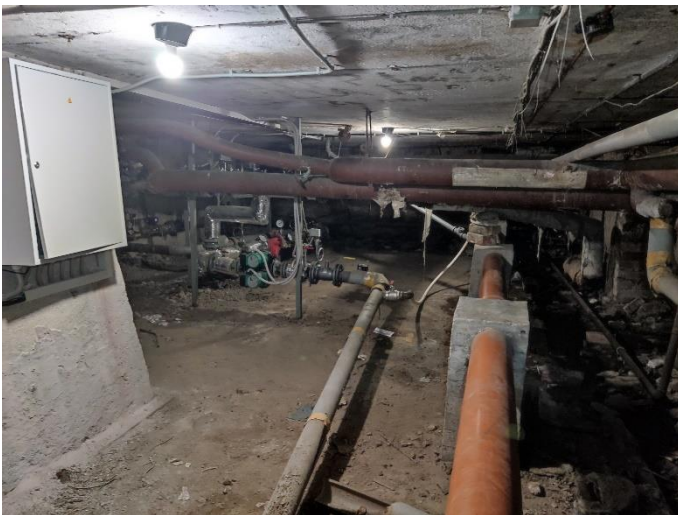
45. «Жилой дом», Ленинградская область, Выборгский район, г. Выборг, пр. Суворова, д.3. Подвал. Фрагмент. Фото 20.08.2022г.
