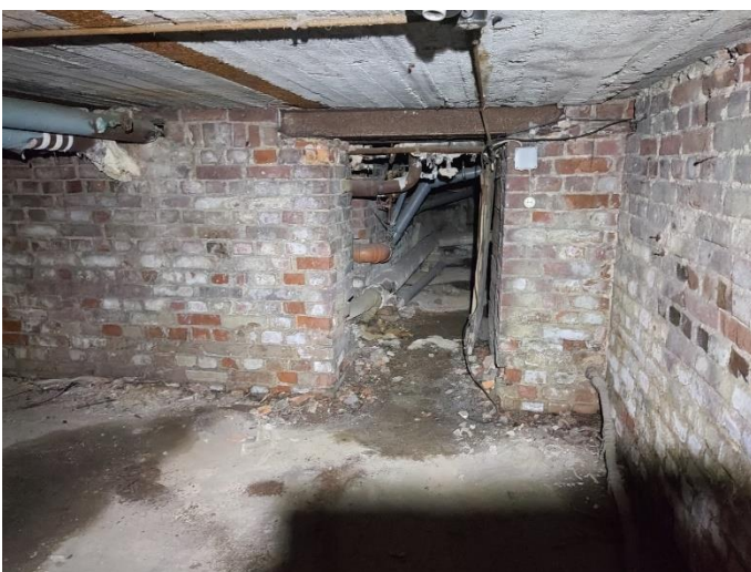
43. «Жилой дом», Ленинградская область, Выборгский район, г. Выборг, пр. Суворова, д.3. Подвал. Фрагмент. Фото 20.08.2022г.
