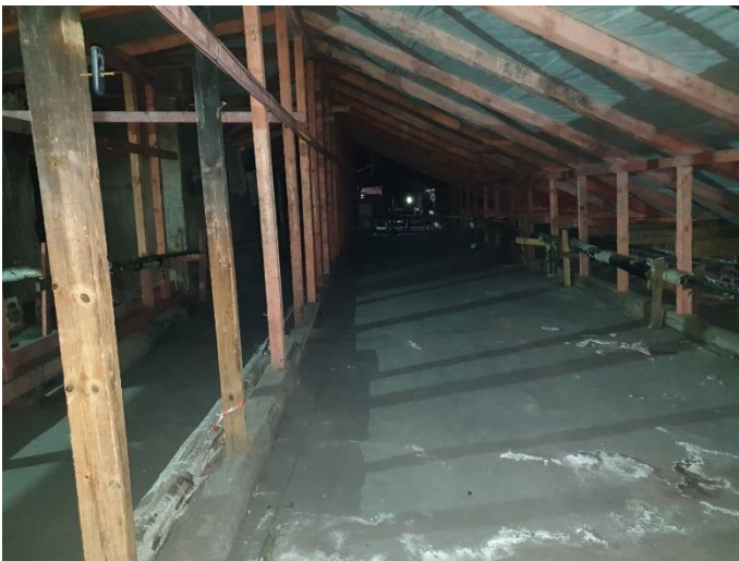
34. «Губернский почтовый дом», Ленинградская область, Выборгский район, г. Выборг, ул. Крепостная, д.3. Чердак. Общий вид. Фото 20.08.2022г.
