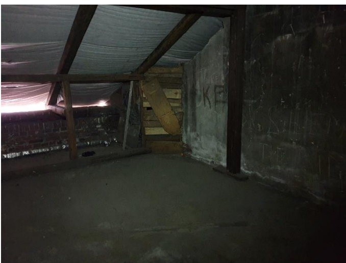
29. «Губернский почтовый дом», Ленинградская область, Выборгский район, г. Выборг, ул. Крепостная, д.3. Чердак. Общий вид. Фото 20.08.2022г.
