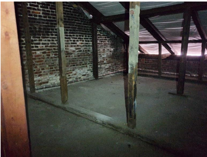
28. «Губернский почтовый дом», Ленинградская область, Выборгский район, г. Выборг, ул. Крепостная, д.3. Чердак. Общий вид. Фото 20.08.2022г.
