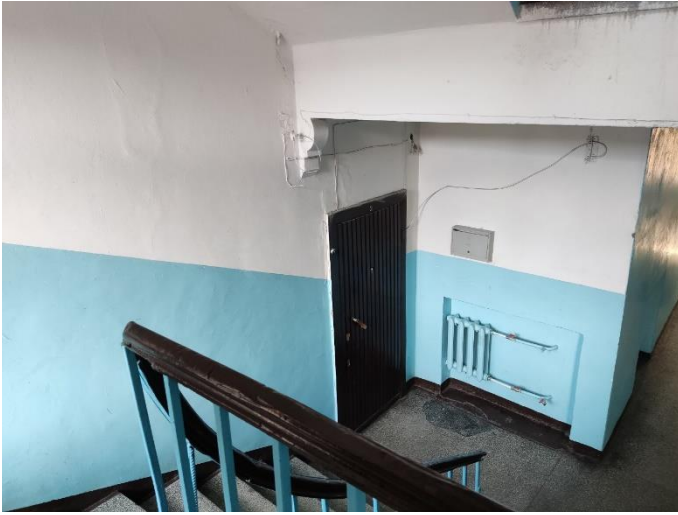
15. «Губернский почтовый дом», Ленинградская область, Выборгский район, г. Выборг, ул. Крепостная, д.3. Подъезд №2. Фрагмент. Фото 20.08.2022г.
