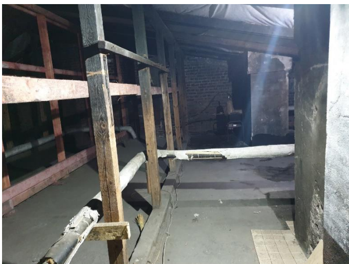
30. «Губернский почтовый дом», Ленинградская область, Выборгский район, г. Выборг, ул. Крепостная, д.3. Чердак. Общий вид. Фото 20.08.2022г.
