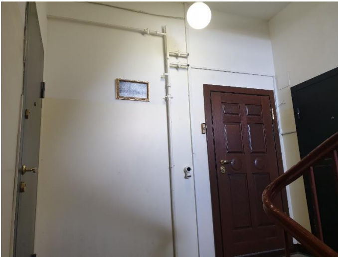
10. «Губернский почтовый дом», Ленинградская область, Выборгский район, г. Выборг, ул. Крепостная, д.3. Подъезд №1. Фрагмент. Фото 20.08.2022г.
