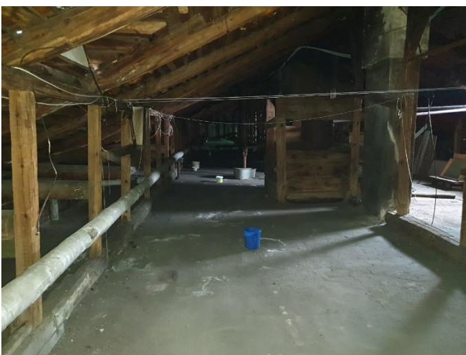
38. «Губернский почтовый дом», Ленинградская область, Выборгский район, г. Выборг, ул. Крепостная, д.3. Чердак. Общий вид. Фото 20.08.2022г.
