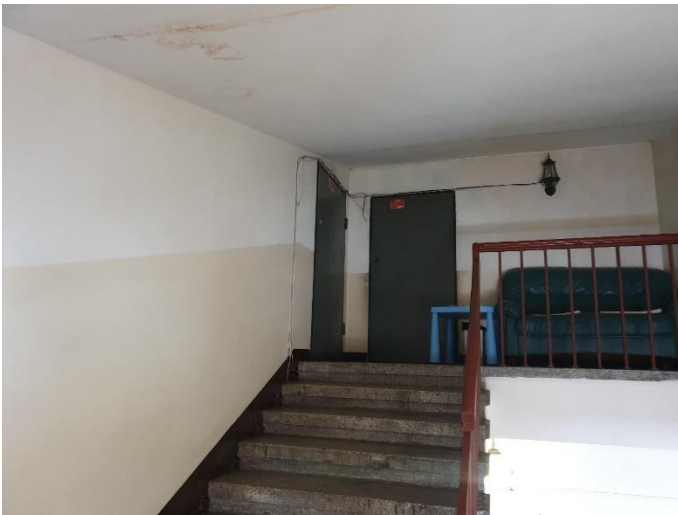
12. «Губернский почтовый дом», Ленинградская область, Выборгский район, г. Выборг, ул. Крепостная, д.3. Подъезд №1. Фрагмент. Фото 20.08.2022г.
