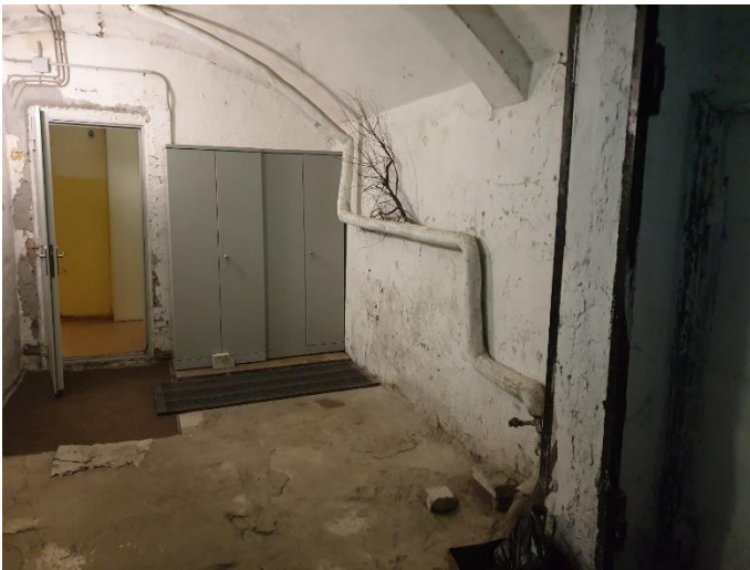
24. «Губернский почтовый дом», Ленинградская область, Выборгский район, г. Выборг, ул. Крепостная, д.3. Подвал. Фрагмент. Фото 20.08.2022г.
