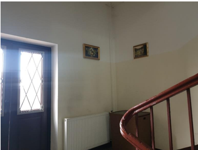
7. «Губернский почтовый дом», Ленинградская область, Выборгский район, г. Выборг, ул. Крепостная, д.3. Подъезд №1. Фрагмент. Фото 20.08.2022г.
