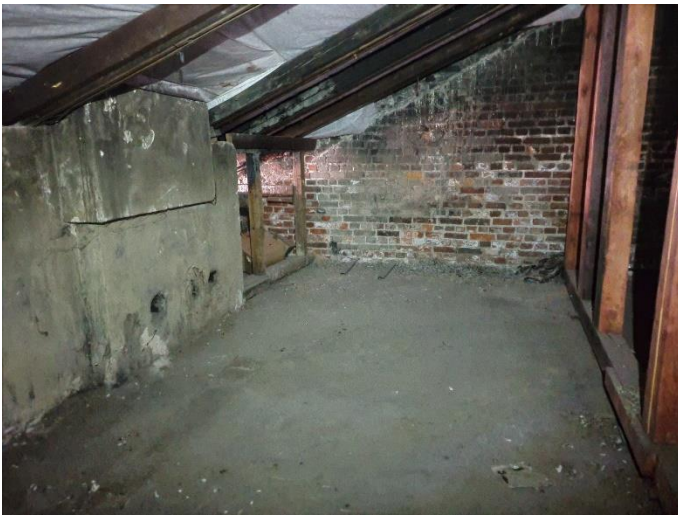
27. «Губернский почтовый дом», Ленинградская область, Выборгский район, г. Выборг, ул. Крепостная, д.3. Чердак. Общий вид. Фото 20.08.2022г.
