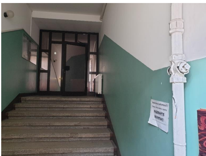
4. «Губернский почтовый дом», Ленинградская область, Выборгский район, г. Выборг, ул. Крепостная, д.3. Подъезд №1. Фрагмент. Фото 20.08.2022г.
