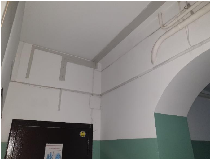
6. «Губернский почтовый дом», Ленинградская область, Выборгский район, г. Выборг, ул. Крепостная, д.3. Подъезд №1. Фрагмент. Фото 20.08.2022г.
