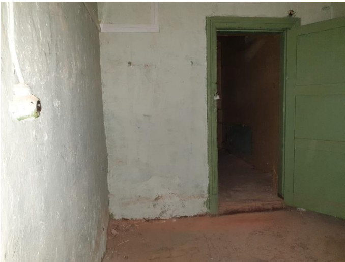
22. «Губернский почтовый дом», Ленинградская область, Выборгский район, г. Выборг, ул. Крепостная, д.3. Подвал. Фрагмент. Фото 20.08.2022г.
