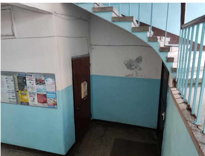
14. «Губернский почтовый дом», Ленинградская область, Выборгский район, г. Выборг, ул. Крепостная, д.3. Подъезд №2. Фрагмент. Фото 20.08.2022г.
