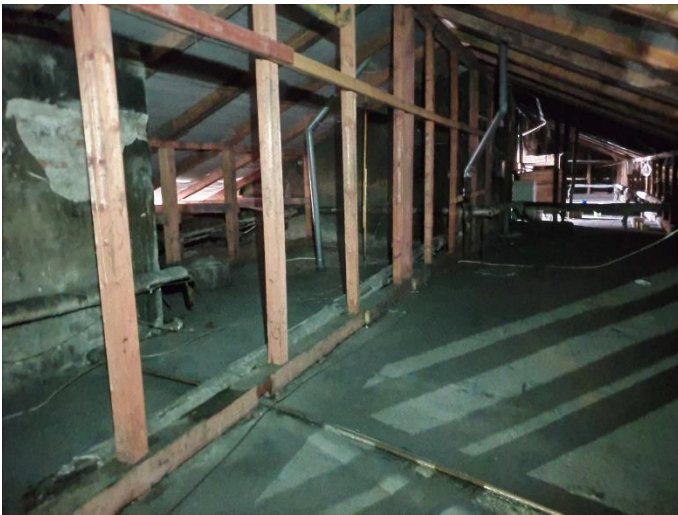
36. «Губернский почтовый дом», Ленинградская область, Выборгский район, г. Выборг, ул. Крепостная, д.3. Чердак. Общий вид. Фото 20.08.2022г.
