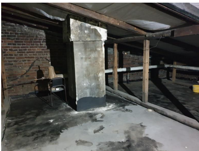
32. «Губернский почтовый дом», Ленинградская область, Выборгский район, г. Выборг, ул. Крепостная, д.3. Чердак. Общий вид. Фото 20.08.2022г.
